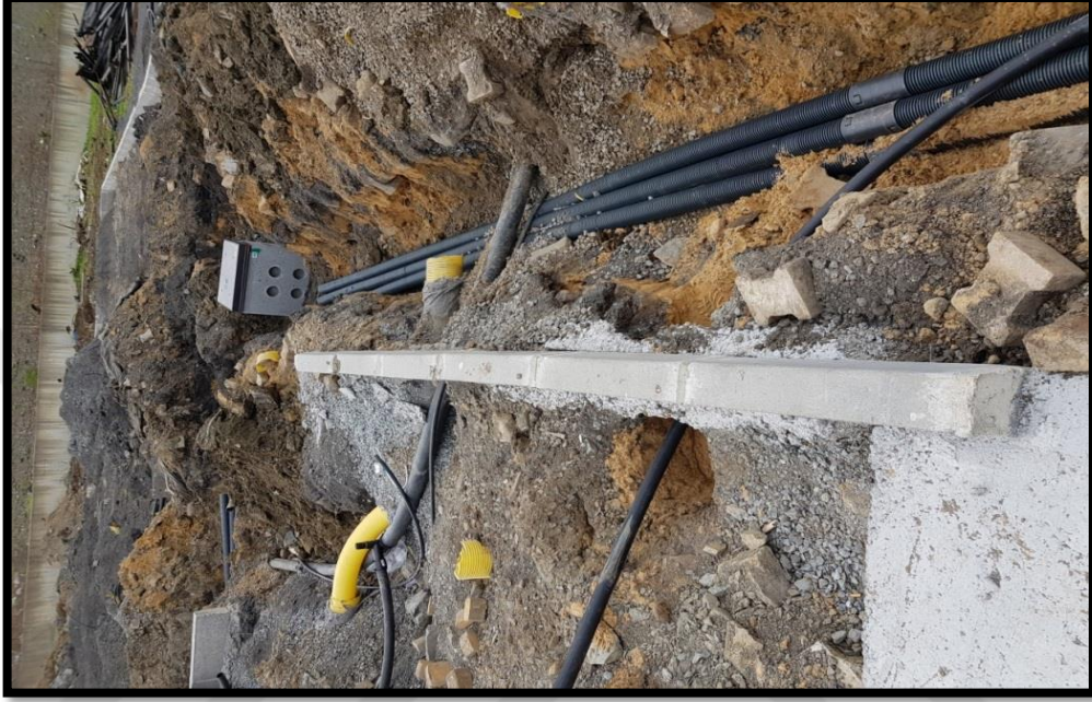
Resim 4.15. Elektrik tesisatı imalatı-2
