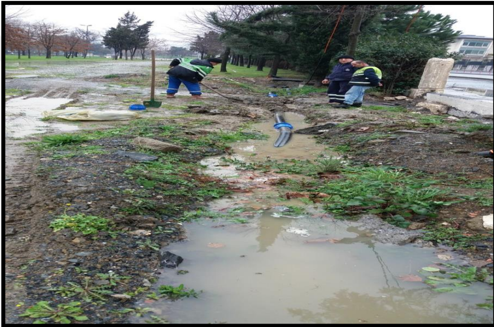
Resim 4.60. Yeşil alanlarda tesisat tamir –bakımı-1
