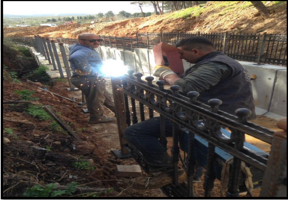
Resim 4.6.Ferforje montajı-1
