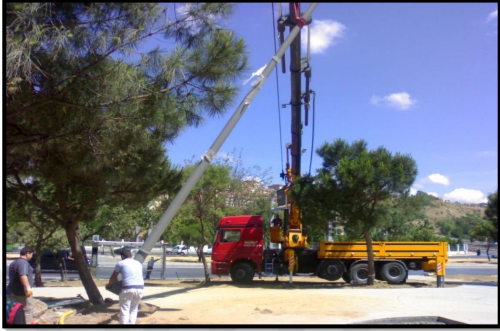
Resim 4.16. Elektrik tesisatı imalatı-3
