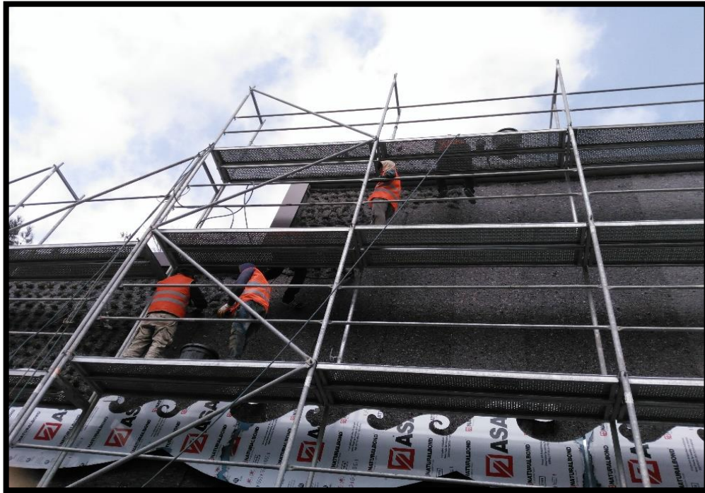
Resim 4.54. Duvar bahçe montaj çalışması
