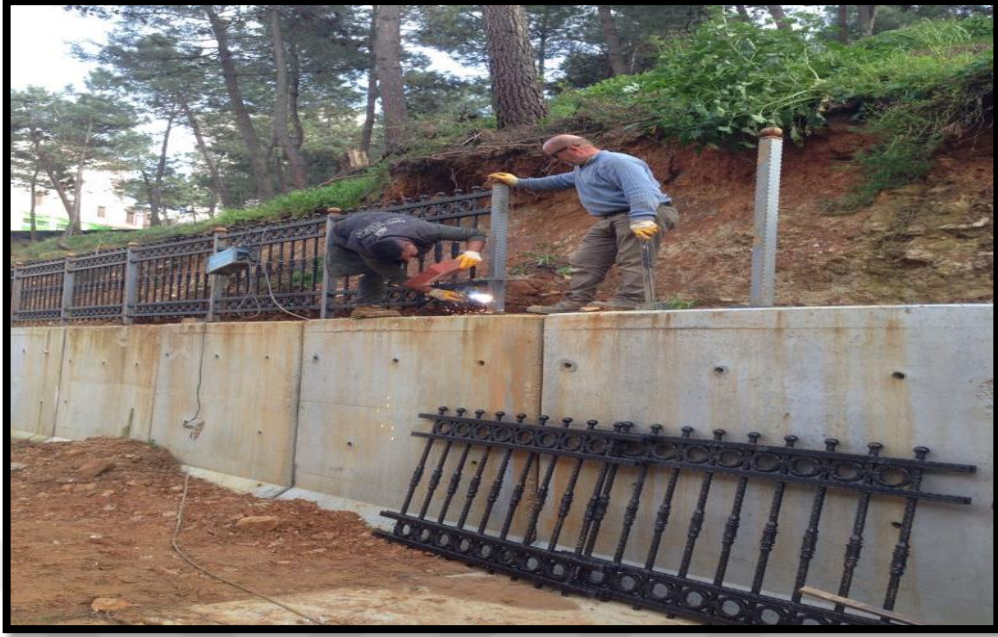
Resim 4.7.Ferforje montajı-2
