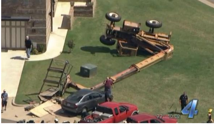
Resim 6 : YSİP Platform Zemin Vuruşu
