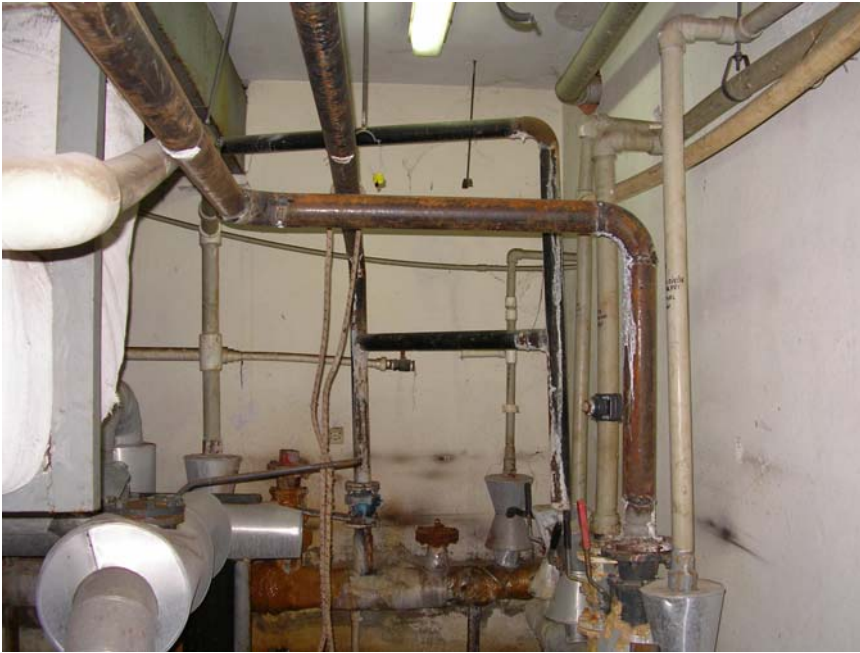
Şekil 6.42. Alangüllü termal tesisi kollektör bölümüne radon gazı ölçümleri için yerleştirilmiş Kodak LR 115 tip 2 katıhal iz kazıma dedektörü (Orijinal, Mayıs 2009)
