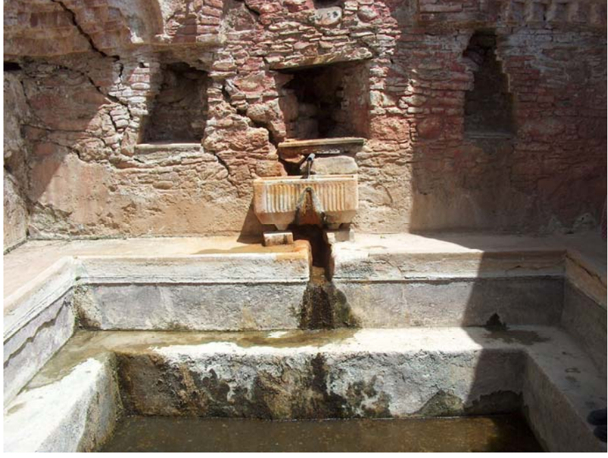
Şekil 6.15. Alangüllü Termal Tesisi Roma Hamamı jeotermal kaynağı (Orijinal, Mayıs 2007)
