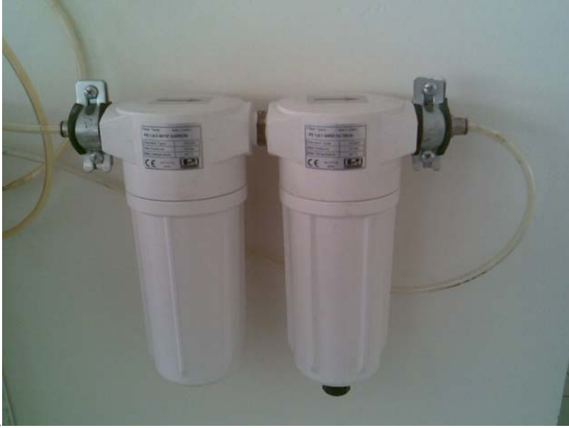
Resim 3.3 Havanın nemini gideren ve filtreleyen aparat.
