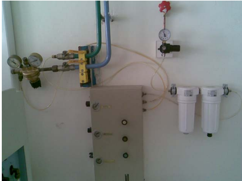
Resim 3.2 Mavi boru ile argon, yeşil boru ile azot gazı cihaza taşınmaktadır.
