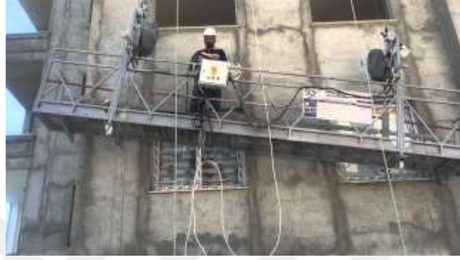
Şekil 12. Asma İskele Örneği
