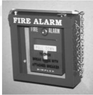
Şekil 29. Yangın alarm butonu
