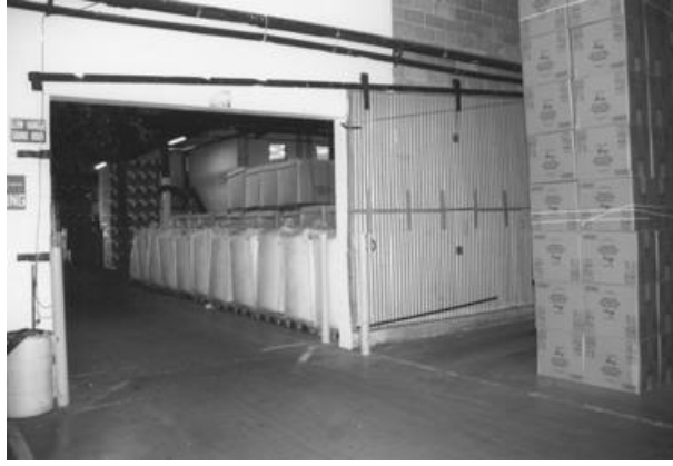
Şekil 28. Yangın Duvarı
