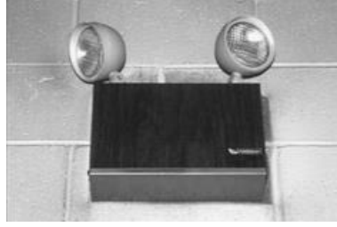
Şekil 41. Acil aydınlatma armatürü
