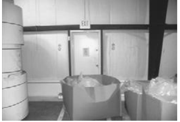
Şekil 39. Önü kapalı acil çıkış kapıları
