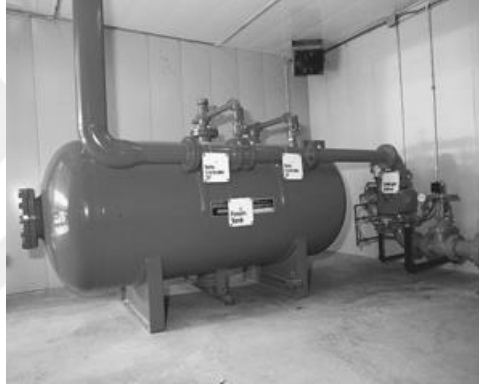
Şekil 36. Köpük tankı
