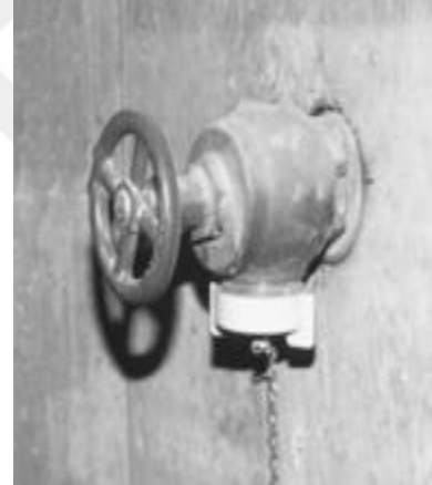
Şekil 32. Yangın vanası
