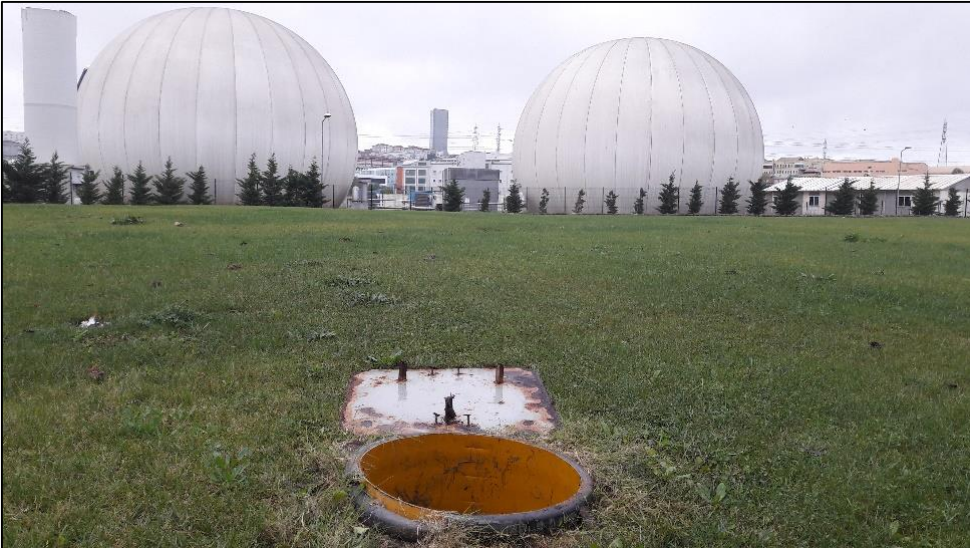
Resim 7: Gaz depolama tankları
