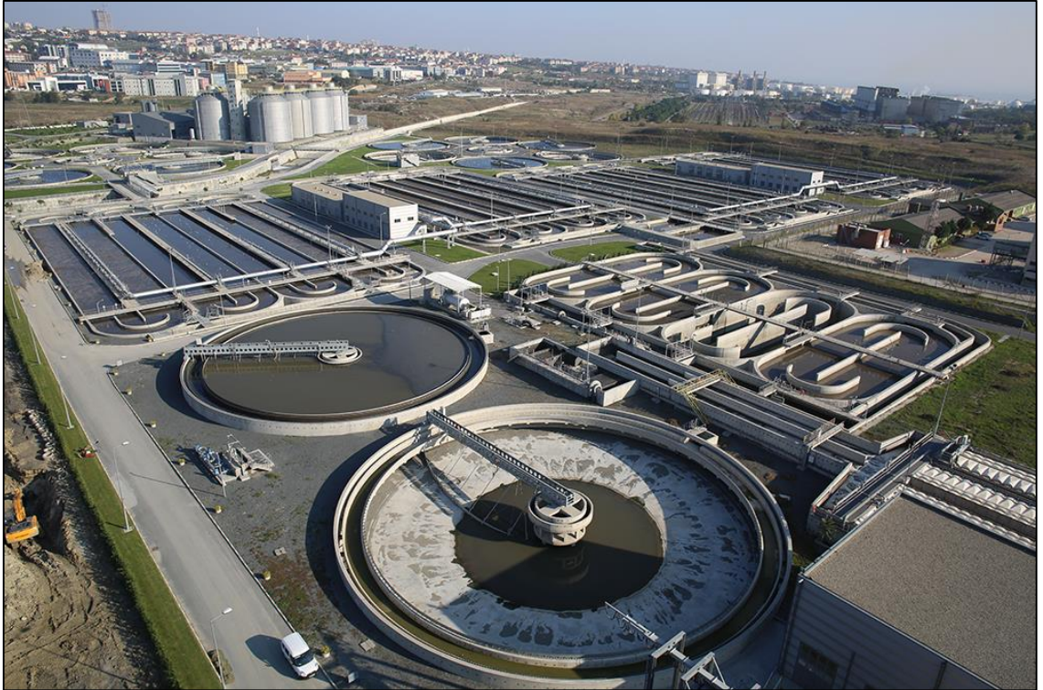
Resim 1: Ambarlı İleri Biyolojik Atıksu Arıtma Tesisi
