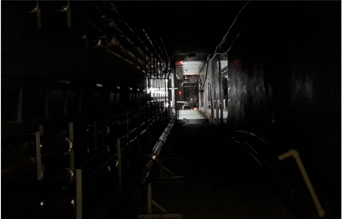
Resim 10: Ataköy İBAAT çamur ünitesinde bulunan flaşör sistemi
