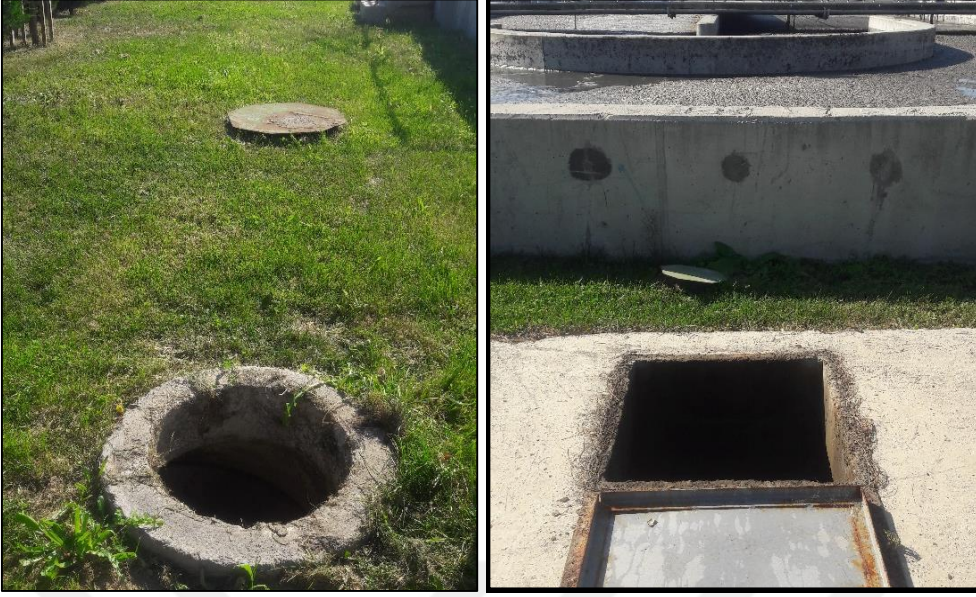
Resim 4: Havalandırma ünitesi vana odası
