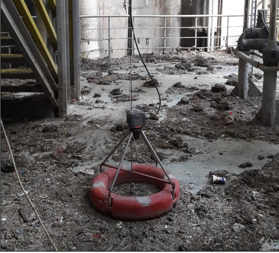
Resim 8: Terfi merkezi sabit hidrojen sülfür gazı dedektörü
