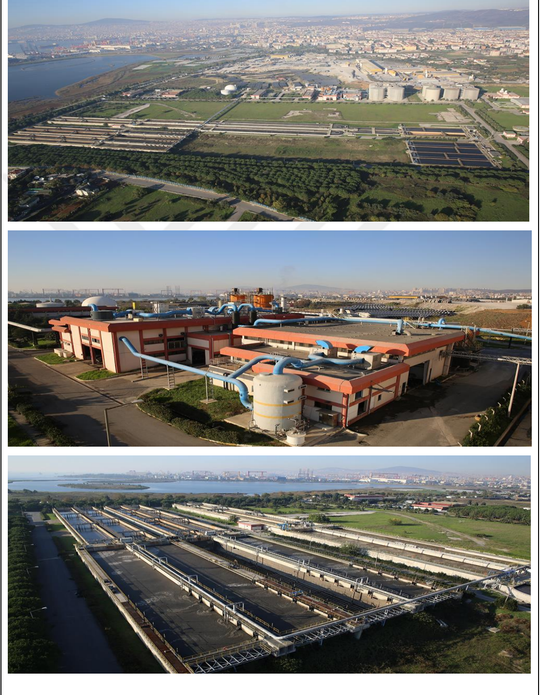
Resim 2: Tuzla İleri Biyolojik Atık Su Arıtma Tesisi
