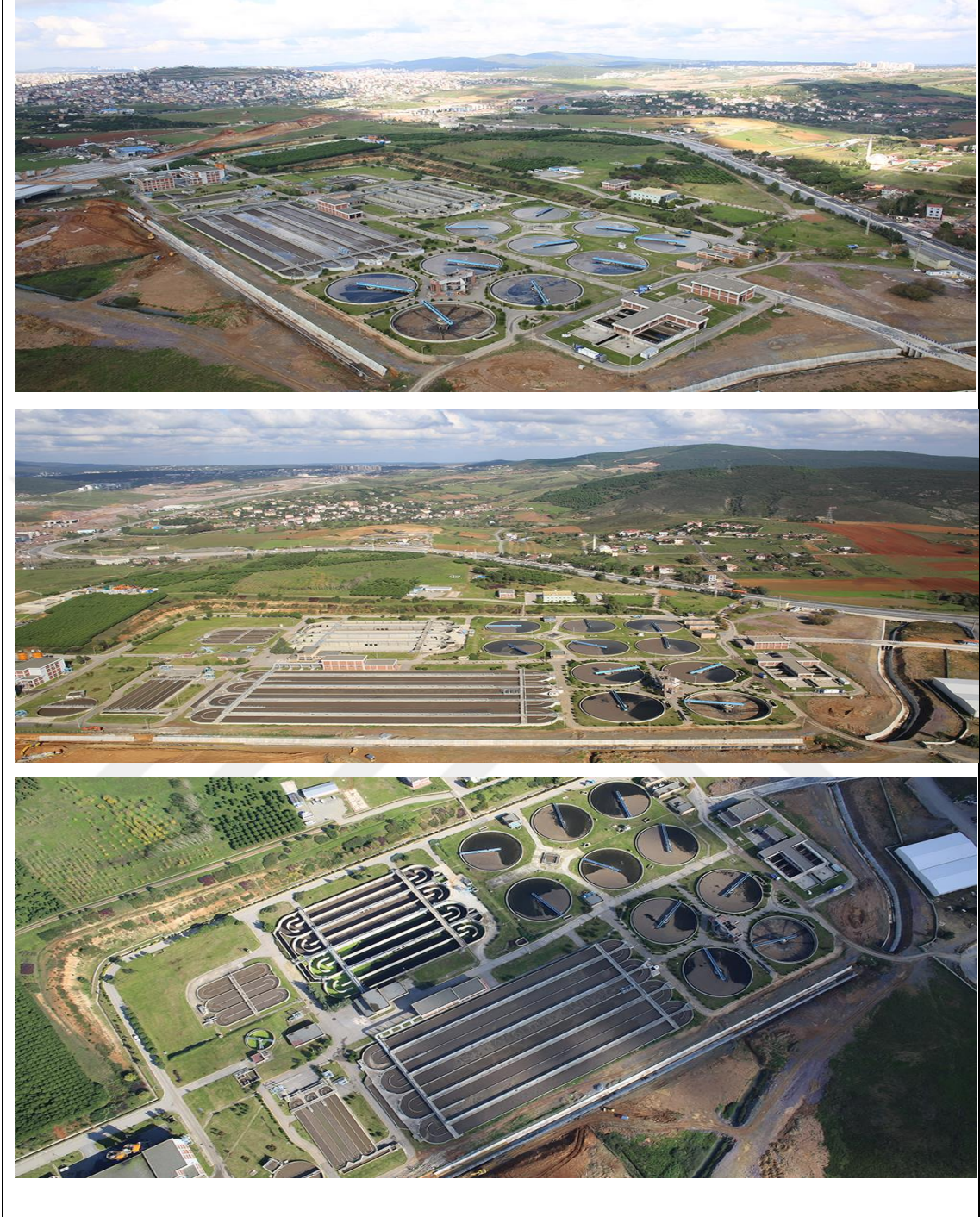
Resim 1: Paşaköy İleri Biyolojik Atık Su Arıtma Tesisi
