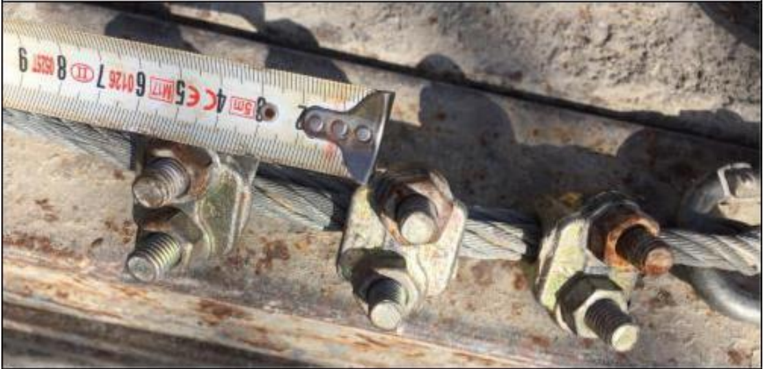
Şekil 20: Klemens kullanılarak sabitlenen çelik halat (2.7 cm)
