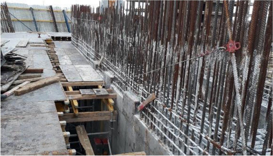
Şekil 122: Ankraj Testi Sonrası Demir Filizleri ve Askıda Kalan Yük Durumu
