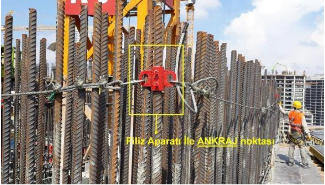
Şekil 22: Demir Filiz Ankraj Aparatı Kullanımı
