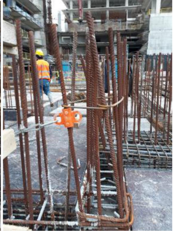
Sekil 80: 1.Ankraj Noktası Eğilme (12cm) Şekil 81: 2.Ankraj Noktası Eğilme (5cm)
