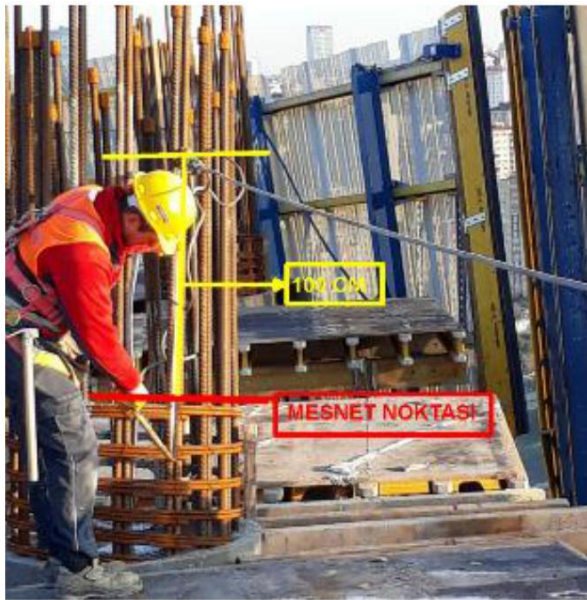
Şekil 56: 1.Ankraj Mesnet' e Uzaklığı
