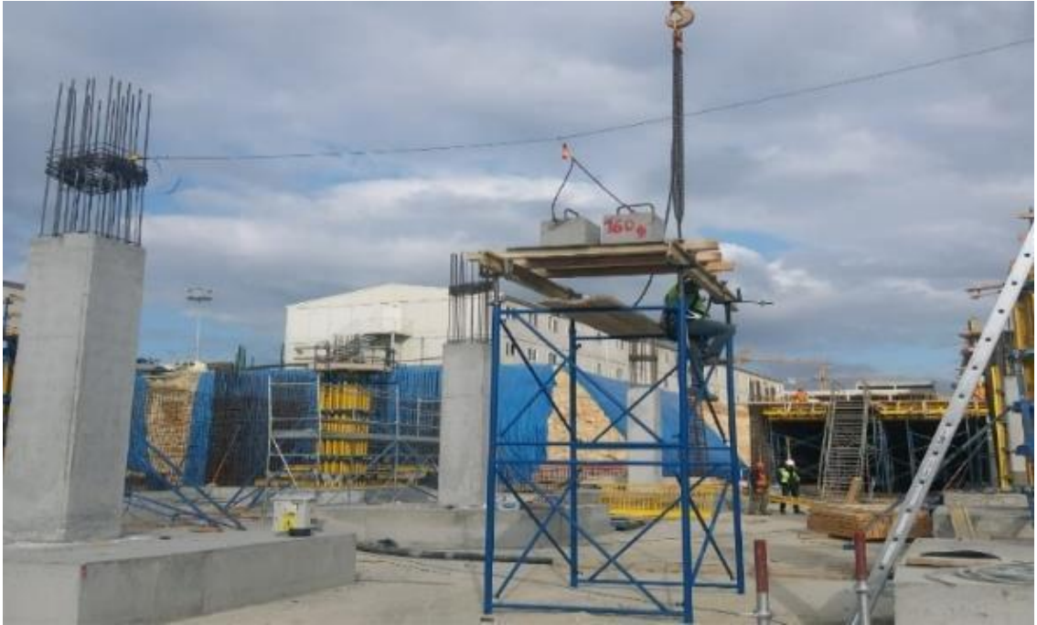
Şekil 39: Çapı 22 Olan Demir Filizi 4.Ankraj Testi Proje Çizimi Test Öncesi Görsel
