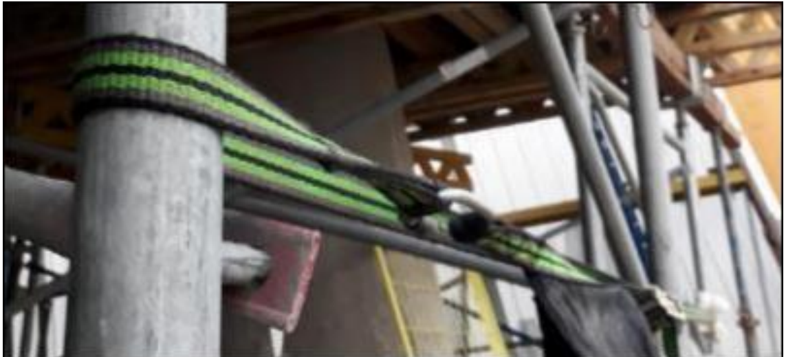
Şekil 4: Polyester Dokuma Yatay Yaşam Hattı Kurulum
