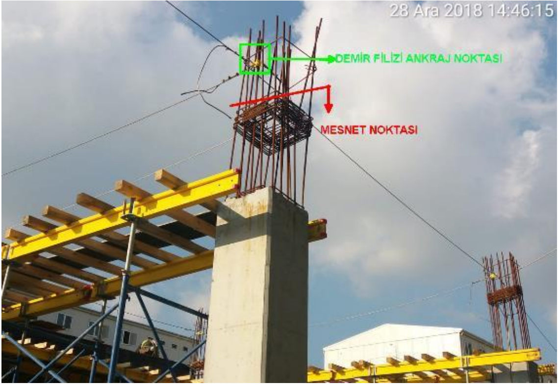
Şekil 28: Uygulamada Ankraj Mesafesinin Mesnet Noktasından Mecburi Uzaklığı
