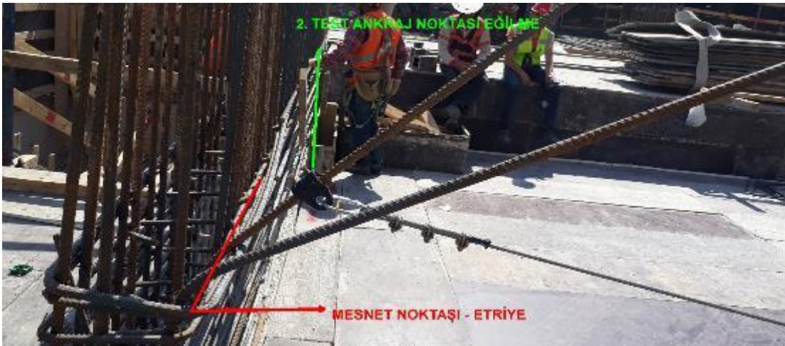
Şekil 75: 2.Ankraj Noktasında Yaşanan Eğilme
