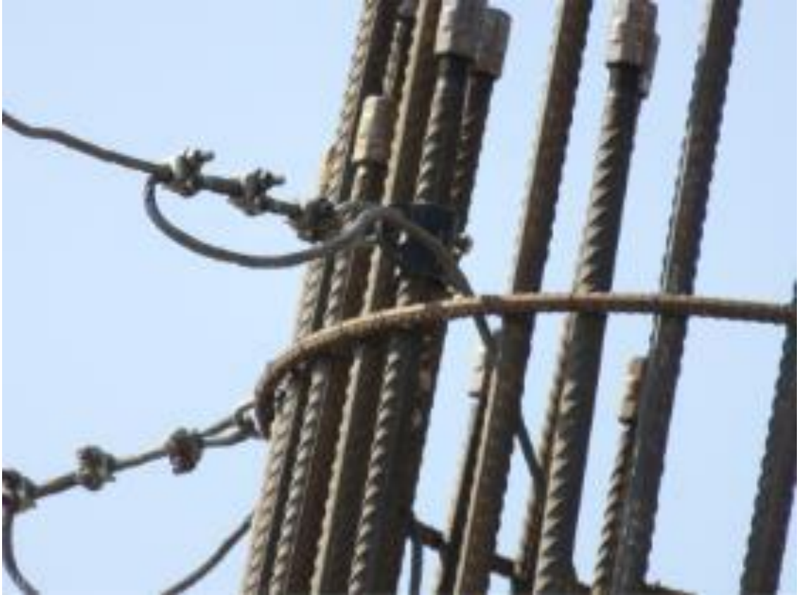
Şekil 126: 1. Ankraj Noktasında Alttan Etriye Kullanımı (Mesnet Noktası 0 cm)
