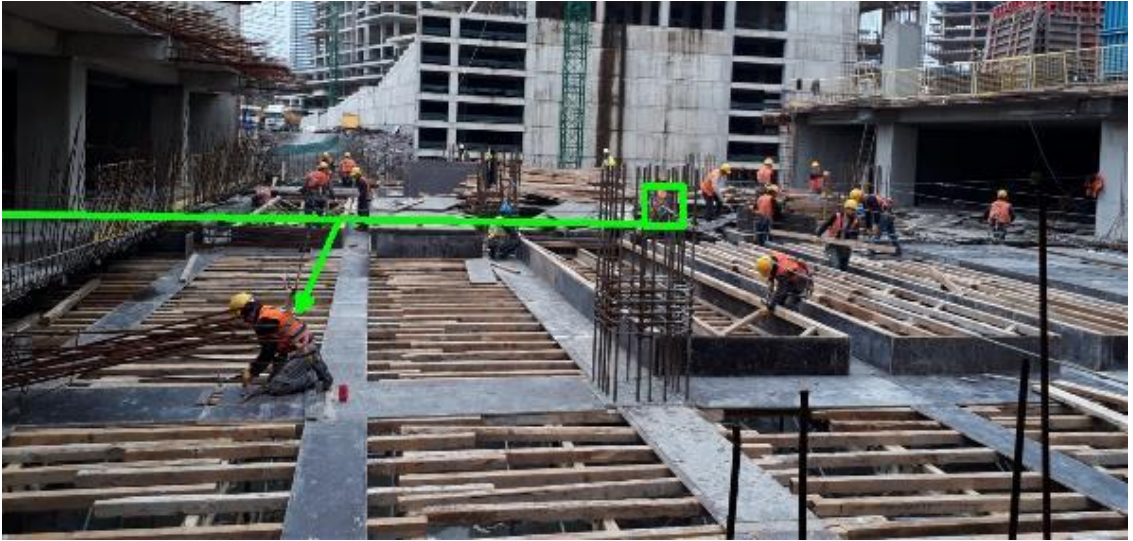
Şekil 27: Uygulamada Çalışma Pozisyonu ve Filiz Demirin Ankraj Mesafesi
