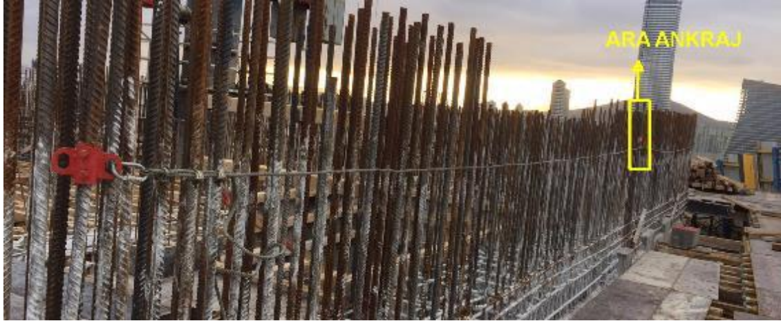
Şekil 59: Çapı 30 Olan Demir Filizi 3.Ankraj Testi Öncesi Mevcut Durum
