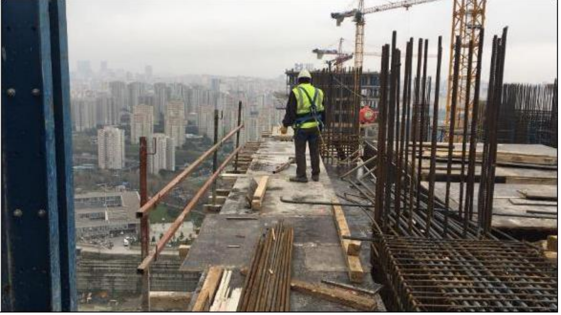
Şekil 18: Kaba Yapıda Statik Halat ile Kurulan Mobil Yaşam Hattı Örneği-2
