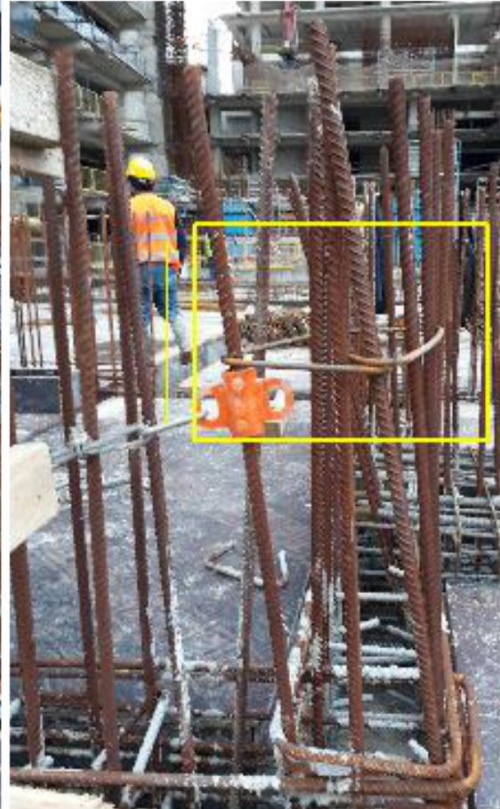
Şekil 136: Etriyleli Demir Filizi Testi
