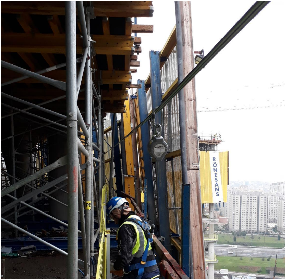
Şekil 15: Dokuma Halat ile kurulan Mobil Yaşam Hatları
