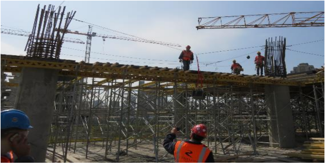
Şekil 128: Ankraj Testi Sonrası Demir Filizleri ve Askıda Kalan Yük Durumu
