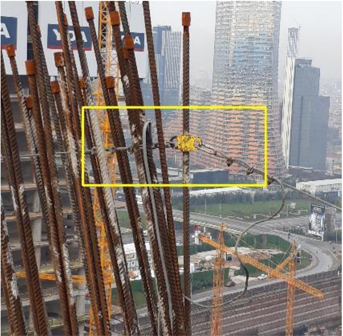
Şekil 137: Filiz Ankraj Aparatının Çift Kulaklı Olması ve Zıt Yönde 2. Yaşam Hattı
