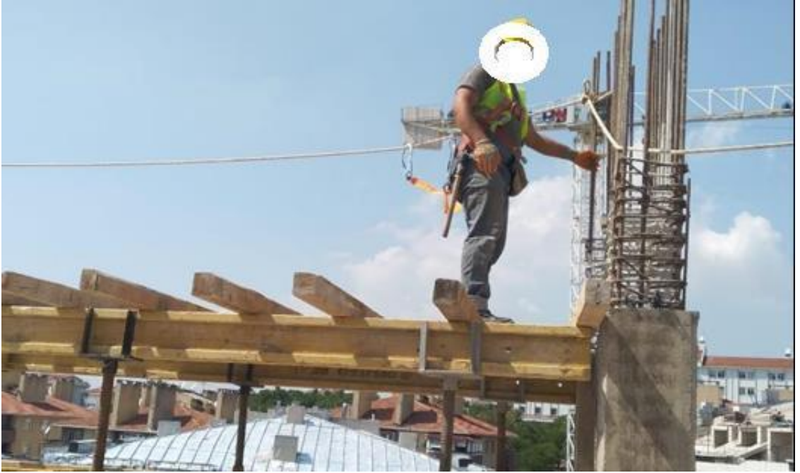
Şekil 17: Kaba Yapıda Statik Halat ile Kurulan Mobil Yaşam Hattı Örneği-1
