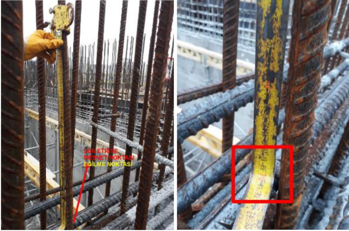
Şekil 45: Demir filizin mesnet noktası
