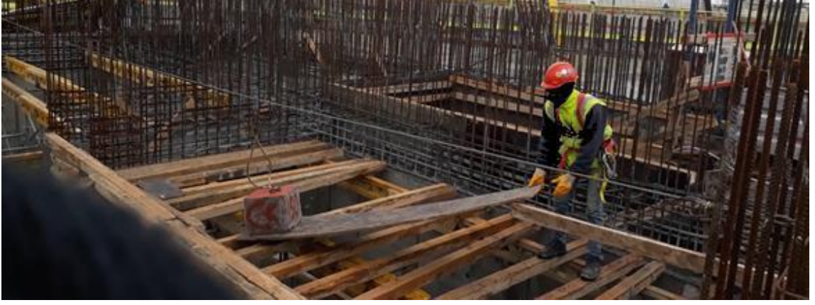
Şekil 99: Orta Kısımdaki Etriyelere Denk Gelen 15 Metrelik Yaşam Yattı Test Görşeli
