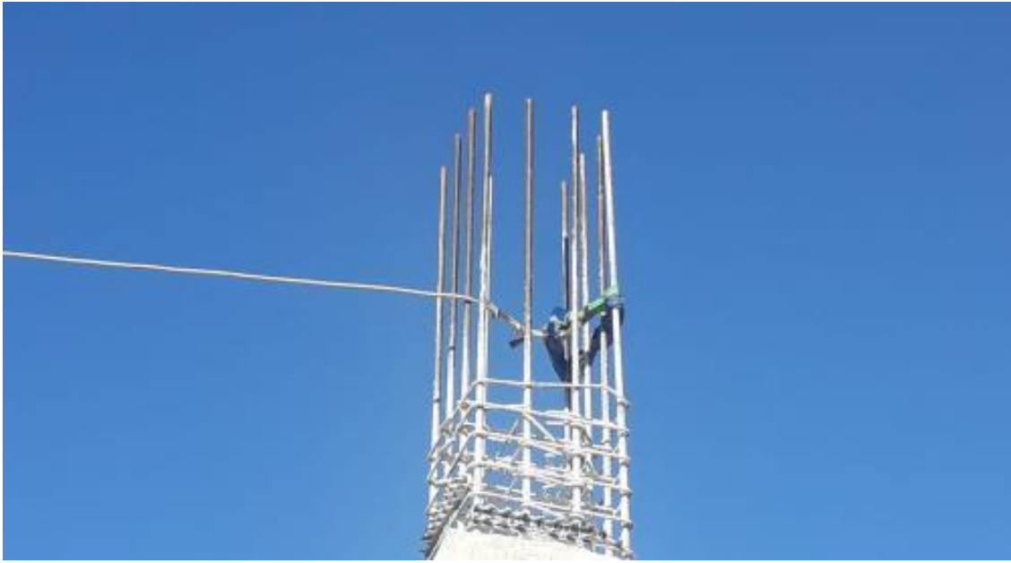
řekil 139: Perlon Kullanılarak Birden Fazla Demir Filizin Ankraj İine Alınması
