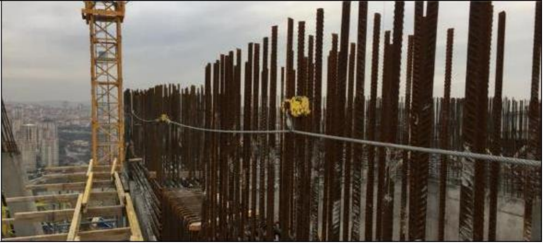
Şekil 22: Kaba Yapıda Çelik Halat ile Kurulan Mobil Yaşam Hattı Örnek-2
