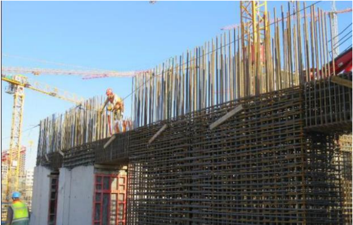
Şekil 70: Çapı 32 Olan Demir Filizi 4.Ankraj Testi Öncesi Mevcut Durum
