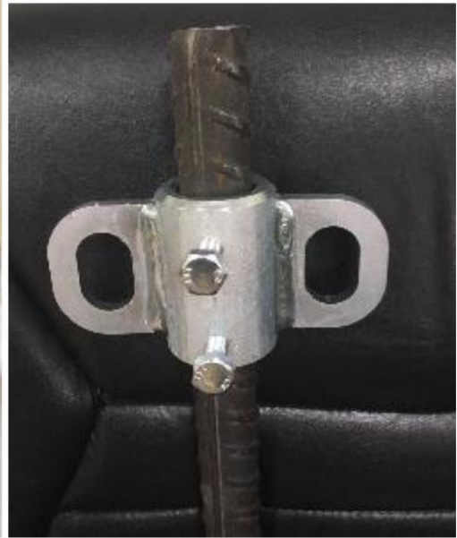
Şekil 13: Filiz Ankraj Aparatı Kullanım
