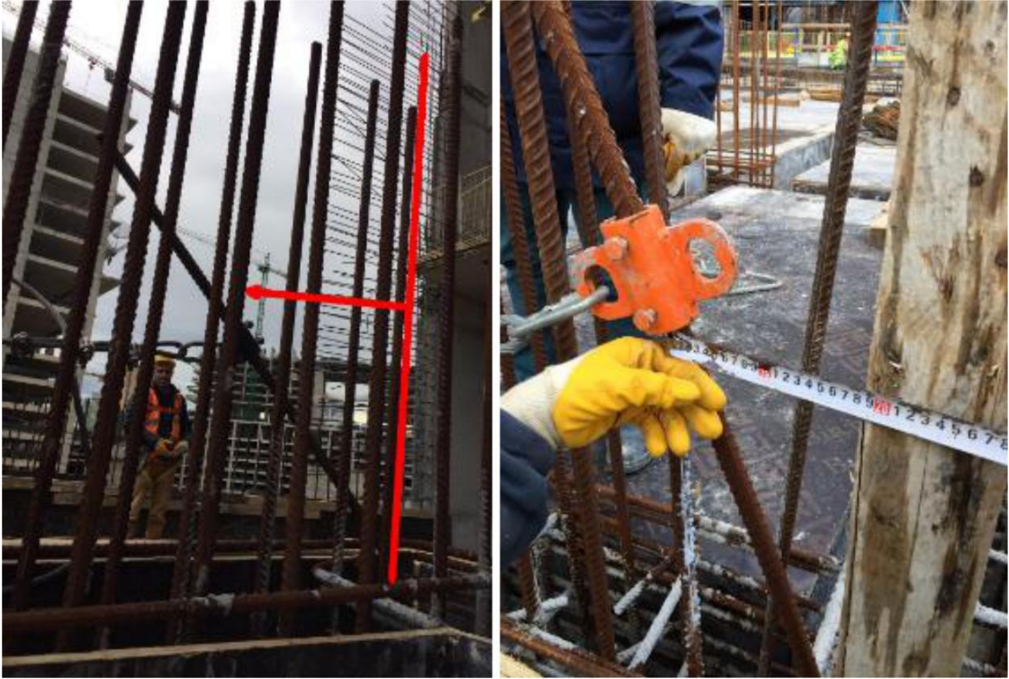
Şekil 77: 1.Ankraj Noktası Eğilme (43cm) Şekil 78: 2.Ankraj Noktası Eğilme (18cm)
