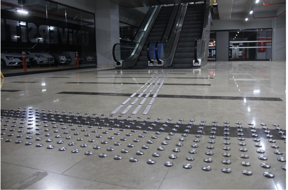
Merdivenler – Uyarıcı yüzey ve yürüme yüzeyi uygulaması
