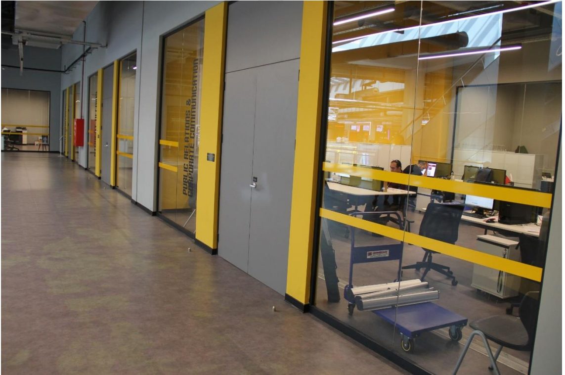
Cam yüzeyler – Az gören görme engelliler için şerit bant uygulaması
