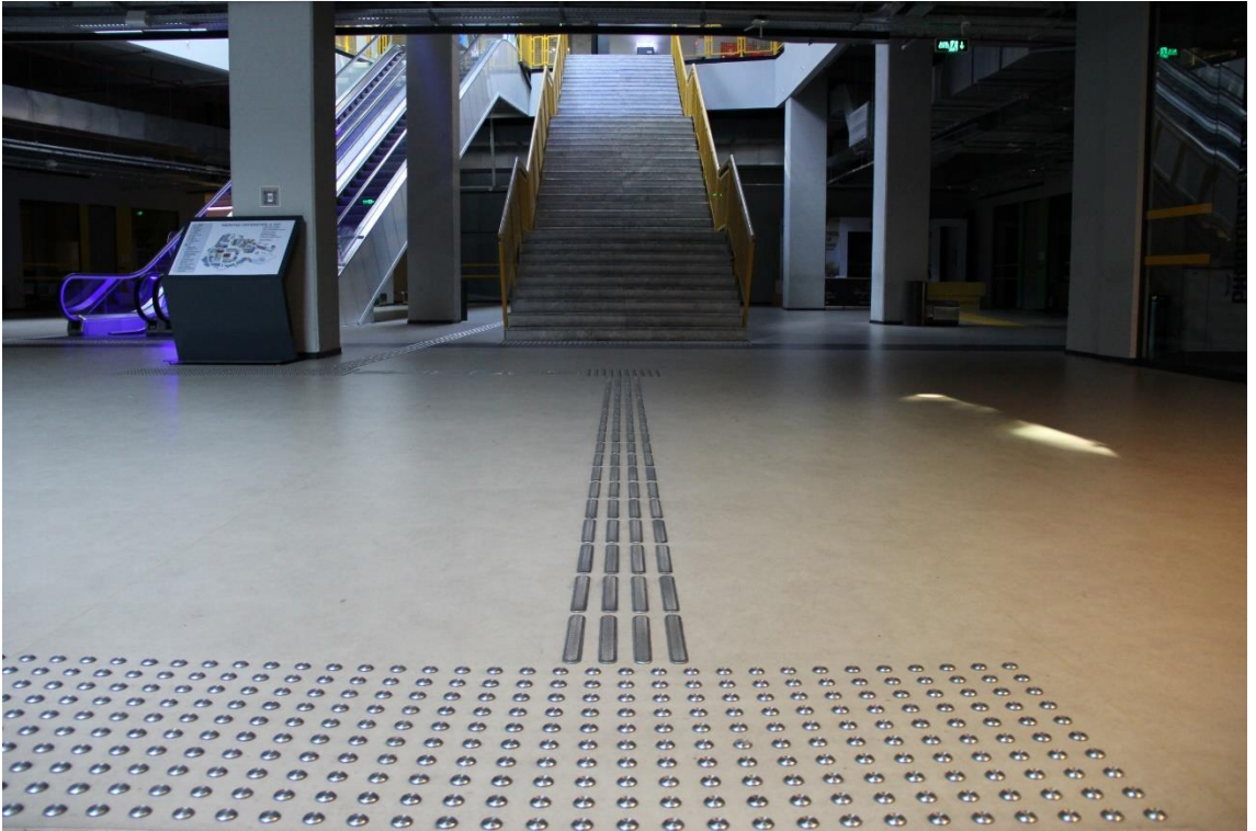
Hissedilebilir yürüme yüzeyi uygulaması
