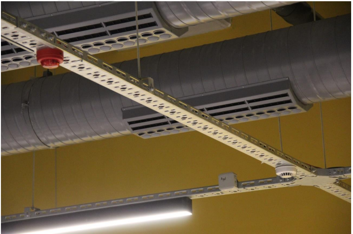
Acil durumlarda uyarı sistemi – Görme engelliler için uyarıcı flaşörler ve dedektörler
