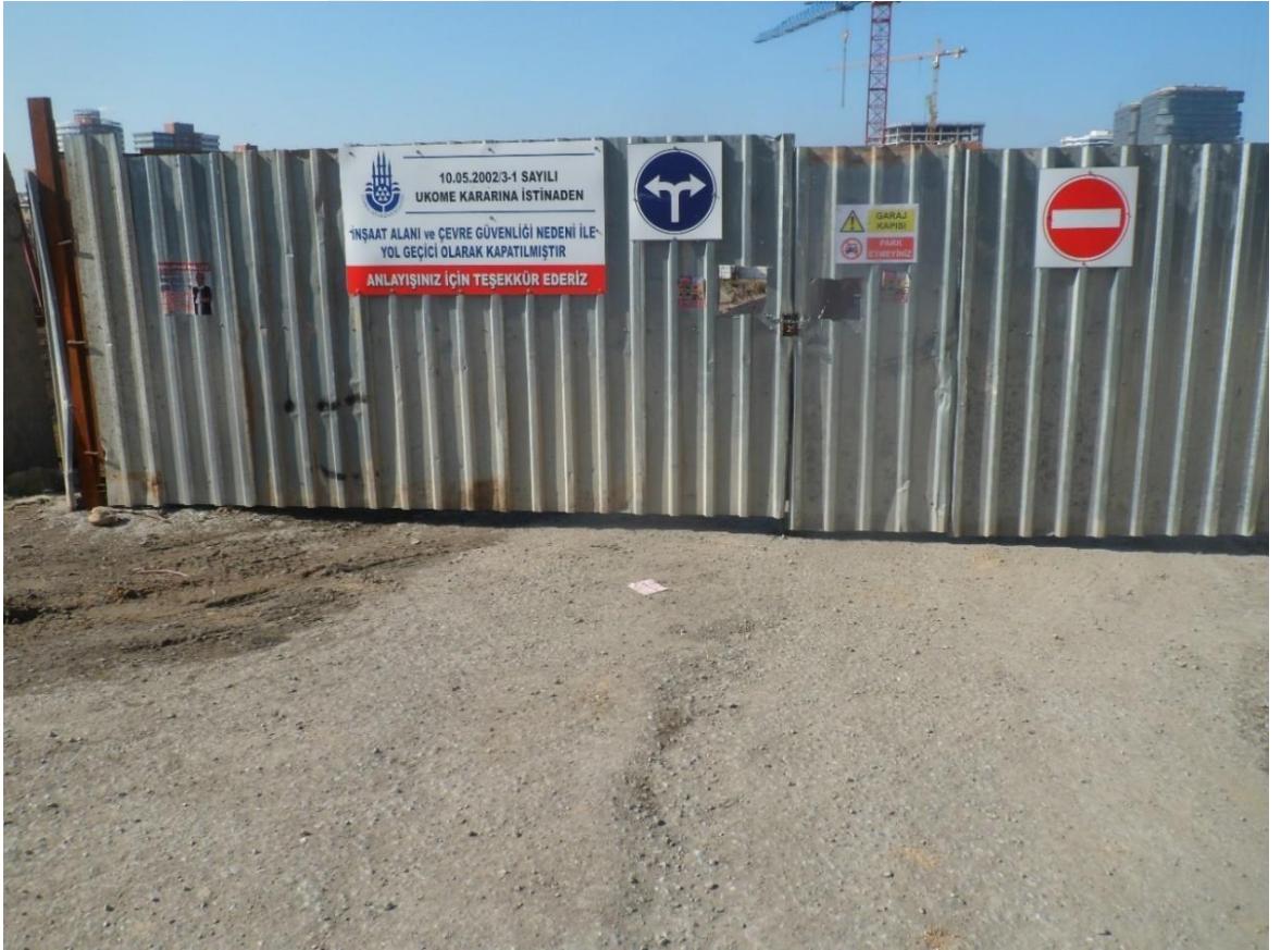
Resim 59: Fikirtepe mahallesi 78 nolu yapı şantiyesi araç giriş kapısı
