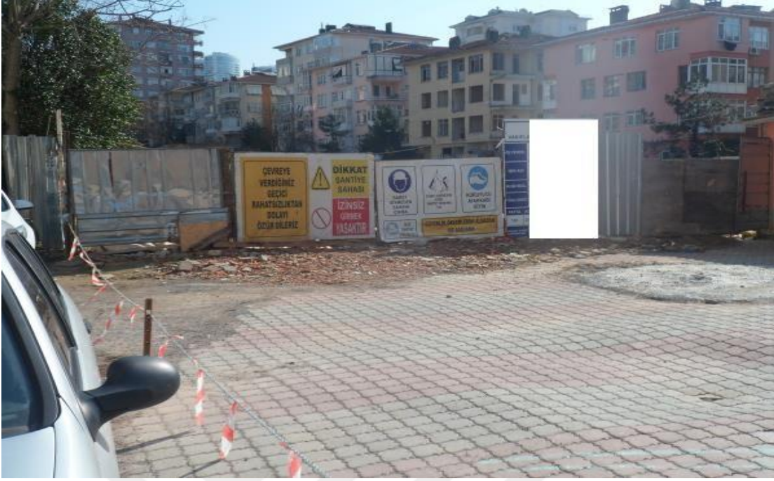
Resim 19: Feneryolu mahallesi 42 nolu yapı şantiyesi ana giriş kapısı
