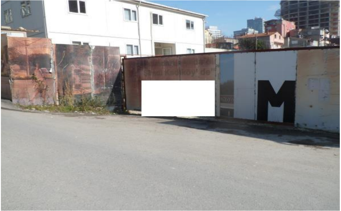
Resim 92: Fikirtepe mahallesi 80 nolu yapı şantiyesi ana giriş kapısı
