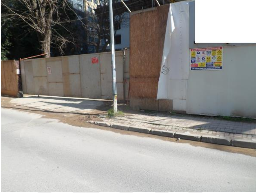
Resim 21: Feneryolu mahallesi 43 nolu yapı şantiyesi ana giriş kapısı
