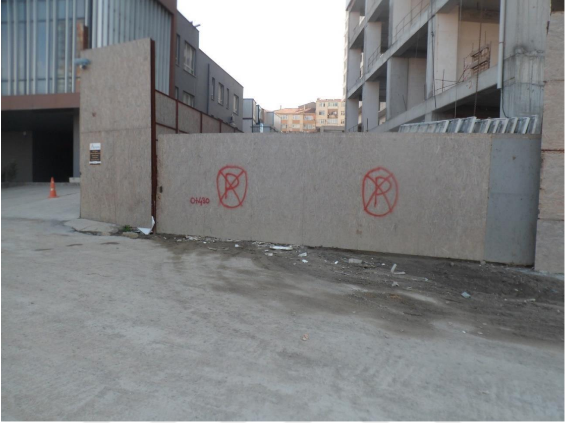
Resim 51: Fikirtepe mahallesi 76 nolu yapı şantiyesi araç giriş kapısı
