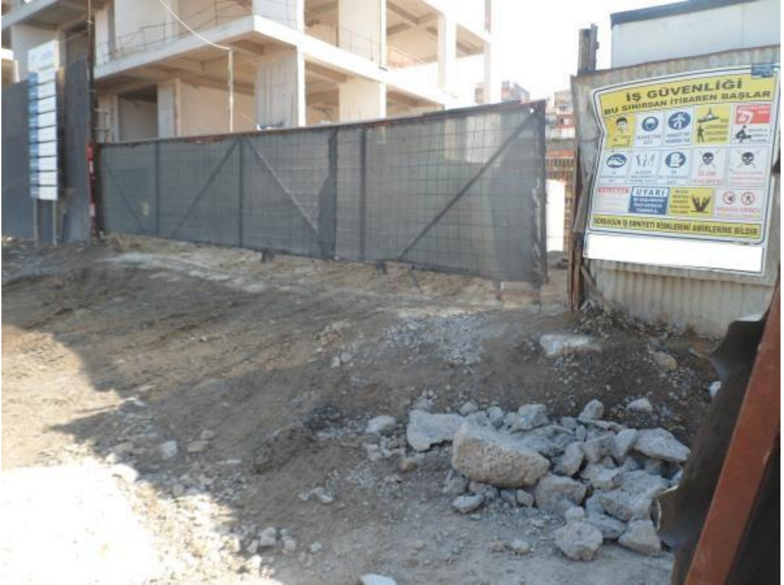
Resim 52: Fikirtepe mahallesi 76 nolu yapı şantiyesi ana giriş kapısı
