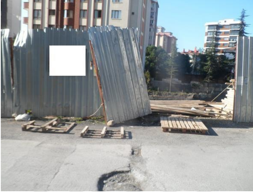
Resim 24: Feneryolu mahallesi 45 nolu yapı şantiyesi araç ve yaya giriş kapısı
