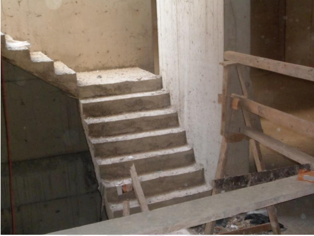
Resim 136: Erenk y mahallesi 12 nolu yapı Őantiyesi acil  ıkıŐ merdiveni
