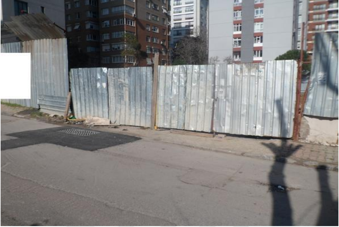
Resim 124: Dumlupınar mahallesi 75 nolu yapı şantiyesi ana giriş kapısı
