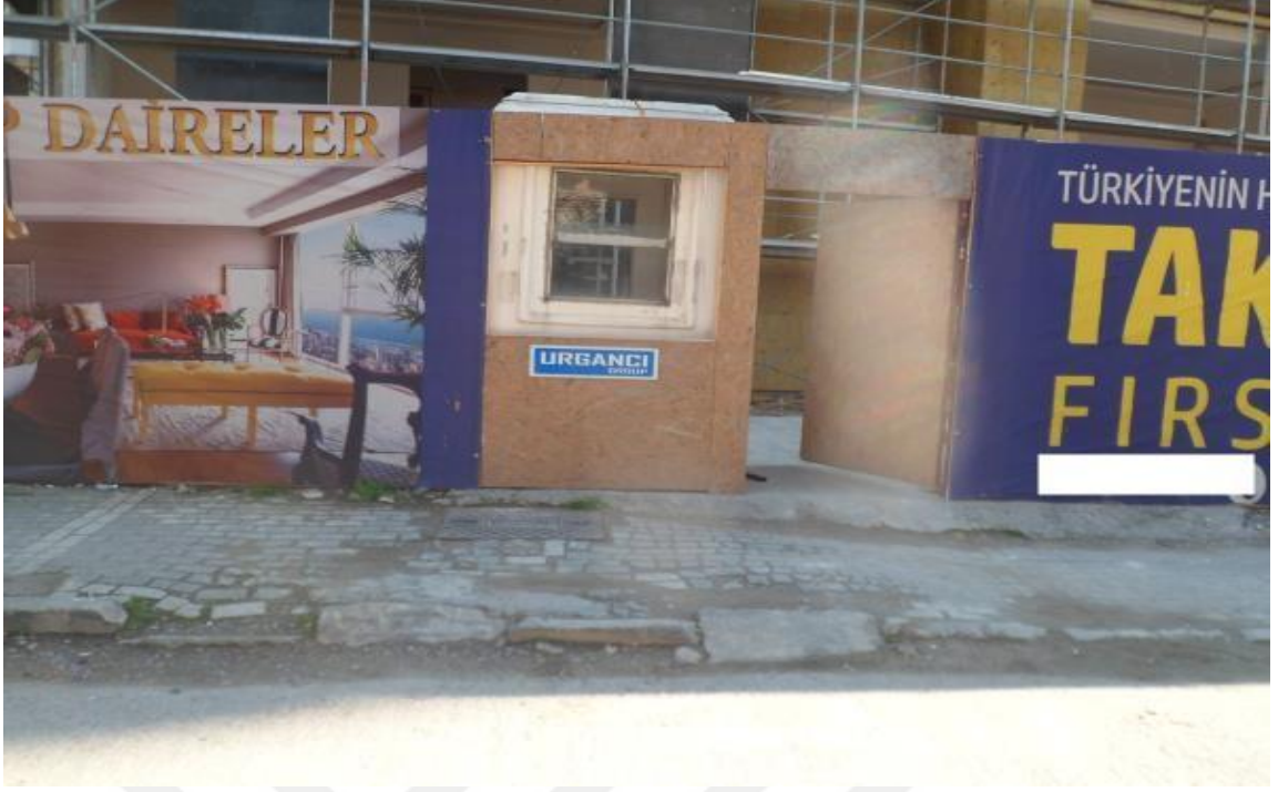
Resim 13: Göztepe mahallesi 19 nolu yapı şantiyesi yaya giriş kapısı
