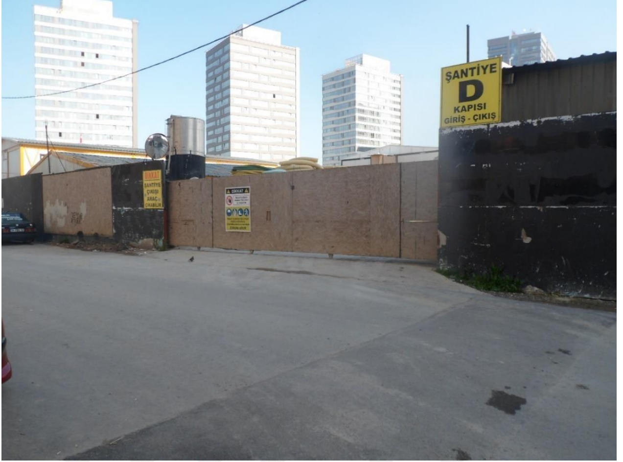
Resim 47: Dumlupınar mahallesi 73 nolu yapı şantiyesi araç ve yaya giriş kapısı
