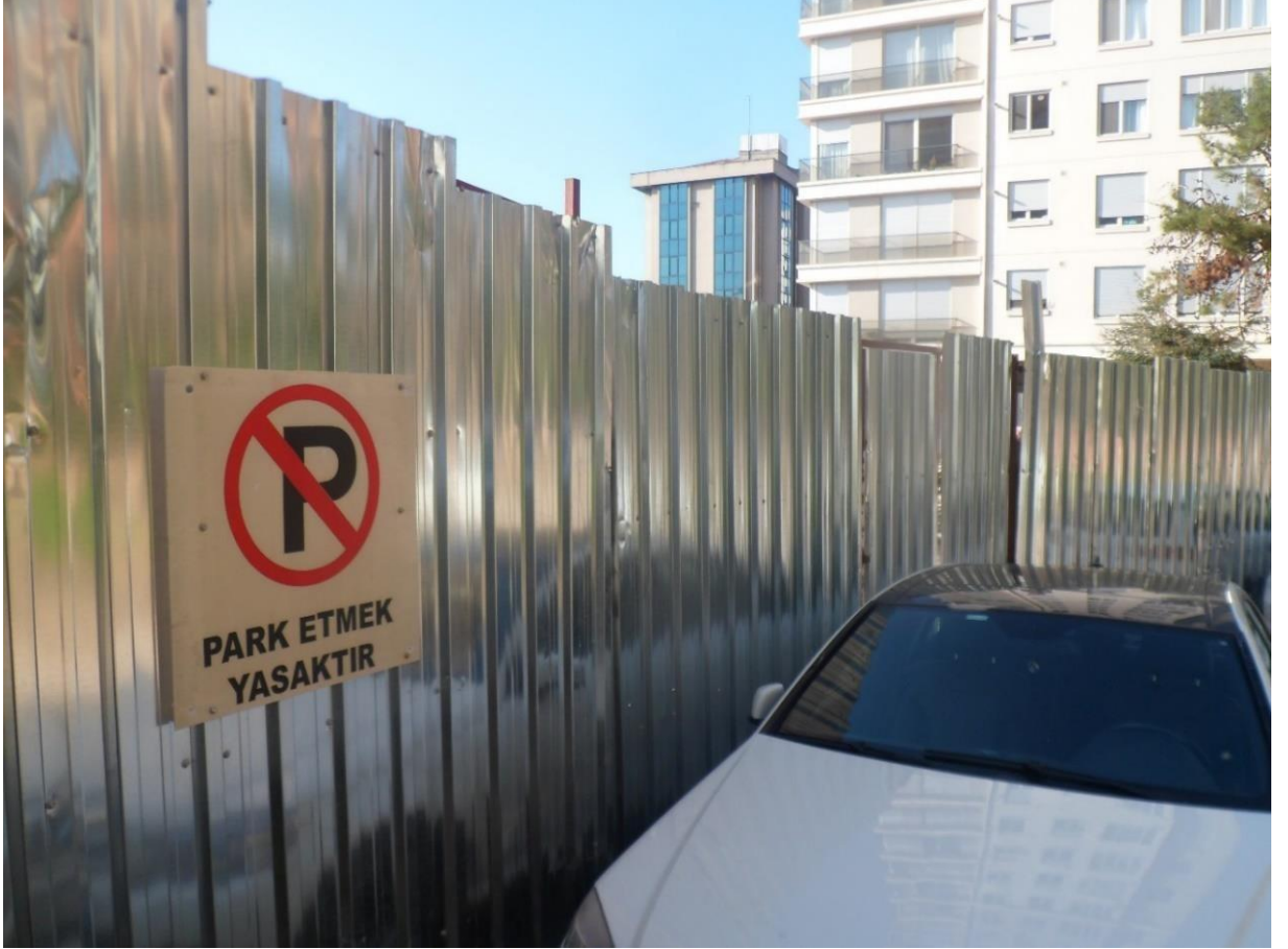
Resim 101: Erenky mahallesi 17 nolu yapı Őantiyesi sol cepheden ana giriŐ kapıŐı
