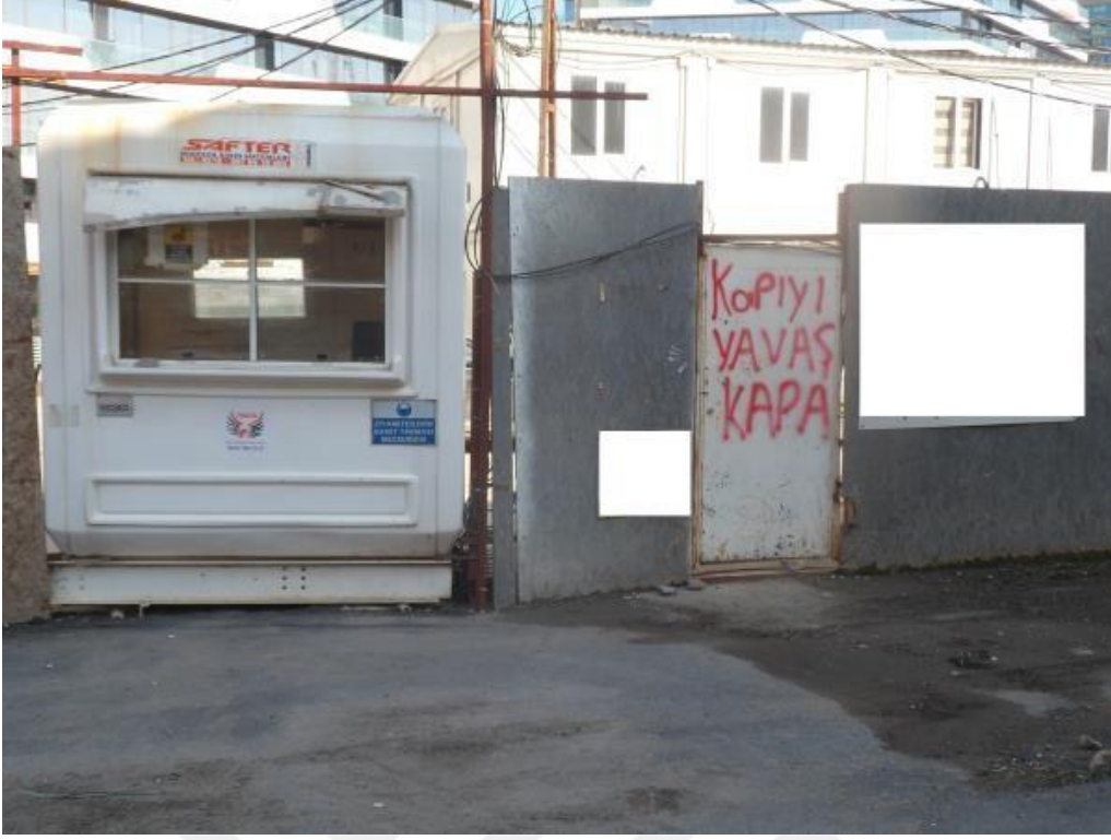
Resim 54: Fikirtepe mahallesi 77 nolu yapı şantiyesi yaya giriş kapısı
