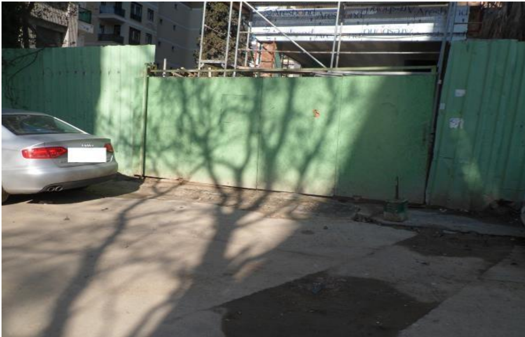
Resim 114: Feneryolu mahallesi 52 nolu yapı şantiyesi ana giriş kapısı
