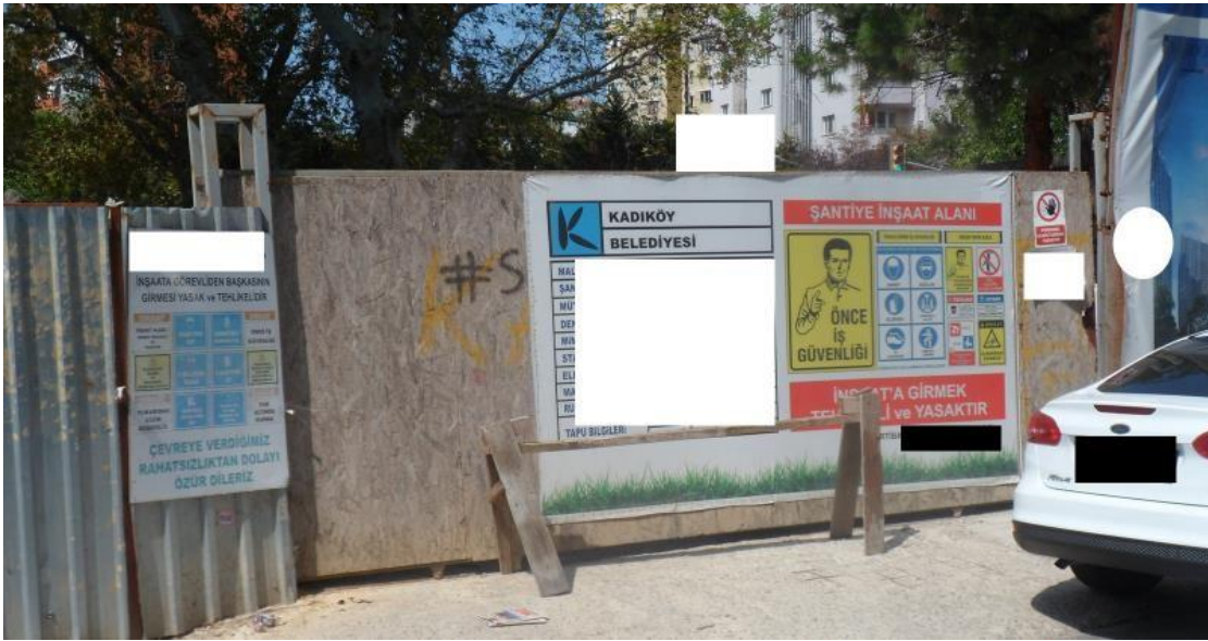
Resim 3: Kozyatağı mahallesi 2 nolu yapı şantiyesi araç ve yaya giriş kapısı
