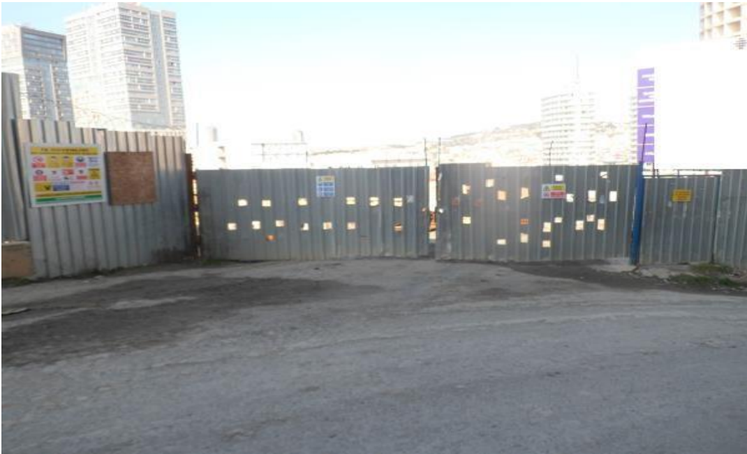
Resim 55: Fikirtepe mahallesi 78 nolu yapı şantiyesi ana giriş kapısı
