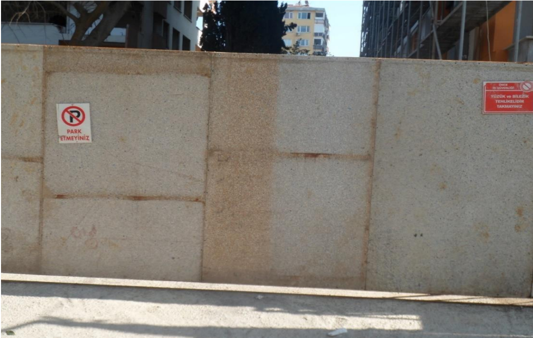
Resim 20: Feneryolu mahallesi 43 nolu yapı şantiyesi ana giriş kapısı
