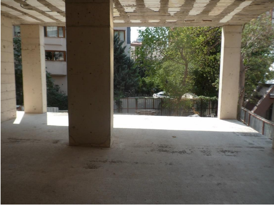
Resim 128: Kozyatağı mahallesi 2 nolu yapı şantiyesi kat içerisi
