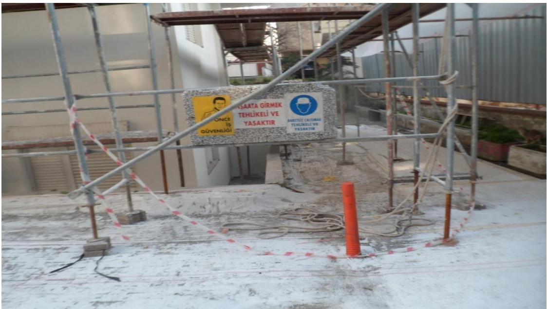
Resim 64: Erenköy mahallesi 13 nolu yapı şantiyesi giriş noktası
