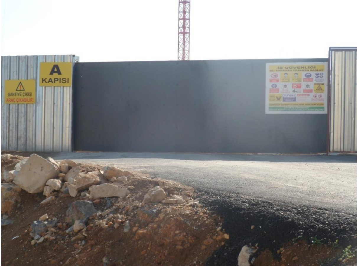
Resim 40: Merdivenköy mahallesi 66 nolu yapı şantiyesi araç ve yaya giriş kapısı
