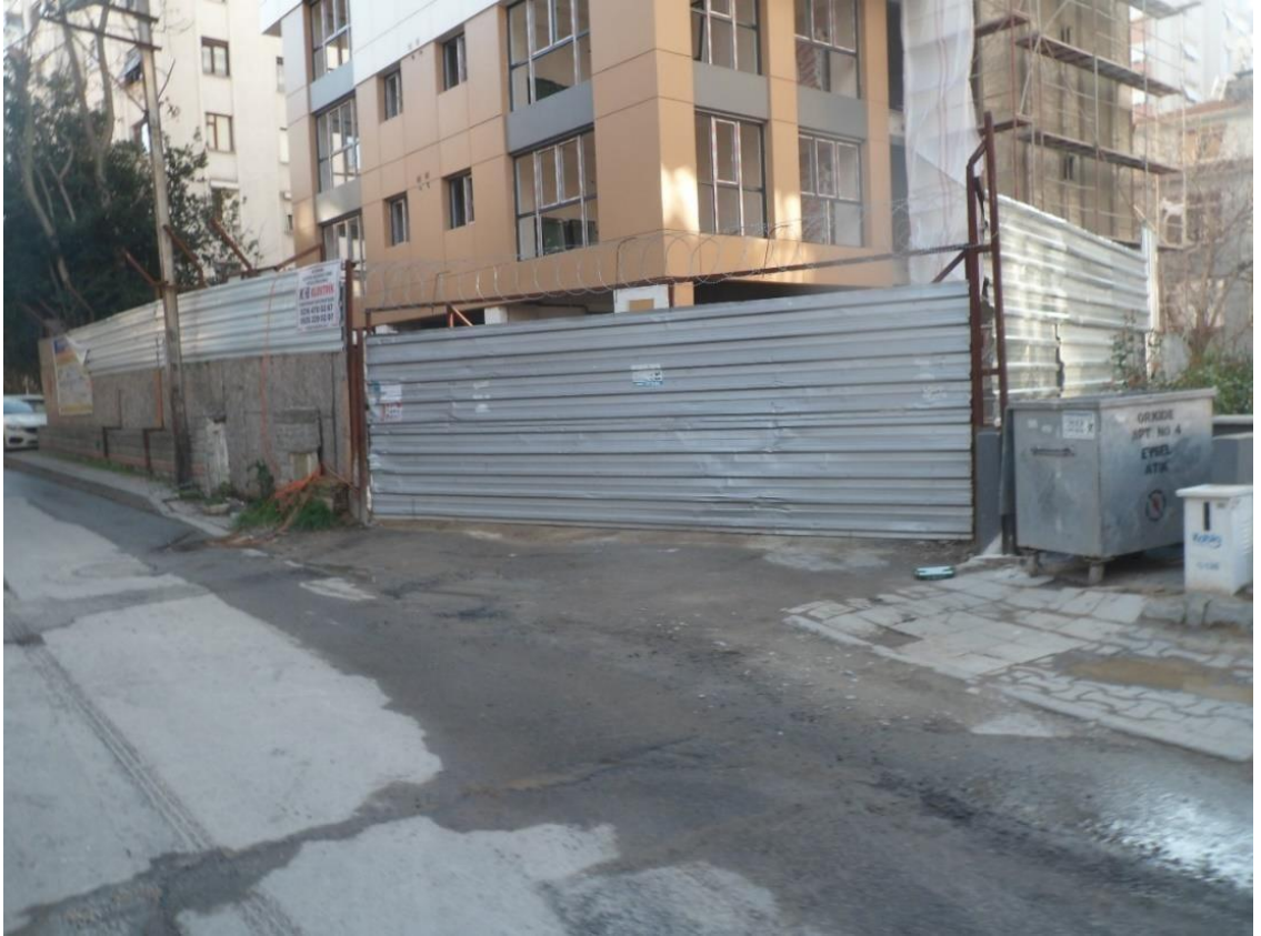
Resim 28: Feneryolu mahallesi 48 nolu yapı şantiyesi araç ve yaya giriş kapısı
