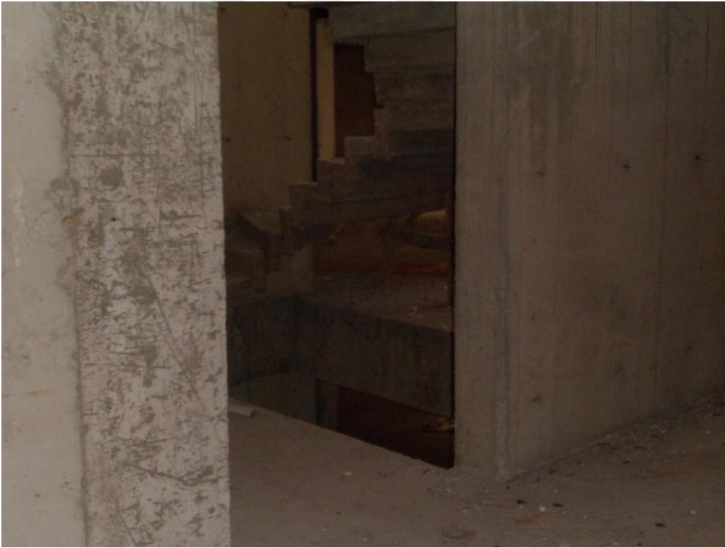
Resim 137: Erenk y mahallesi 12 nolu yapı Őantiyesi acil  ıkıŐ merdiveni
