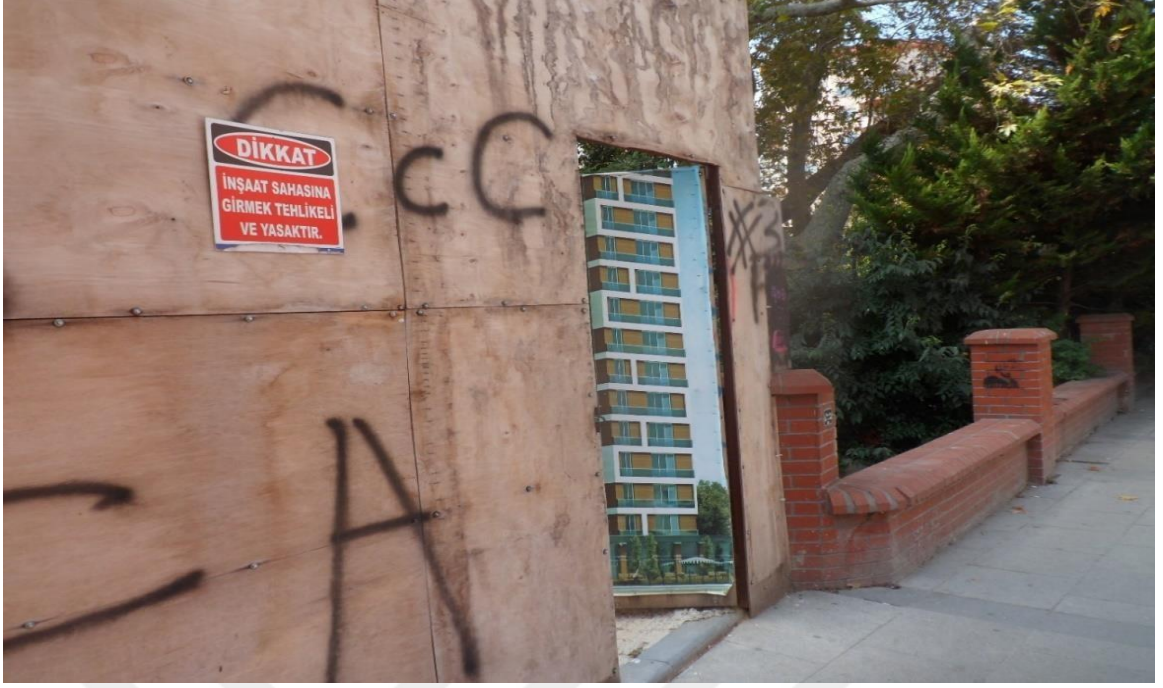
Resim 4: Kozyatağı mahallesi 2 nolu yapı şantiyesi yaya giriş kapısı
