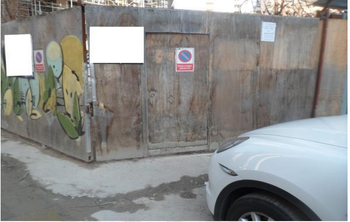
Resim 72: Fenerbahçe mahallesi 34 nolu yapı şantiyesi yaya giriş kapısı
