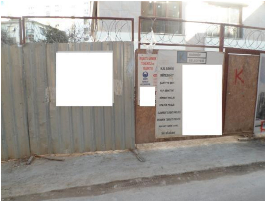
Resim 25: Feneryolu mahallesi 46 nolu yapı şantiyesi ana giriş kapısı
