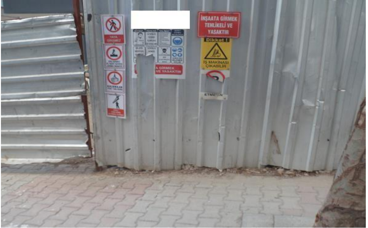
Resim 63: Erenköy mahallesi 12 nolu yapı şantiyesi ana giriş kapısı
