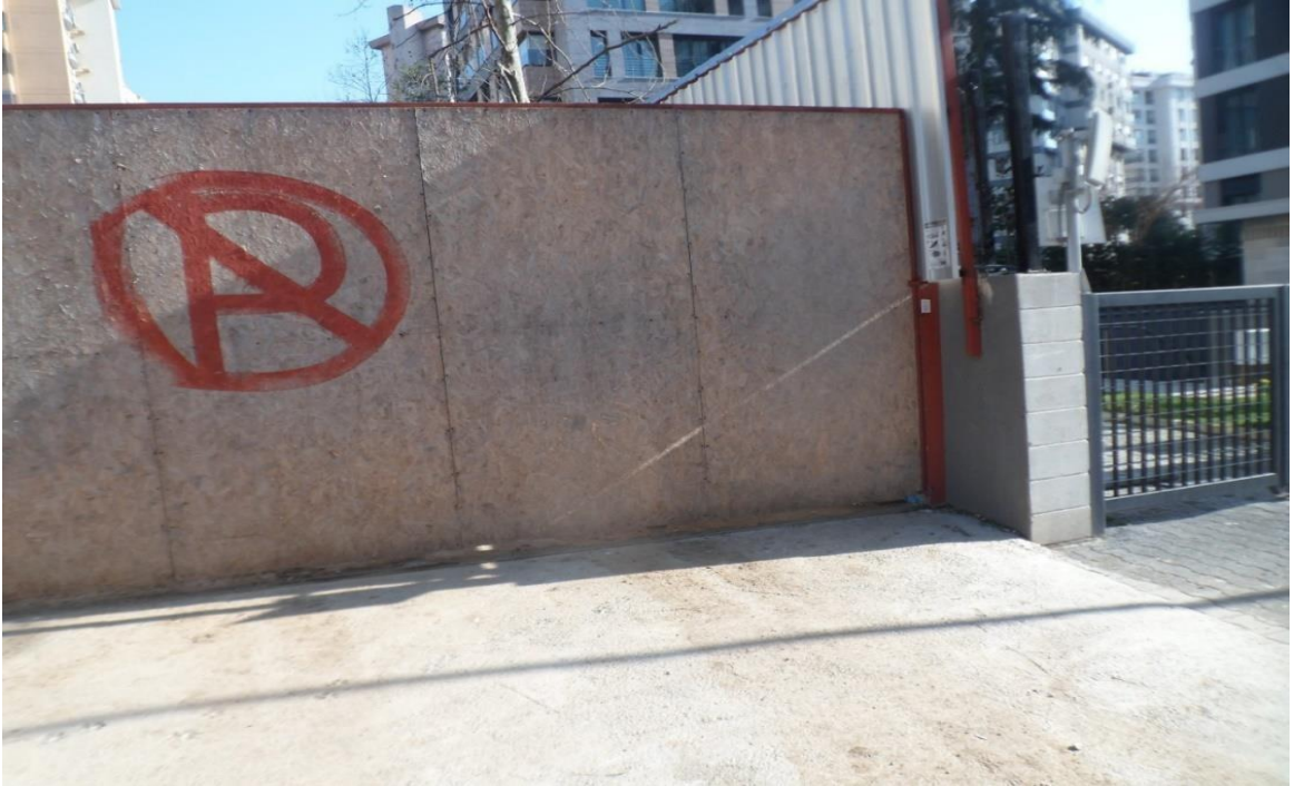
Resim 110: Fenerbahçe mahallesi 39 nolu yapı şantiyesi araç giriş kapısı
