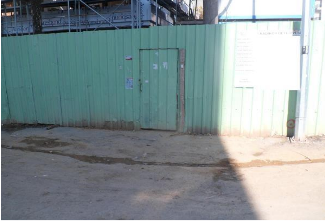
Resim 113: Feneryolu mahallesi 52 nolu yapı şantiyesi yaya giriş kapısı
