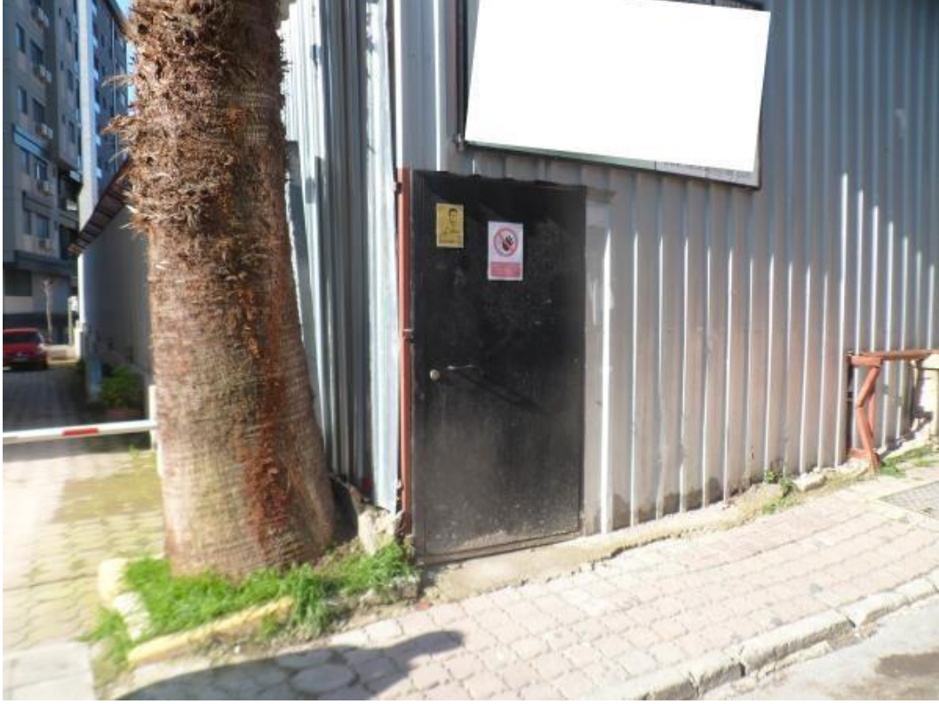
Resim 85: Sahrayı cedit mahallesi 62 nolu yapı şantiyesi ana giriş kapısı
