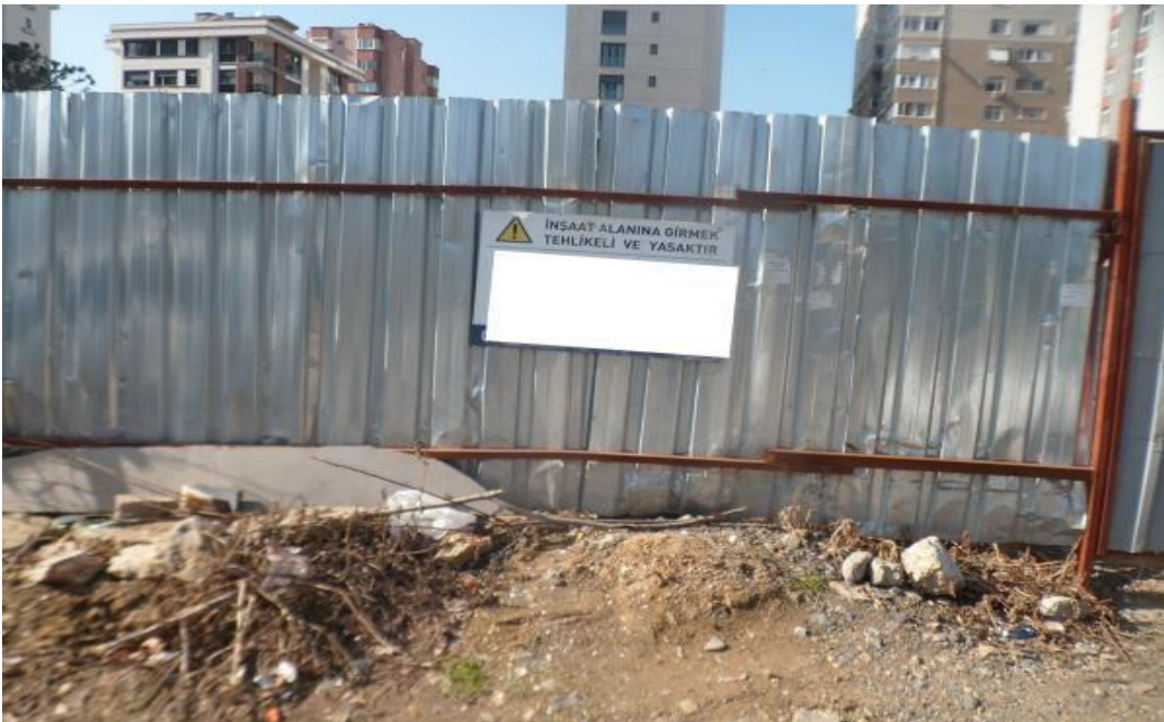
Resim 95: Kozyatağı mahallesi 6 nolu yapı şantiyesi ana giriş kapısı
