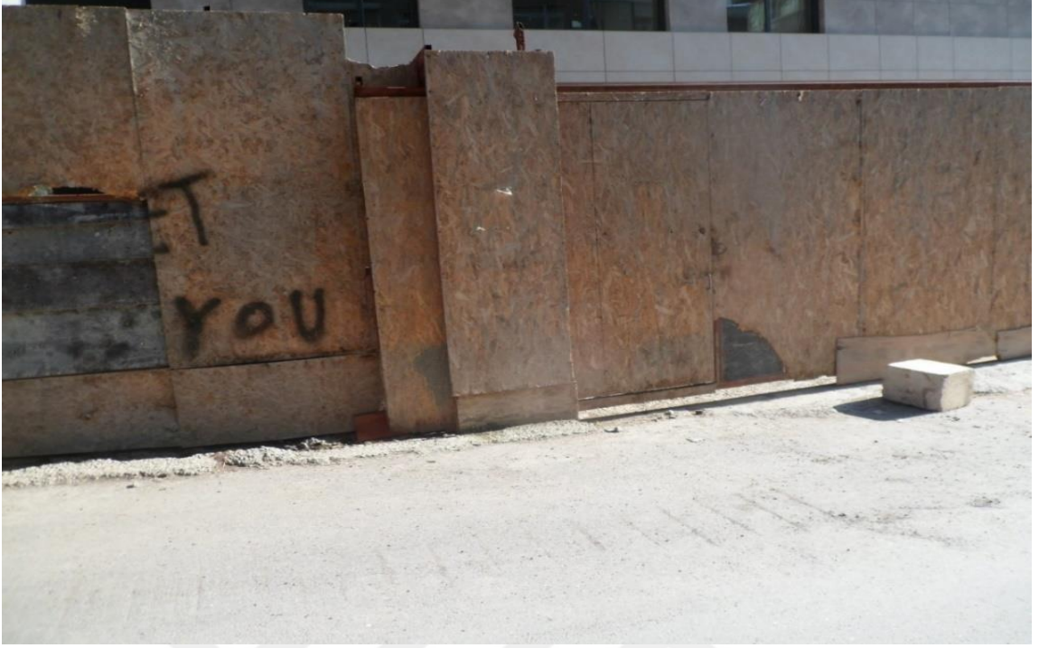
Resim 119: Sahrayı cedit mahallesi 64 nolu yapı şantiyesi araç giriş kapısı
