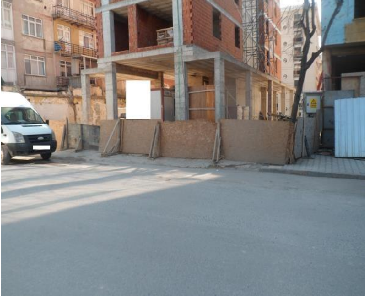
Resim 93: Kozyatağı mahallesi 4 nolu yapı şantiyesi ana giriş kapısı
