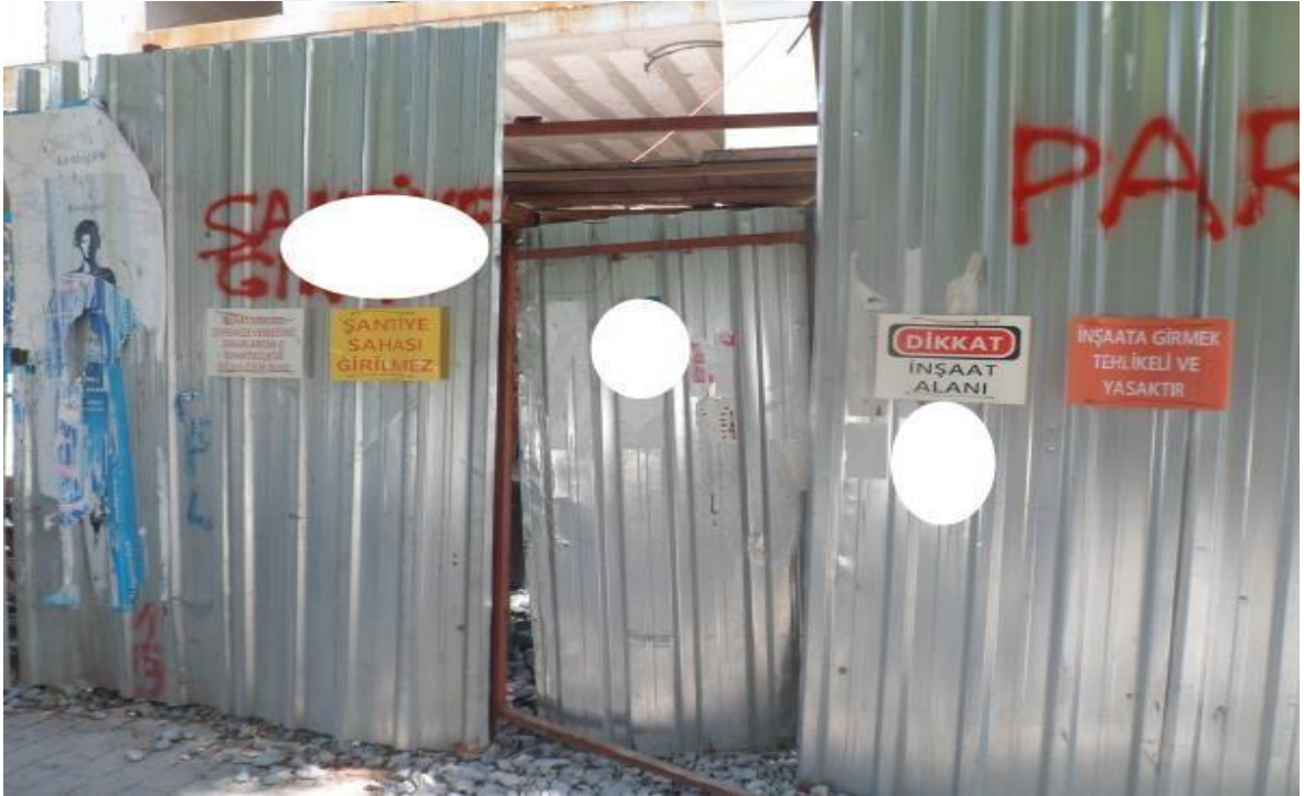
Resim 62: 19 Mayıs mahallesi 10 nolu yapı şantiyesi yaya giriş kapısı
