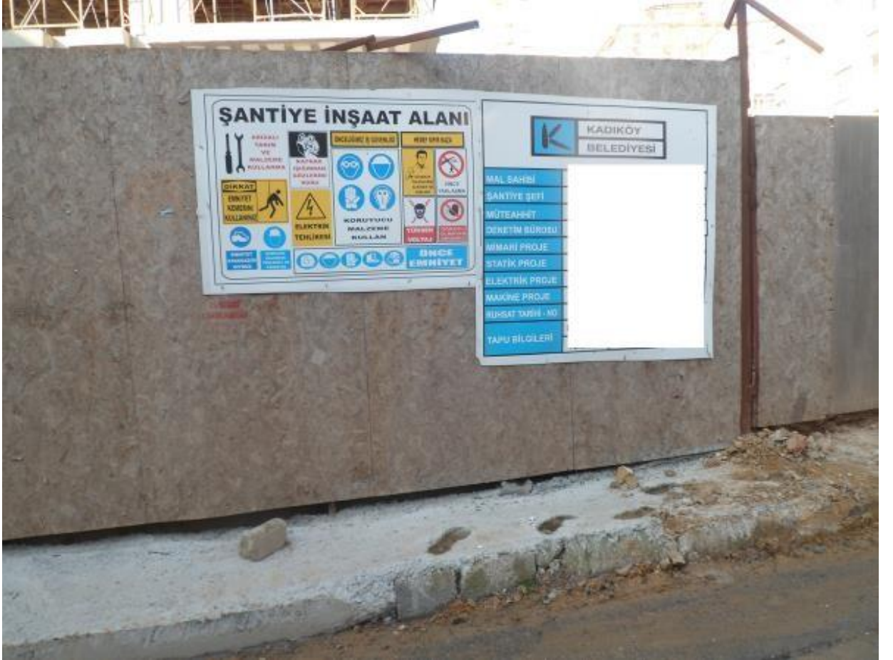
Resim 26: Feneryolu mahallesi 47 nolu yapı şantiyesi ana giriş kapısı
