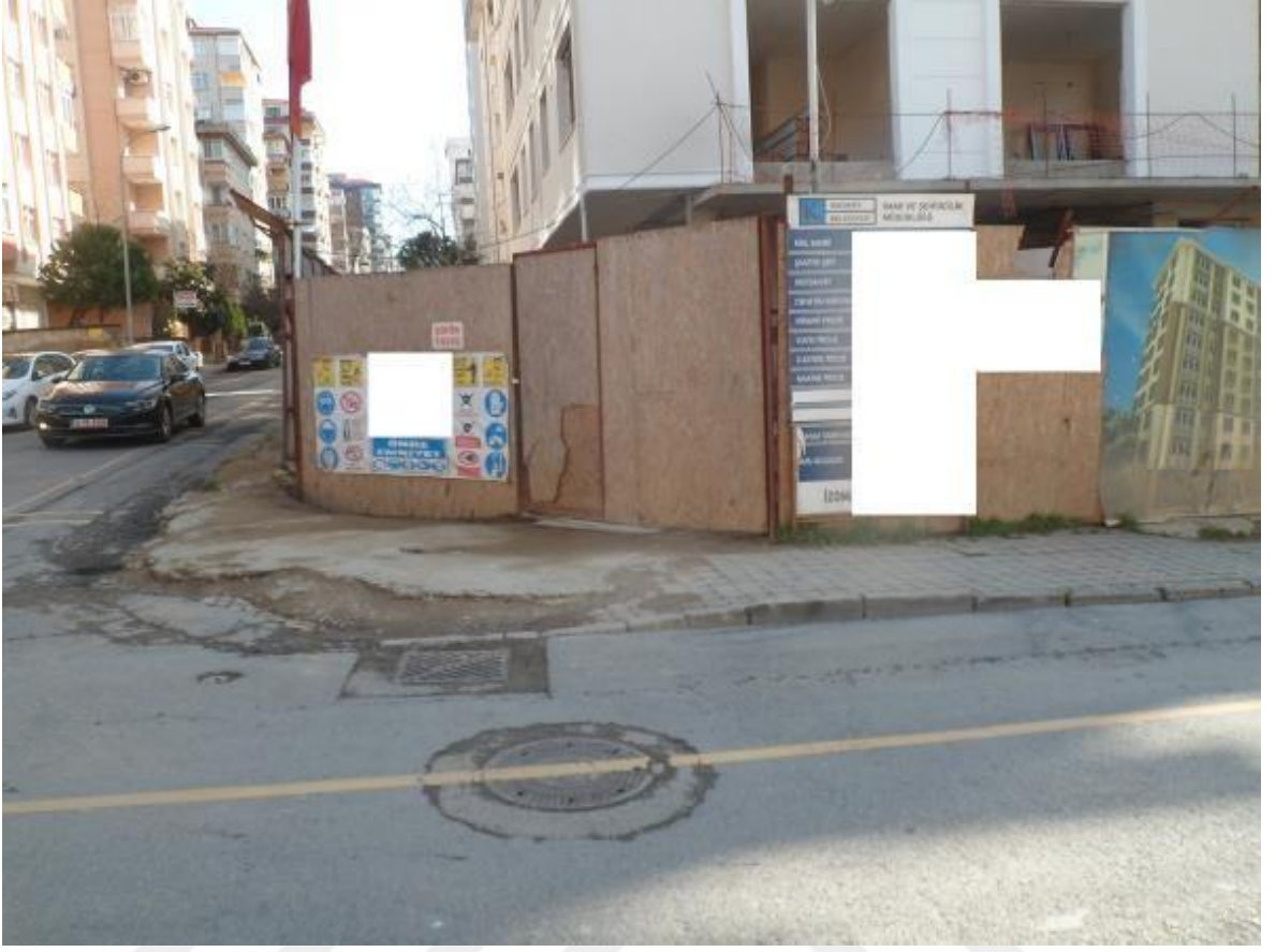
Resim 50: Dumlupınar mahallesi 74 nolu yapı şantiyesi sağ cepheden ana giriş kapısı
