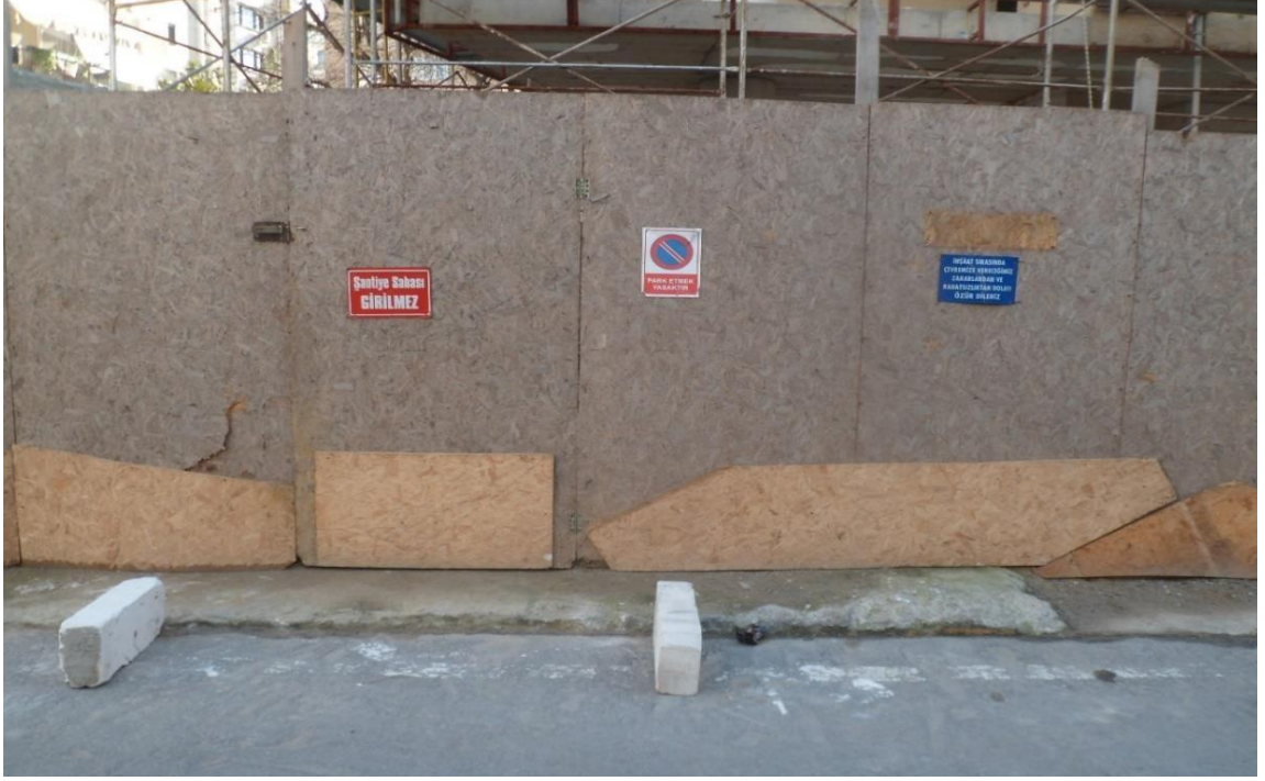
Resim 65: Gztepe mahallesi 20 nolu yapı Őantiyesi ana giriŐi
