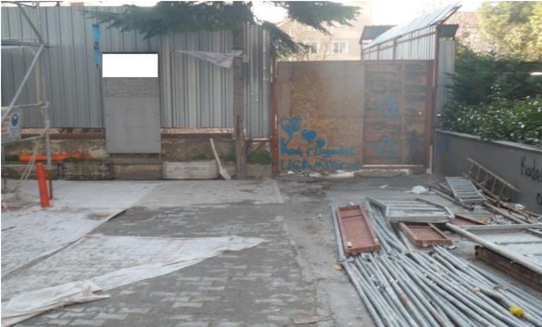
Resim 100: Erenköy mahallesi 16 nolu yapı şantiyesi ana giriş kapısı
