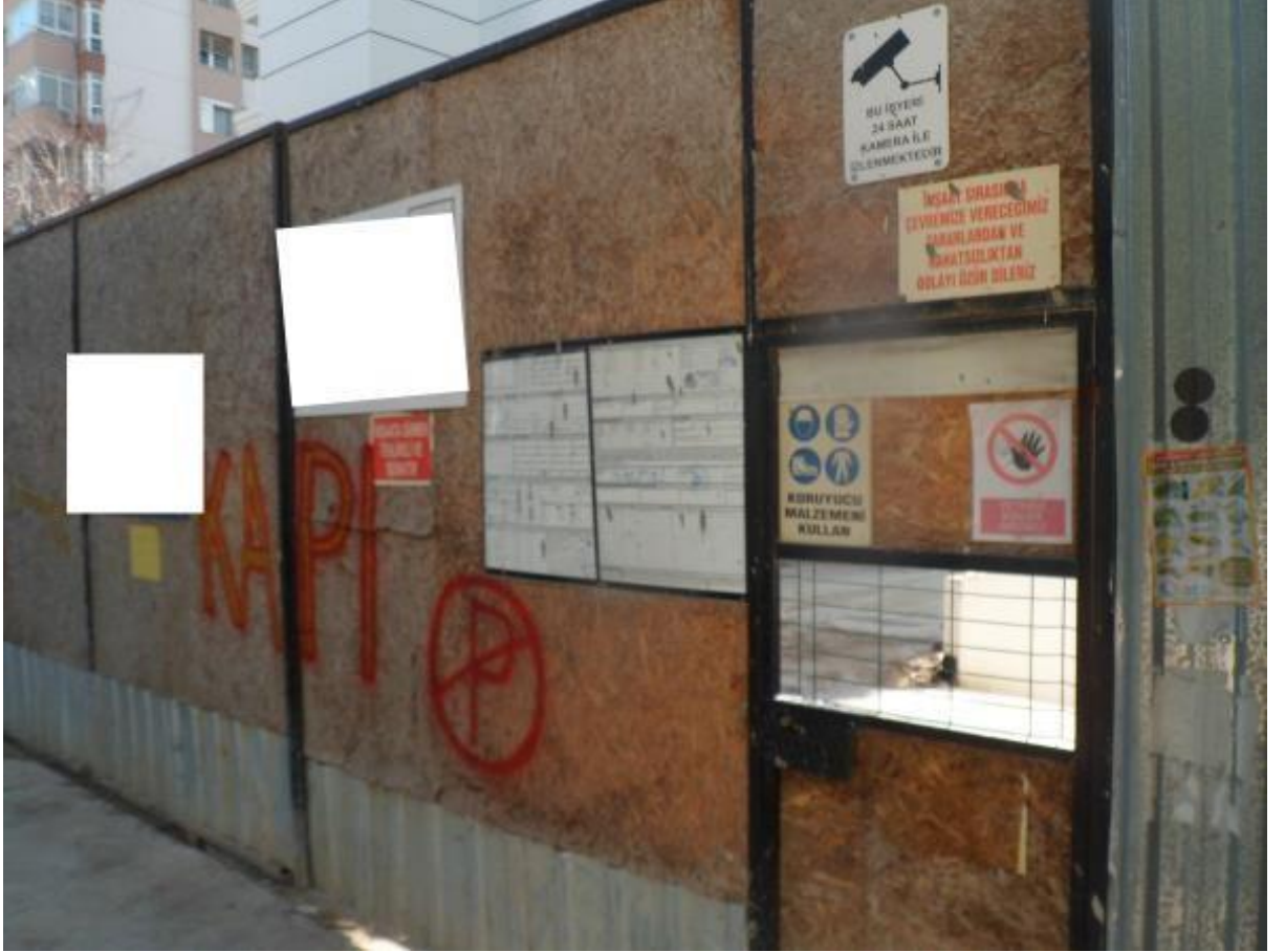
Resim 77: Feneryolu mahallesi 50 nolu yapı şantiyesi ana giriş kapısı
