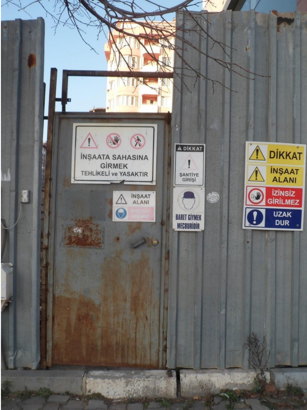
Resim 68: Bostancı mahallesi 24 nolu yapı şantiyesi ana giriş kapısı
