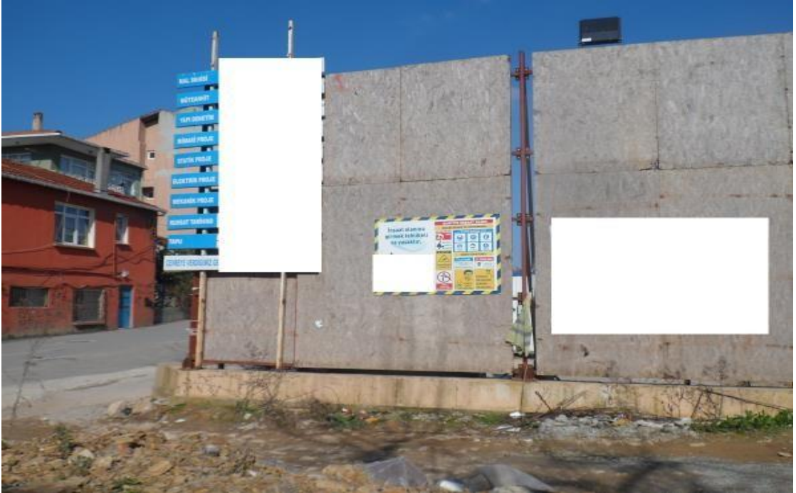
Resim 42: Merdivenköy mahallesi 67 nolu yapı şantiyesi ana giriş kapısı
