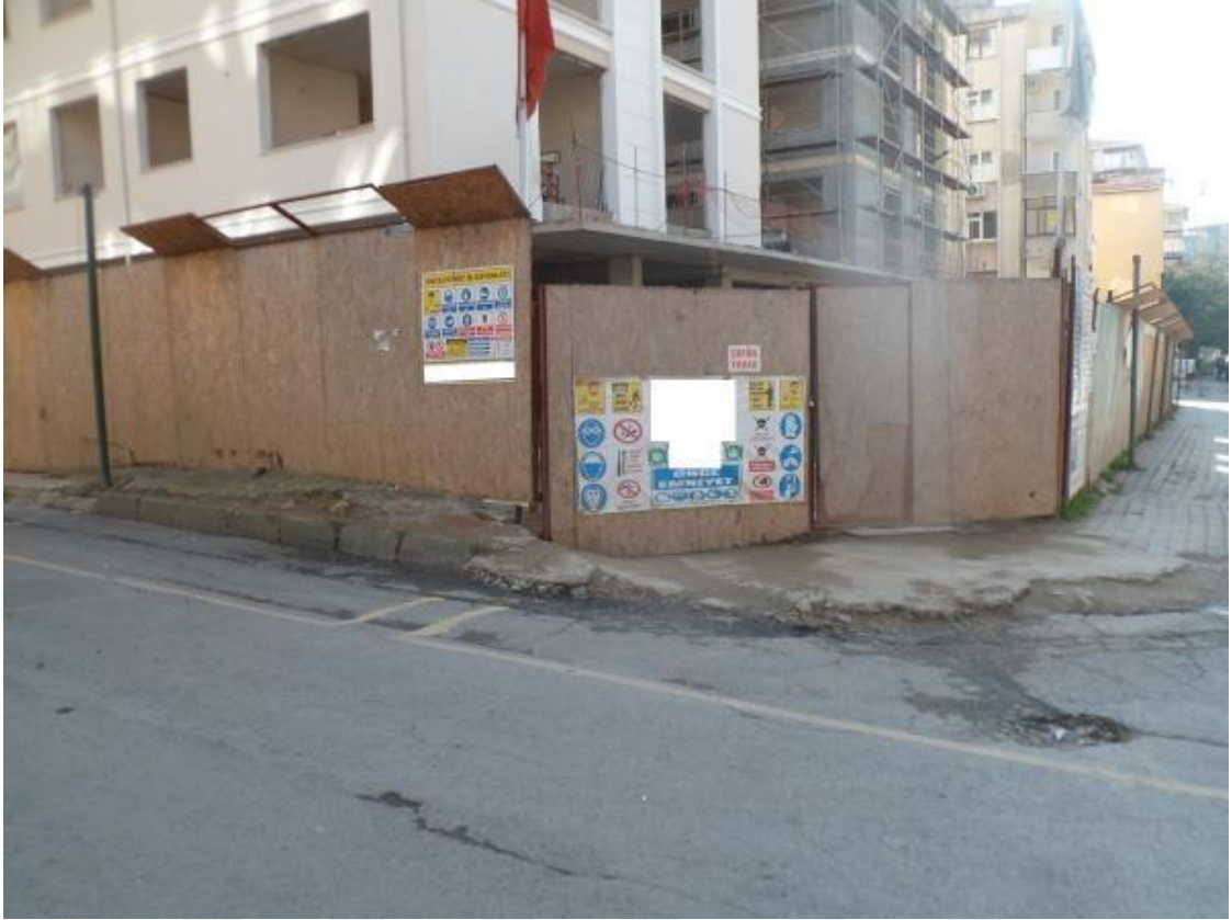
Resim 48: Dumlupınar mahallesi 74 nolu yapı şantiyesi sol cepheden ana giriş kapısı
