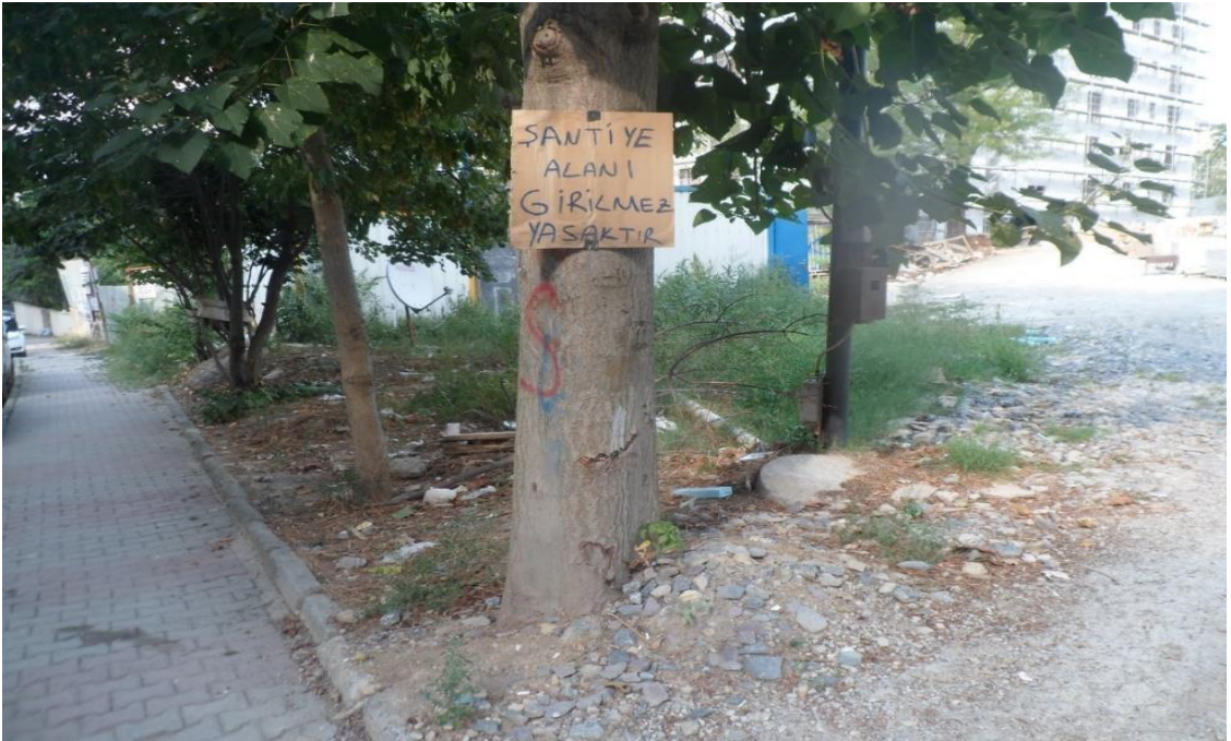
Resim 98: Erenk y mahallesi 15 nolu yapı Őantiyesi ana giriŐ noktası
