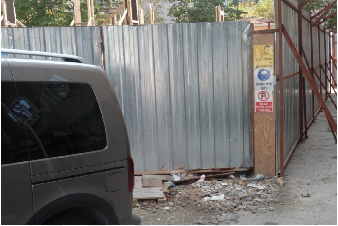
Resim 2: Kozyatağı mahallesi 1 nolu yapı şantiyesi ana giriş kapısı
