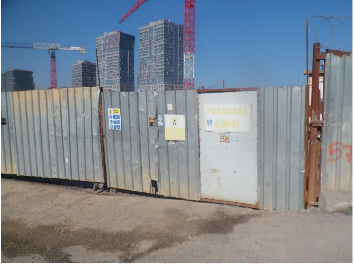
Resim 58: Fikirtepe mahallesi 78 nolu yapı şantiyesi personel giriş kapısı
