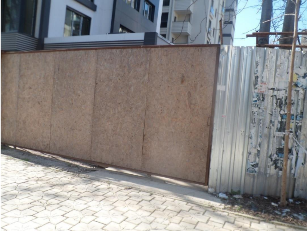
Resim 103:G ztepe mahallesi 21 nolu yapı Őantiyesi ana giriŐ kapısı
