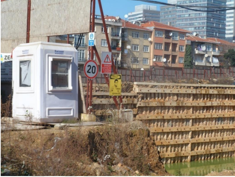
Resim 43: Merdivenköy mahallesi 67 nolu yapı şantiyesi araç ve yaya giriş kapısı.
