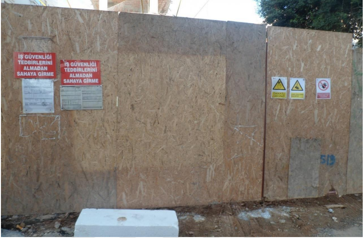
Resim 66: Suadiye mahallesi 23 nolu yapı şantiyesi ana giriş kapısı
