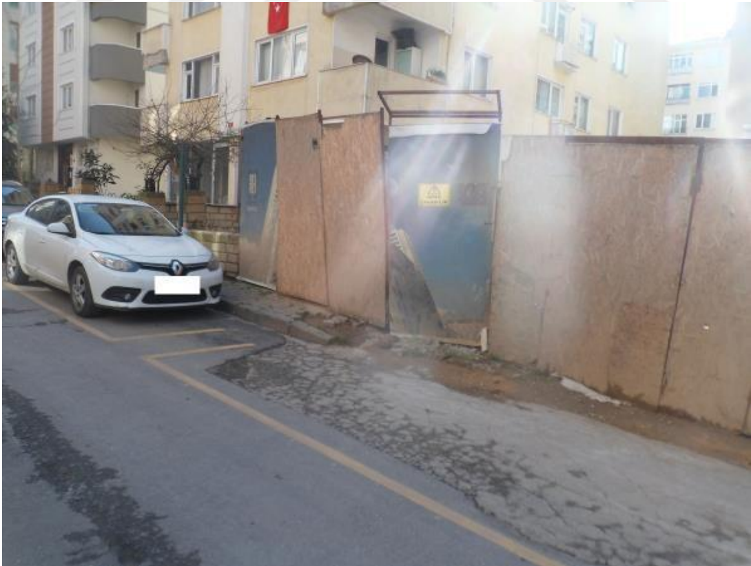
Resim 49: Dumlupınar mahallesi 74 nolu yapı şantiyesi yaya giriş kapısı
