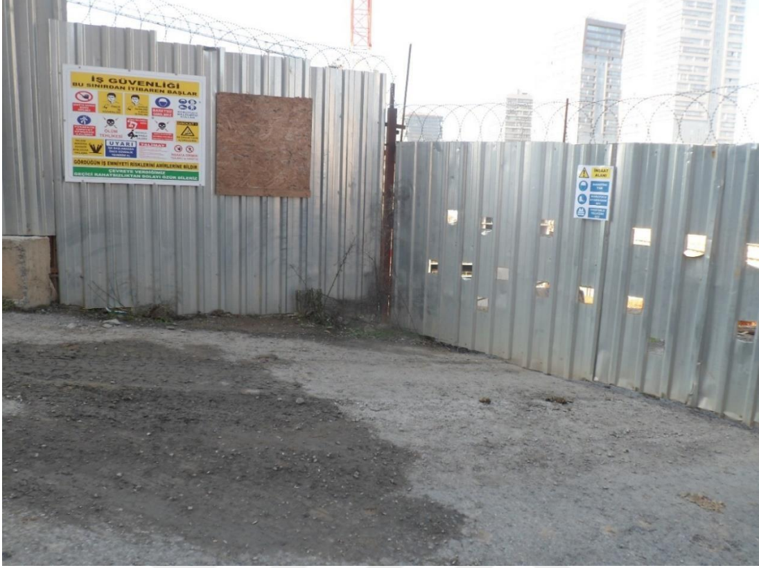
Resim 56: Fikirtepe mahallesi 78 nolu yapı şantiyesi ana giriş kapısı
