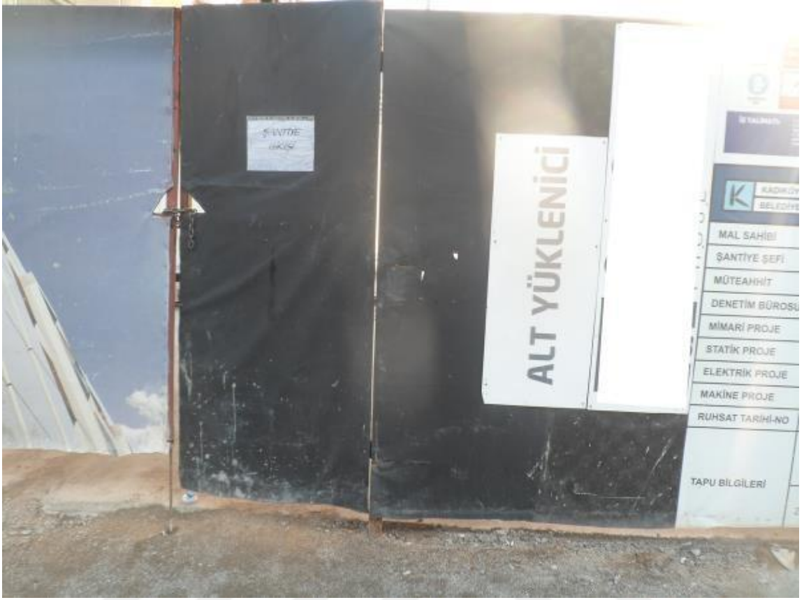
Resim 33: Zühtüpaşa mahallesi 57 nolu yapı şantiyesi yaya giriş kapısı
