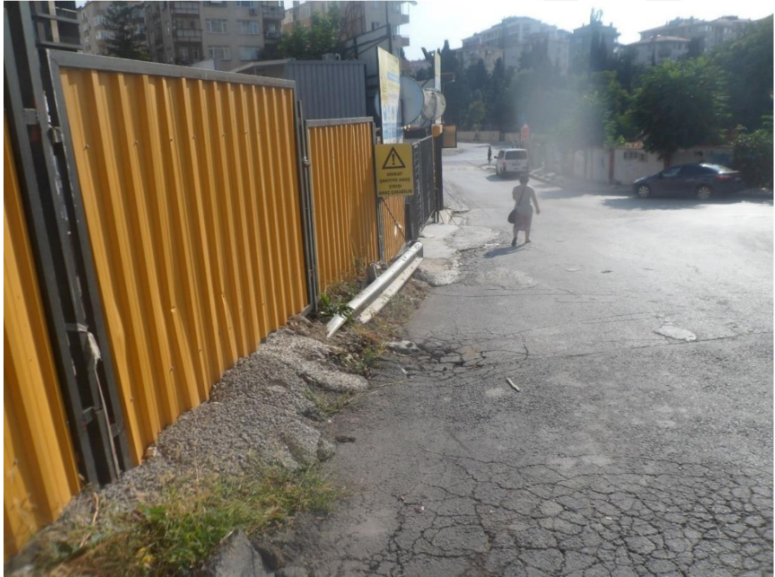
Resim 37: Sahrayı credit mahallesi 61 nolu yapı şantiyesi araç giriş kapısı
