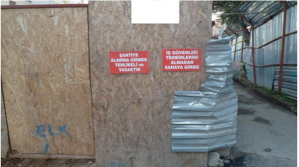
Resim 67: Suadiye mahallesi 23 nolu yapı şantiyesi yaya giriş kapısı
