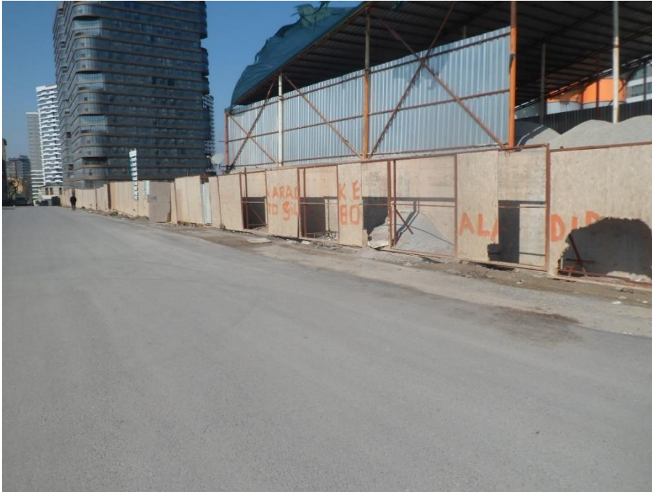
Resim 39: Merdivenköy mahallesi 65 nolu yapı şantiyesi yaya giriş kapısı
