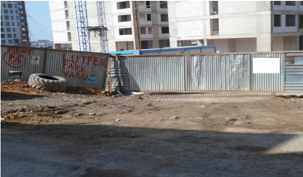
Resim 125: Fikirtepe mahallesi 81 nolu yapı şantiyesi ana giriş kapısı
