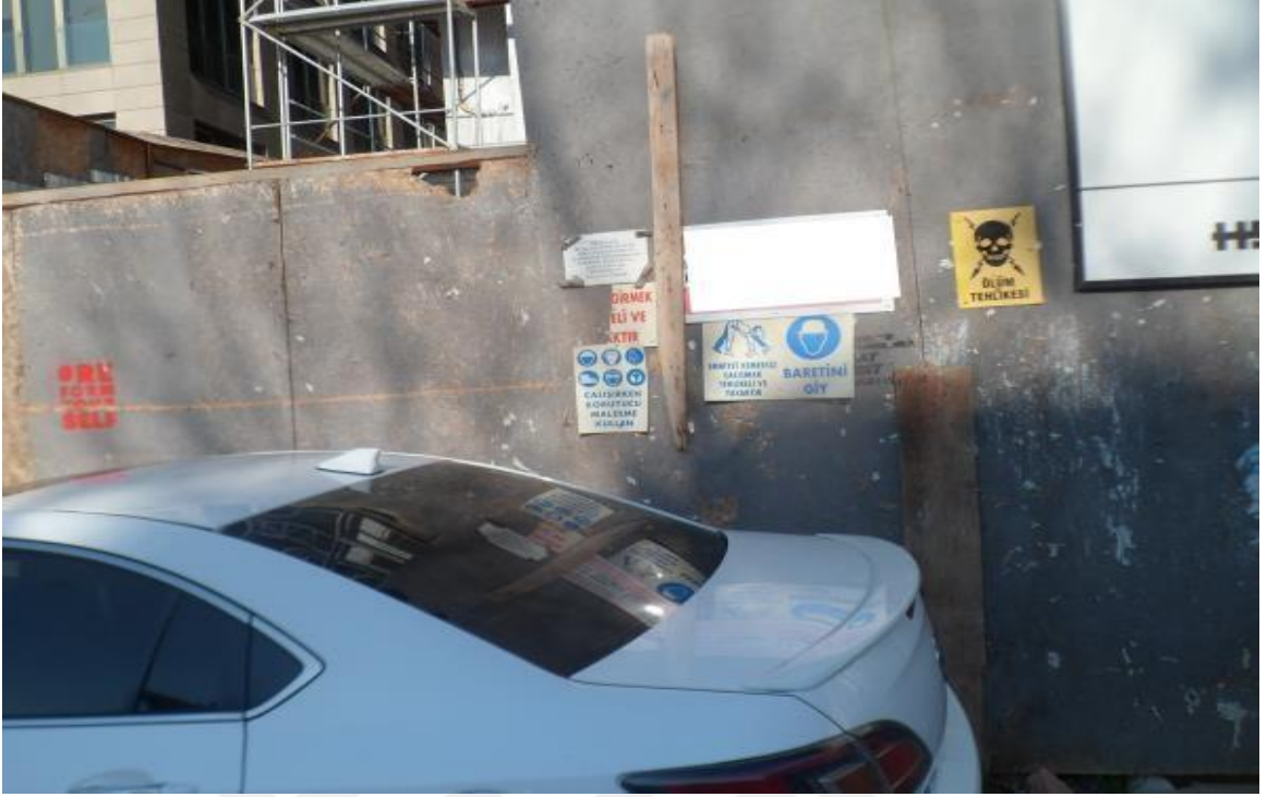
Resim 86: Sahrayı cedit mahallesi 63 nolu yapı şantiyesi ana giriş kapısı
