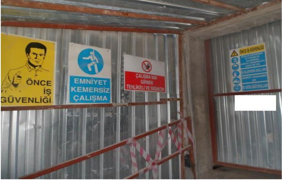
Resim 89: Fikirtepe mahallesi 79 nolu yapı şantiyesi sağ cepheden ana giriş kapısı
