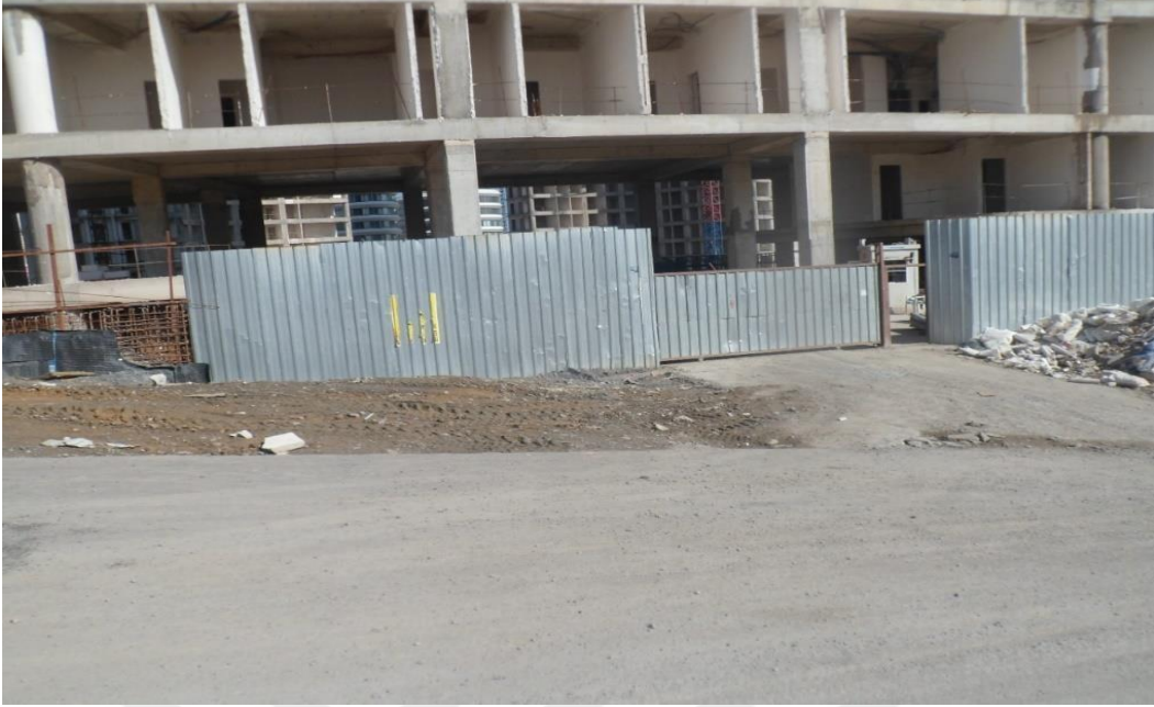
Resim 121: Merdivenköy mahallesi 70 nolu yapı şantiyesi ana giriş kapısı
