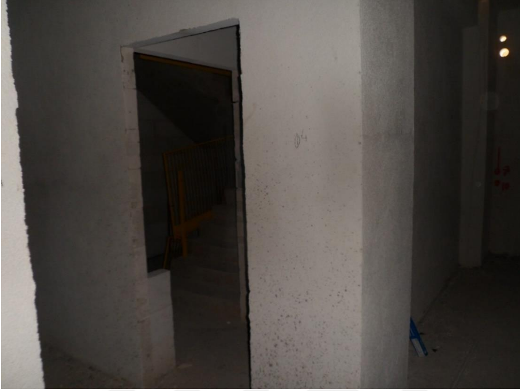
Resim 132: 19 Mayıs mahallesi 8 nolu yapı şantiyesi acil çıkış merdiveni
