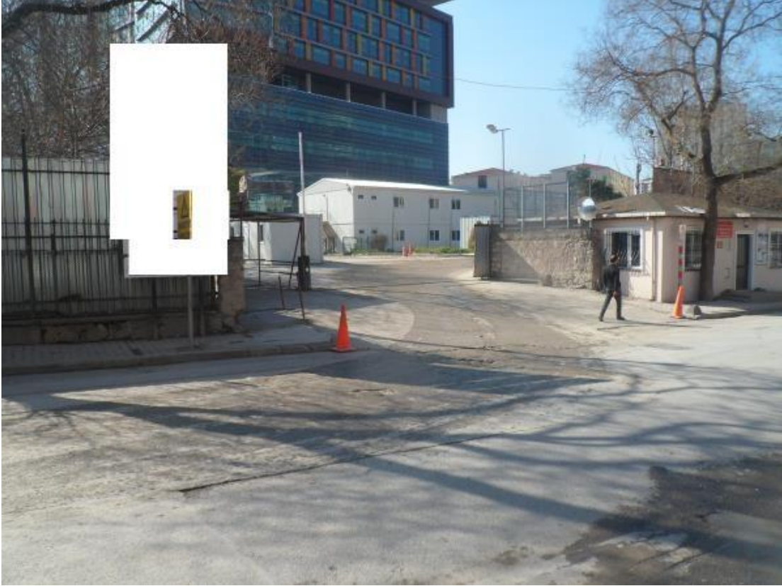
Resim 123: Merdivenköy mahallesi 72 nolu yapı şantiyesi ana giriş kapısı
