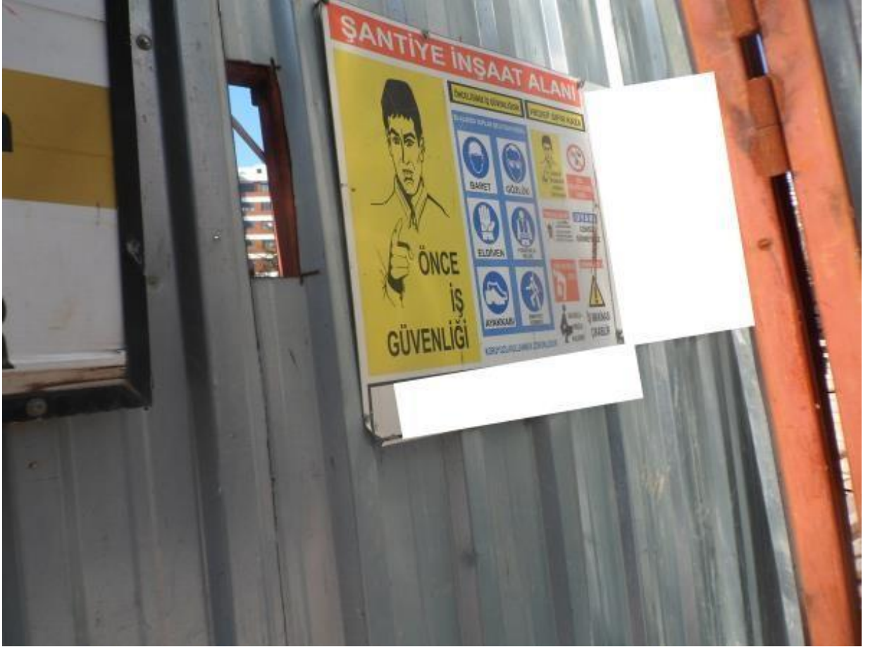
Resim 23: Feneryolu mahallesi 45 nolu yapı Őantiyesi ana giriŐ kapısı
