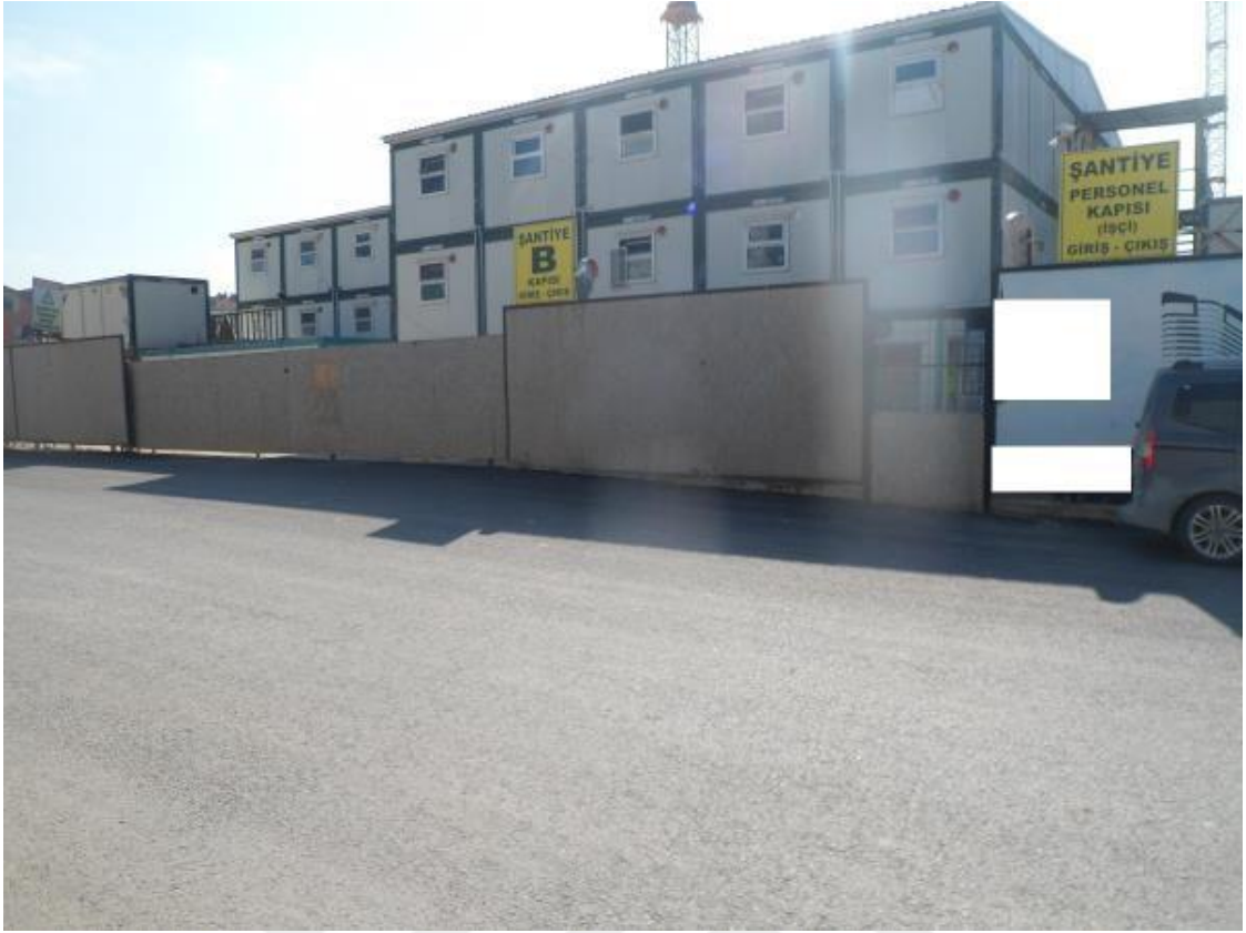
Resim 45: Dumlupınar mahallesi 73 nolu yapı şantiyesi personel giriş kapısı
