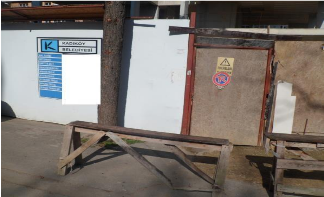
Resim 76: Feneryolu mahallesi 49 nolu yapı şantiyesi ana giriş kapısı
