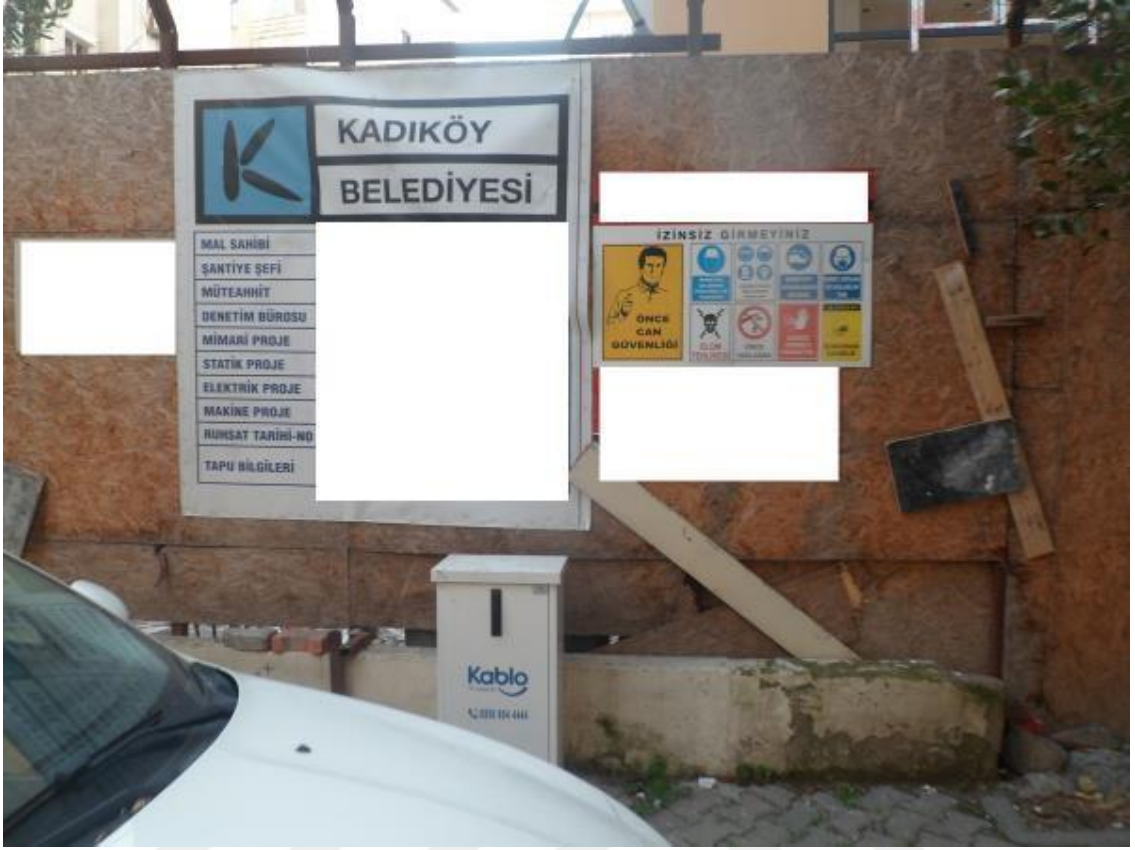
Resim 27: Feneryolu mahallesi 48 nolu yapı şantiyesi yaya giriş kapısı
