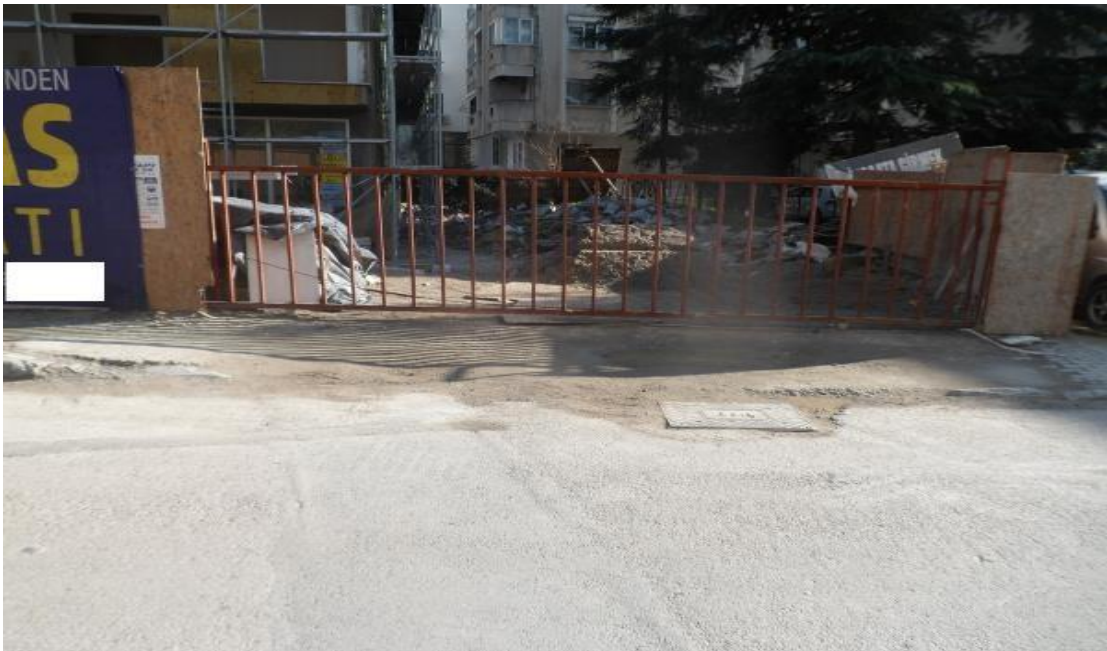
Resim 12: Göztepe mahallesi 19 nolu yapı şantiyesi araç ve yaya giriş kapısı
