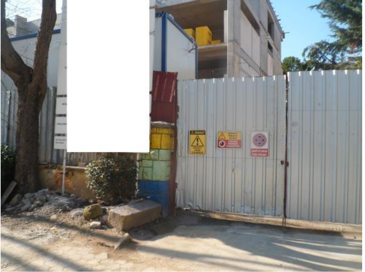
Resim 78: Feneryolu mahallesi 51 nolu yapı şantiyesi ana giriş kapısı
