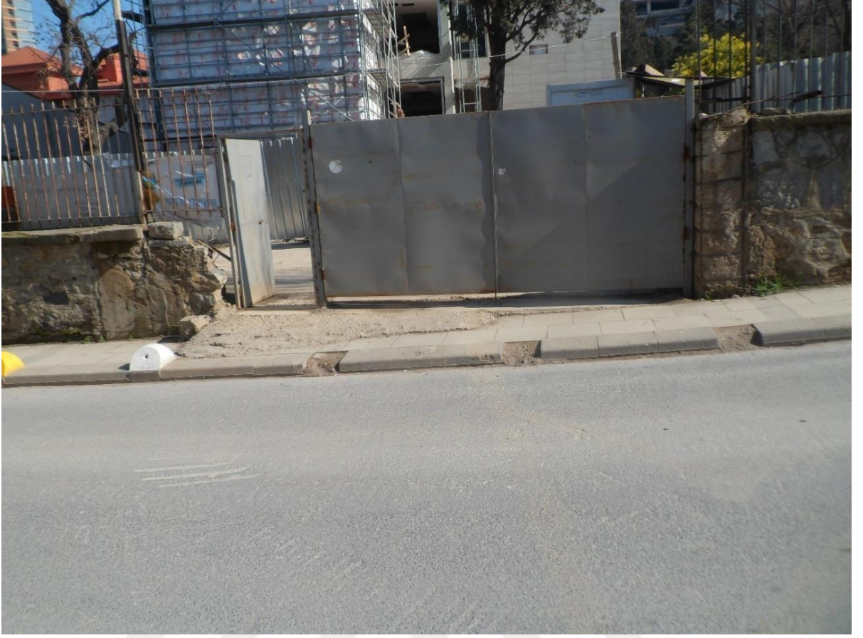
Resim 32: Eğitim mahallesi 53 nolu yapı şantiyesi araç ve yaya giriş kapısı
