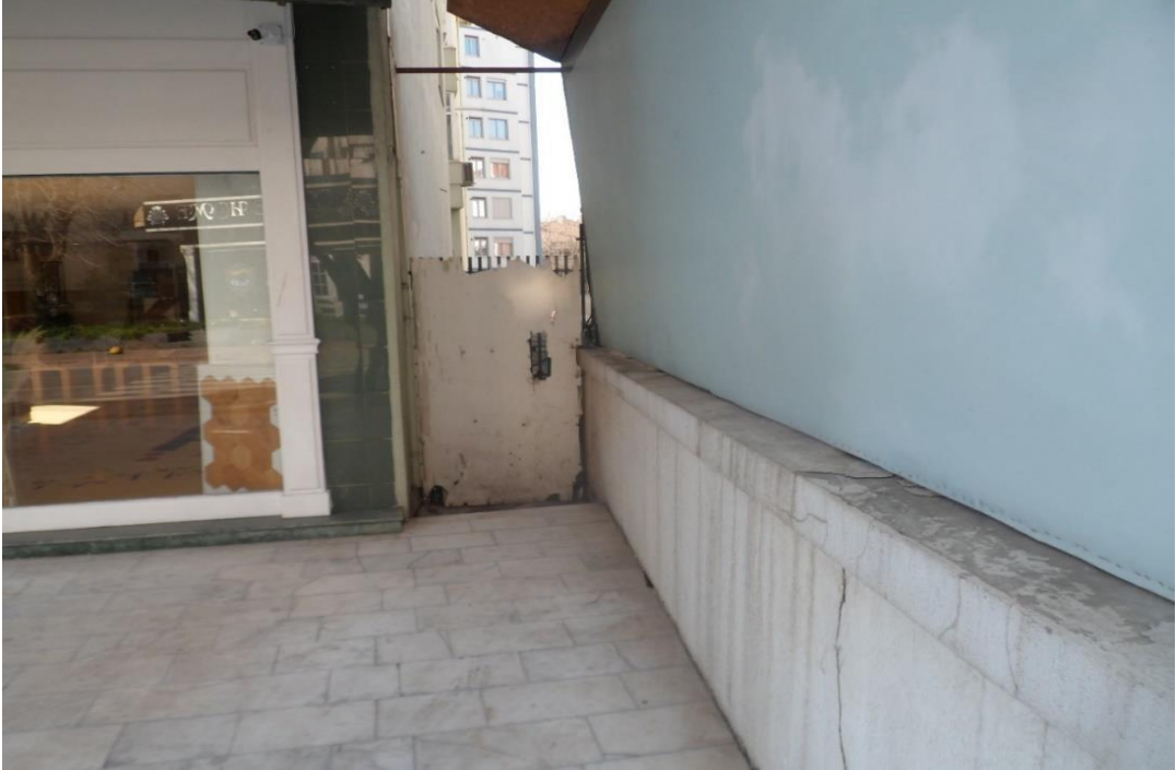
Resim 117: Zühtüpaşa mahallesi 59 nolu yapı şantiyesi yaya giriş kapısı
