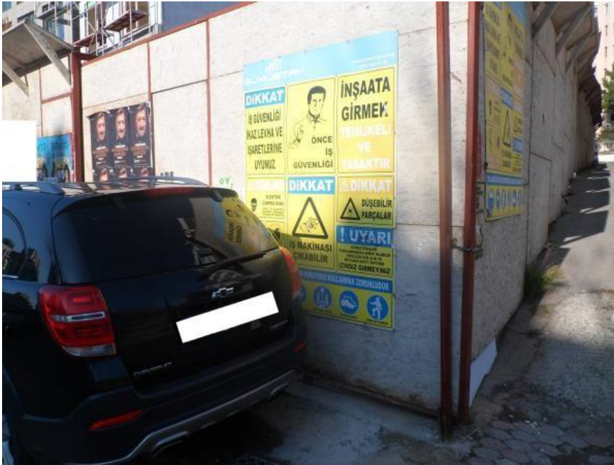
Resim 22: Feneryolu mahallesi 44 nolu yapı şantiyesi ana giriş kapısı
