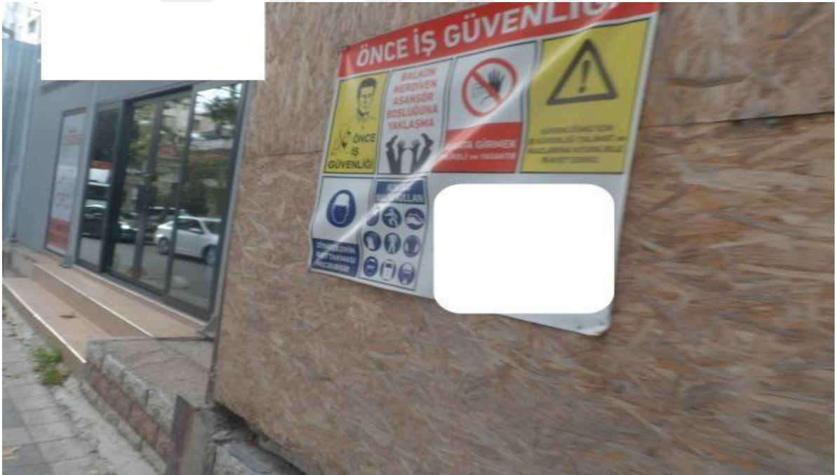
Resim 10: Erenköy mahallesi 11 nolu yapı şantiyesi yaya giriş kapısı
