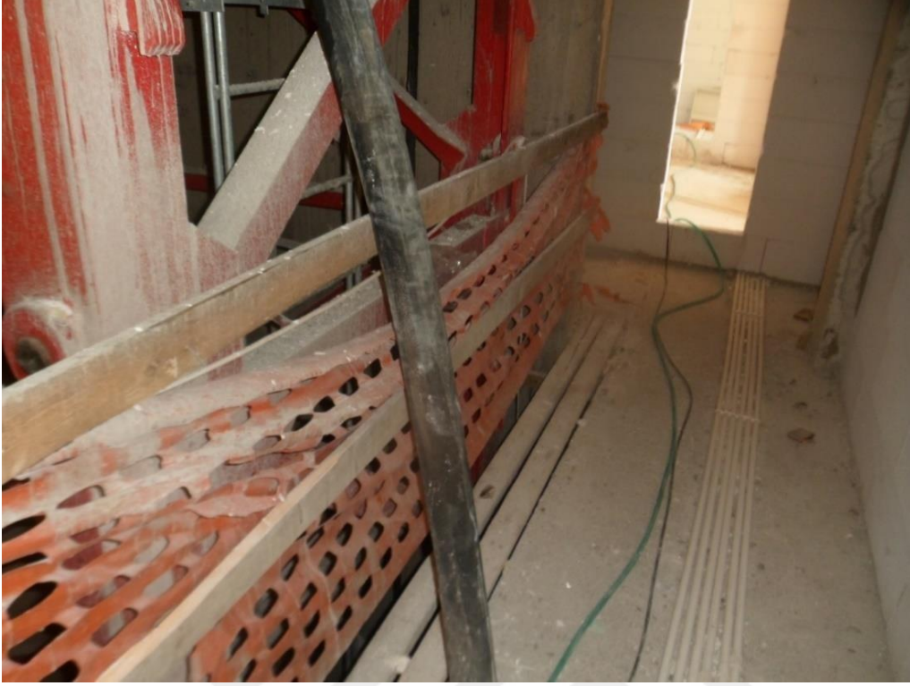
Resim 134: 19 Mayıs mahallesi 10 nolu yapı şantiyesi kat içerisi yürüyüş yolu
