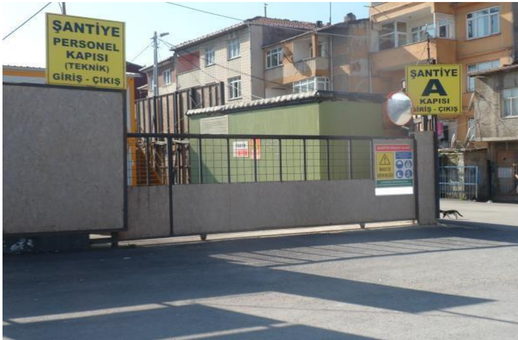
Resim 44: Dumlupınar mahallesi 73 nolu yapı şantiyesi teknik personel giriş kapısı
