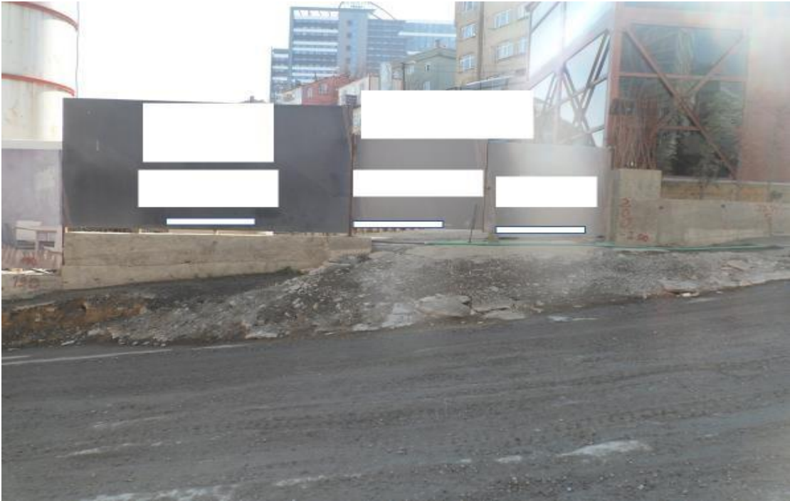
Resim 122: Merdivenköy mahallesi 71 nolu yapı şantiyesi ana giriş kapısı
