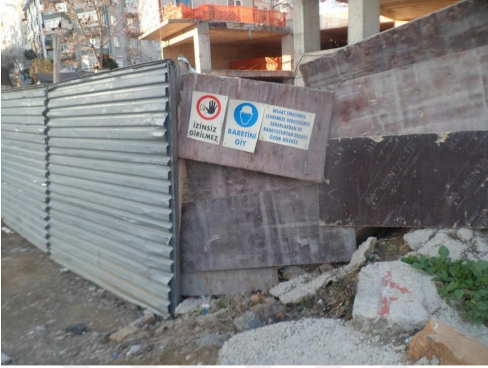
Resim 69: Bostancı mahallesi 24 nolu yapı şantiyesi yaya giriş kapısı
