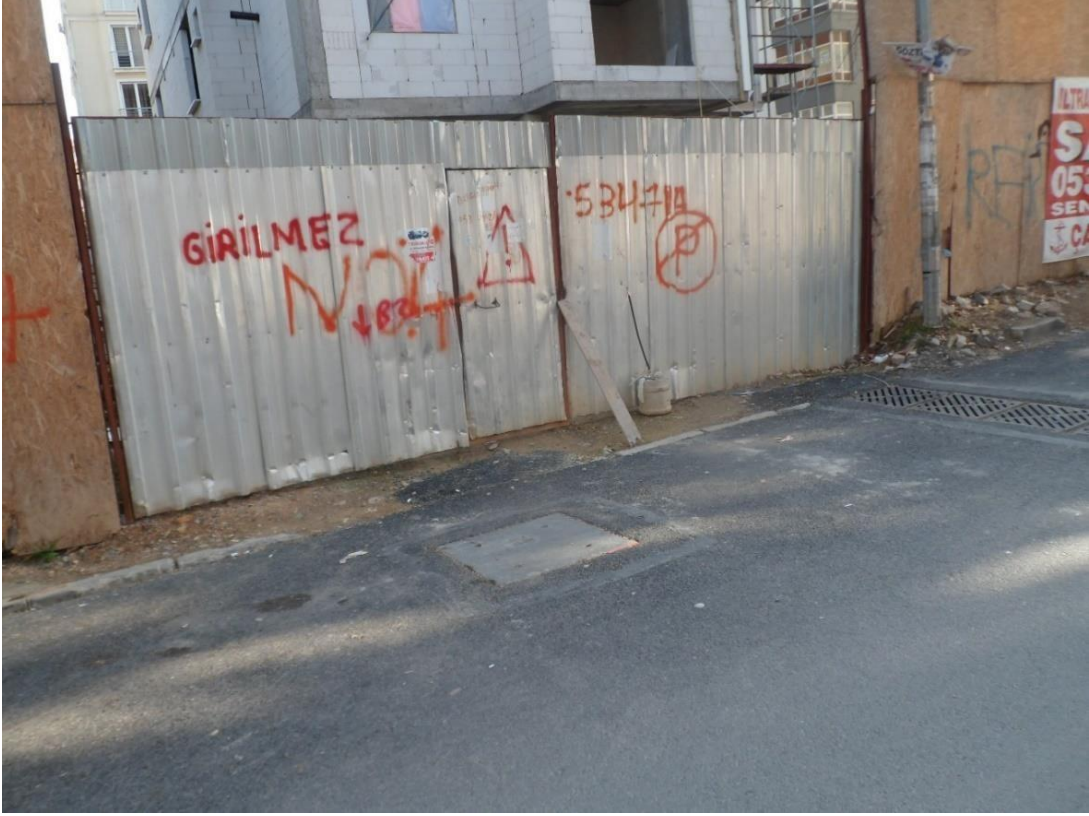
Resim 115: Eđitim mahallesi 56 nolu yapı Őantiyesi ana giriŐ kapısı
