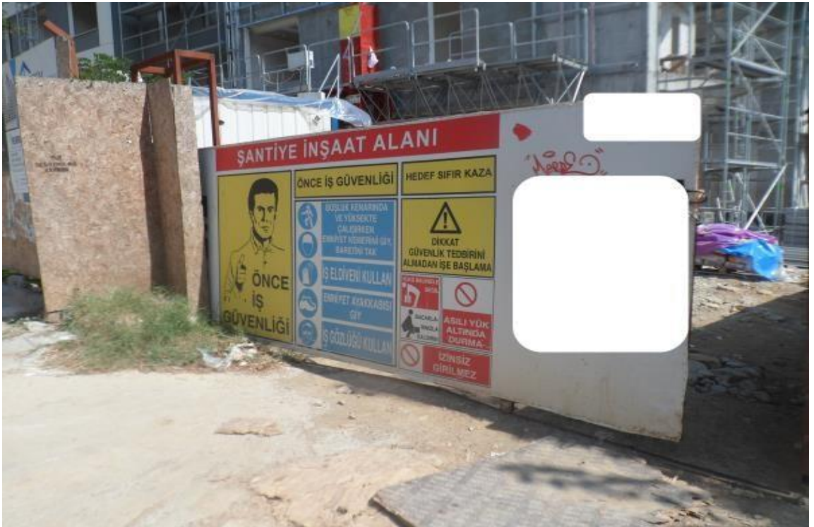
Resim 5: 19 Mayıs mahallesi 7 nolu yapı şantiyesi araç ve yaya giriş kapısı
