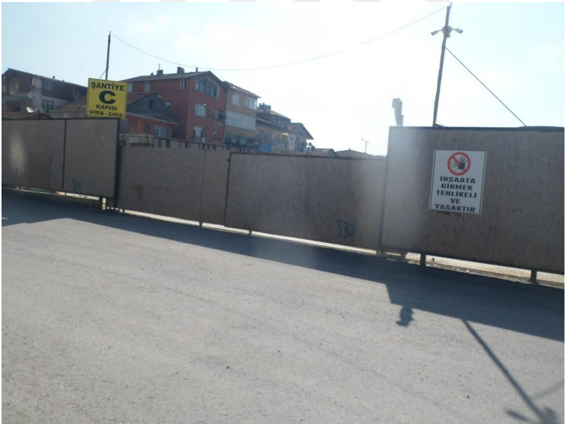
Resim 46: Dumlupınar mahallesi 73 nolu yapı şantiyesi araç giriş kapısı
