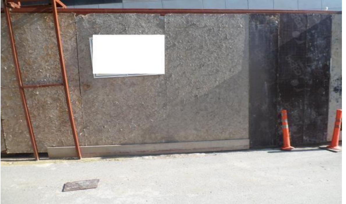
Resim 120: Sahrayı cedit mahallesi 64 nolu yapı şantiyesi ana giriş kapısı
