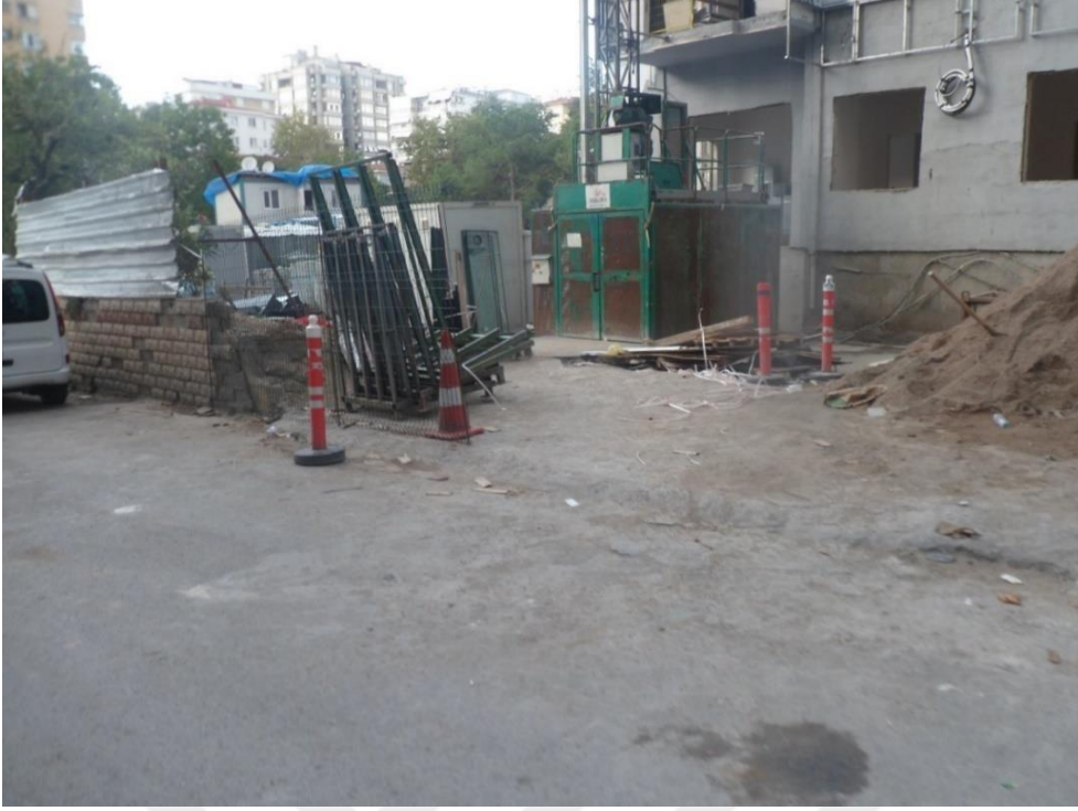
Resim 97: Erenk y mahallesi 14 nolu yapı Őantiyesi ana giriŐ kapısı
