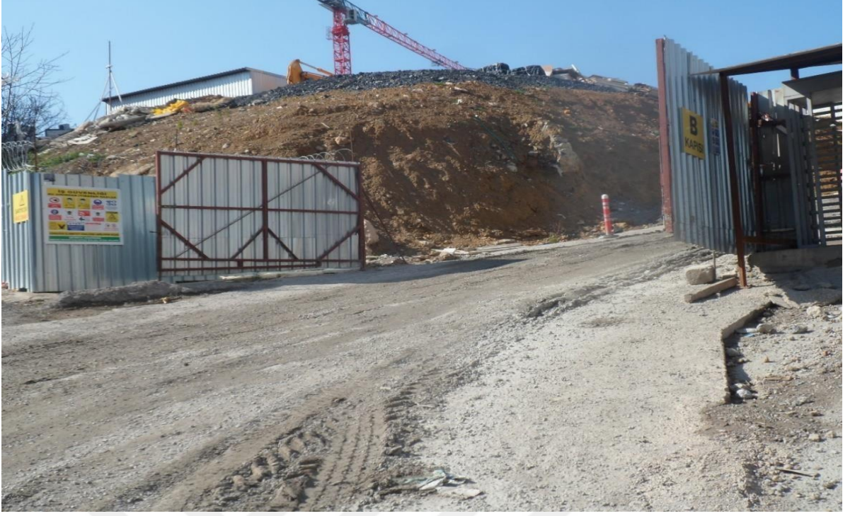
Resim 41: Merdivenköy mahallesi 66 nolu yapı şantiyesi ana giriş kapısı
