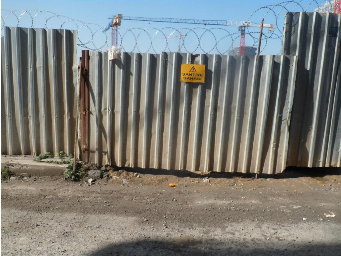
Resim 57: Fikirtepe mahallesi 78 nolu yapı şantiyesi yaya giriş kapısı
