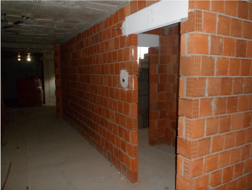
Resim 129: Kozyatağı mahallesi 2 nolu yapı şantiyesi acil çıkış merdiveni
