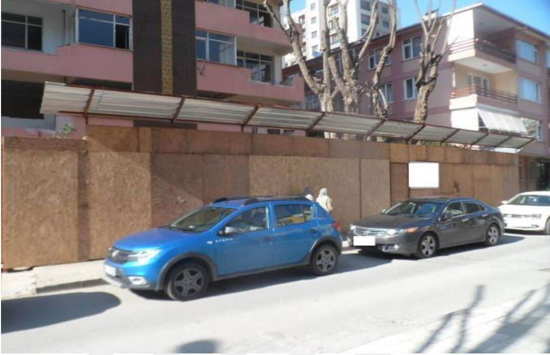
Resim 94: Kozyatağı mahallesi 5 nolu yapı şantiyesi ana giriş kapısı
