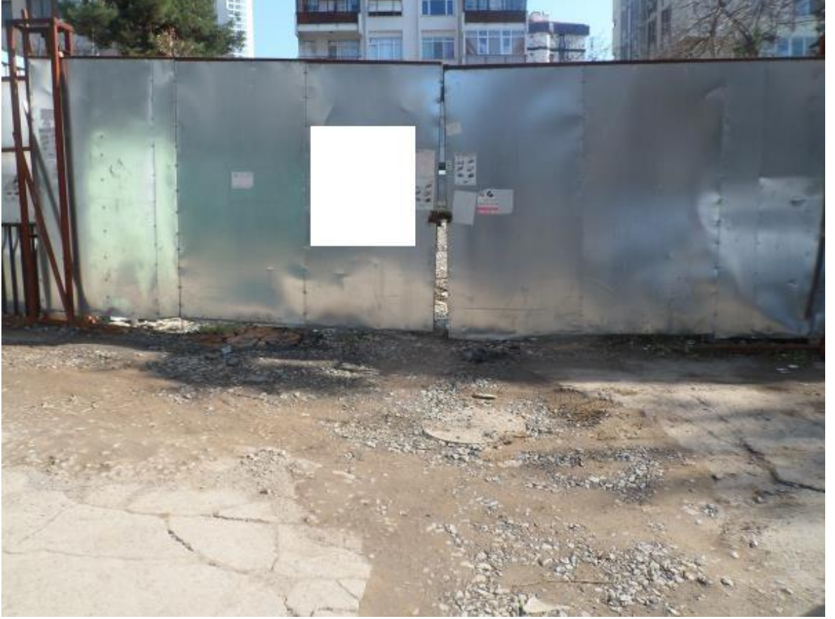
Resim 107: Fenerbahe mahallesi 37 nolu yapı Őantiyesi ana giriŐ kapısı
