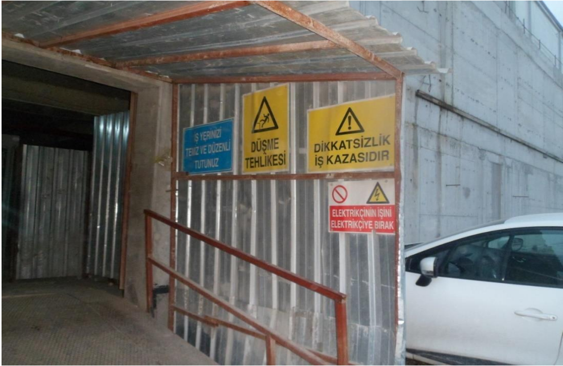
Resim 90: Fikirtepe mahallesi 79 nolu yapı şantiyesi sol cepheden ana giriş kapısı
