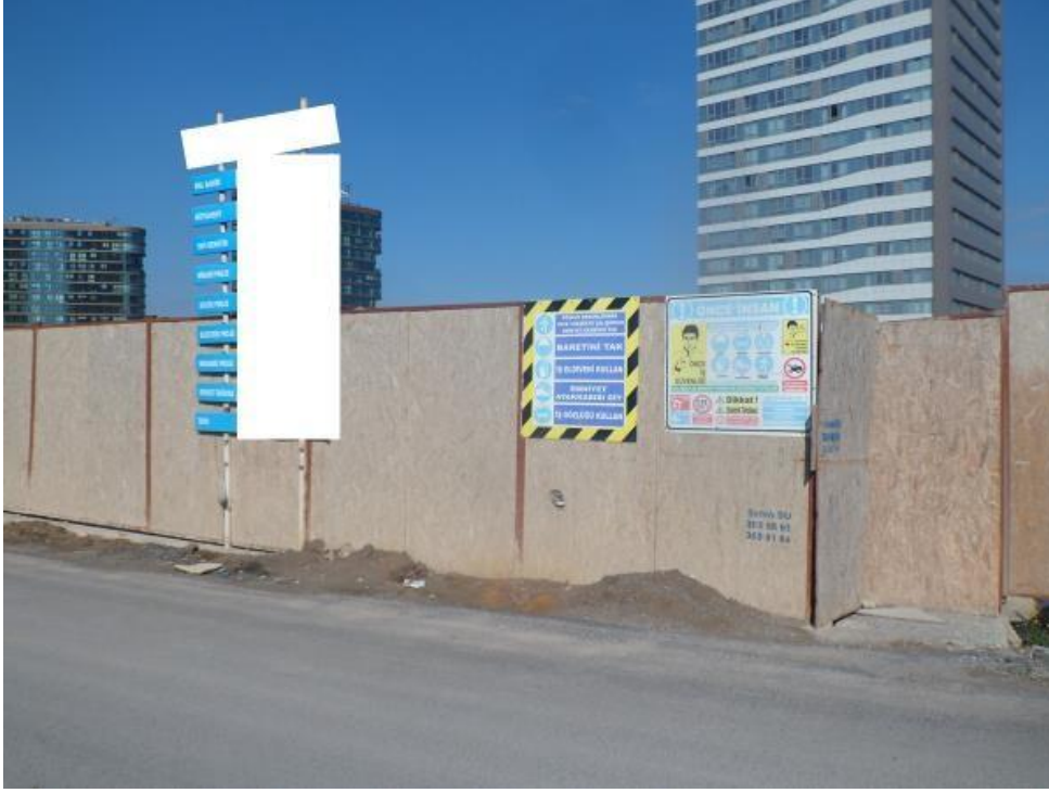
Resim 38: Merdivenköy mahallesi 65 nolu yapı şantiyesi ana giriş kapısı
