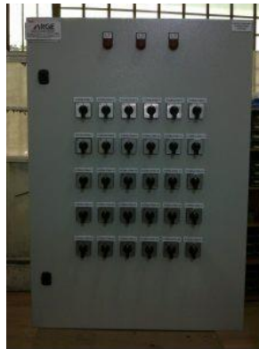
Şekil 10: Aydınlatma panosu
