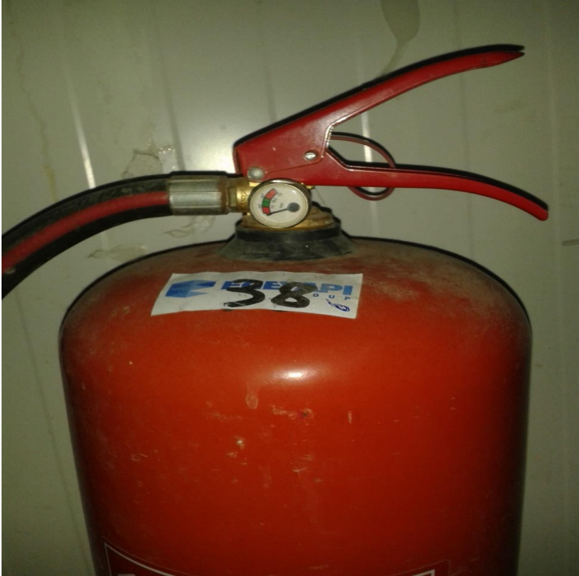
Resim 15: Basıncı düşmüş yangın tüpü
