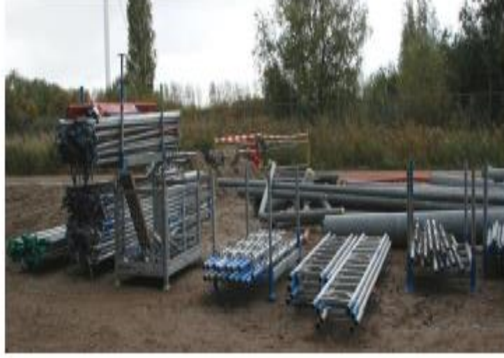
Sekil 3: İskele Malzemelerinin Cins Ve Ebatlarına Göre Uygun Olarak İstiflenmesi
