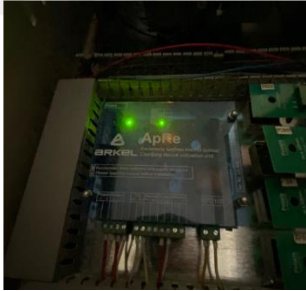
Şekil 16: Yolcu asansörü sistemi MCU görüntüsü
