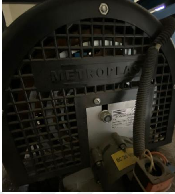
Şekil 15: Yolcu asansör sistemi hız regülatörü görüntüsü
