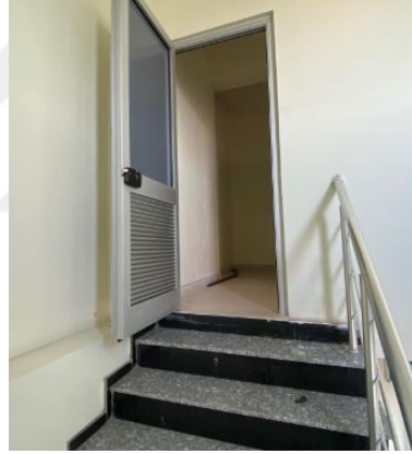
Şekil 12: Yolcu asansörü makine dairesi giriş görüntüsü
