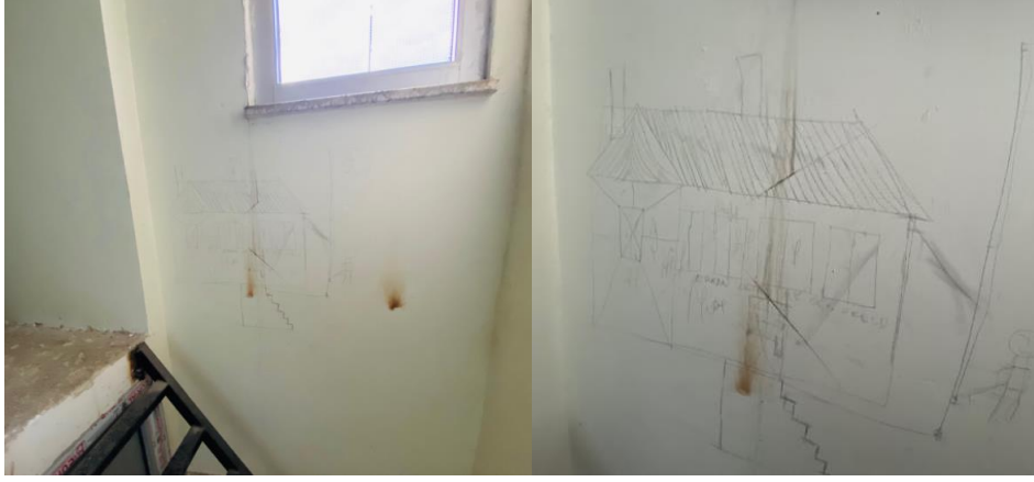
Şekil 17: Yolcu asansör sistemi makine dairesi duvar görüntüsü
