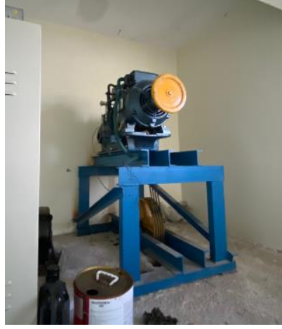
Şekil 13: Yolcu asansörü sistemi kabin hareket motoru ve kasnak görüntüsü
