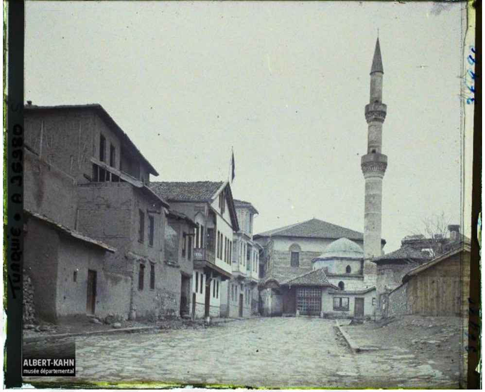
Resim 2.10. Hacı Bayram Cami ve Afgan Elçiliği Binası. (1922) 151
