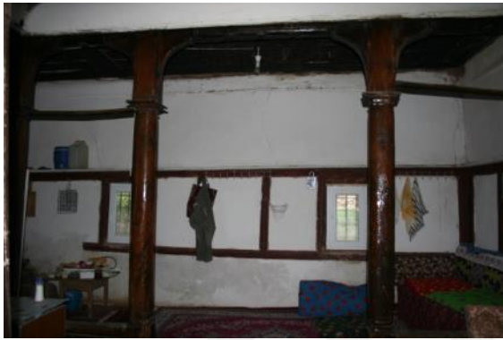
Resim 4.27.5. Güney duvarı, pencereler
