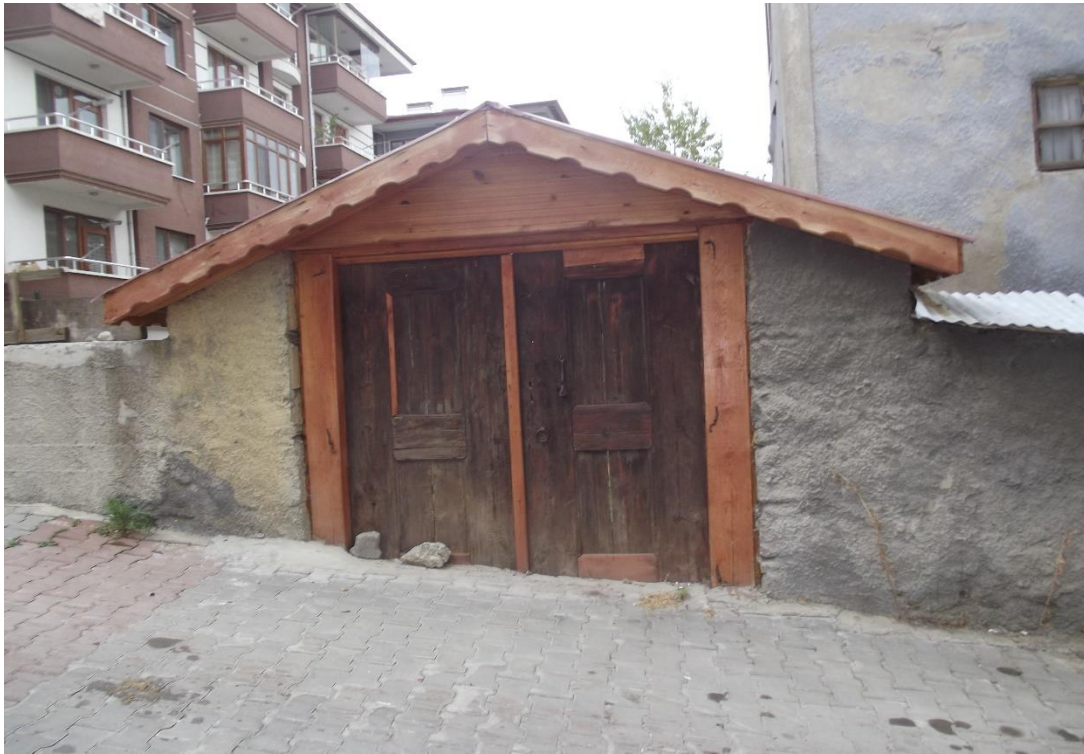
Resim 4.22. Olgaçlar Konağı kuzeybatı bahçe giriş kapısı
