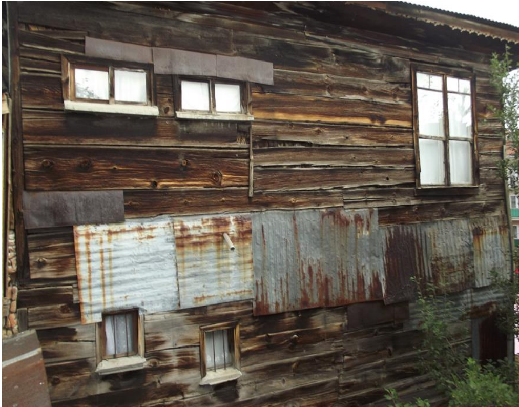
Resim 4.45. Saraç Emin evi batı cephe görünüşü
