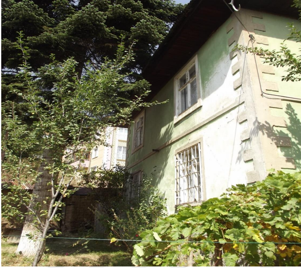
Resim 4.93. Terzi Kenan Dede'nin evi batı cephe görünüşü
