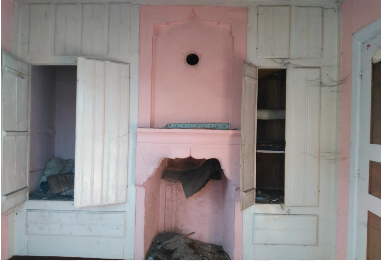
Resim 4.176. Kuzuların evi birinci kat batıdaki odada bulunan ocak ve dolaplar
