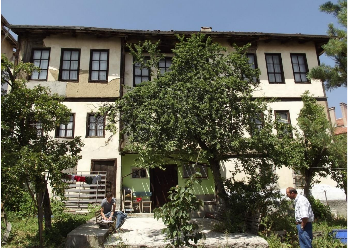
Resim 4.190. Darendeler Konağı güney cephe görünüşü
