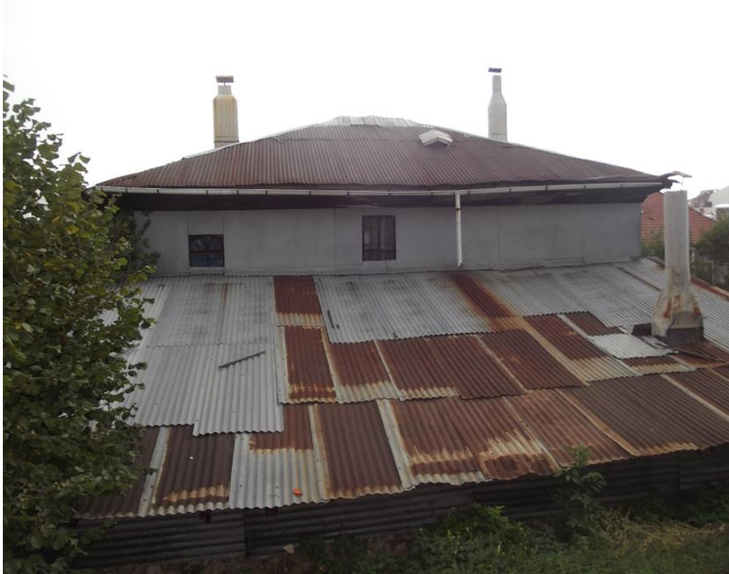
Resim 4.43. Saraç Emin evi kuzey cephe görünüşü
