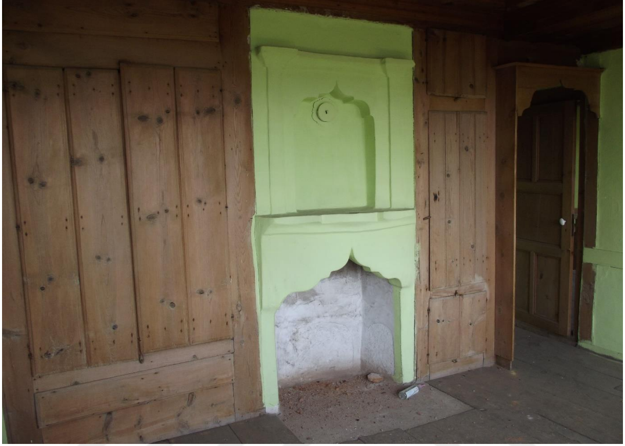
Resim 4.207. Darendeler Konağı ikinci kat batı oda giriş, ocak ve dolap uygulamaları
