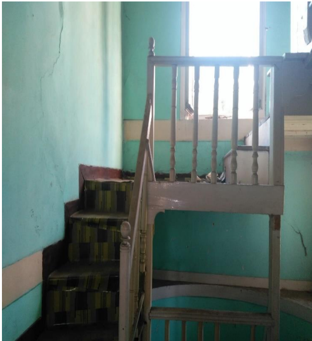
Resim 4.187. Kuzuların evi ikinci kat seki ve çatı arası çıkış merdiveni
