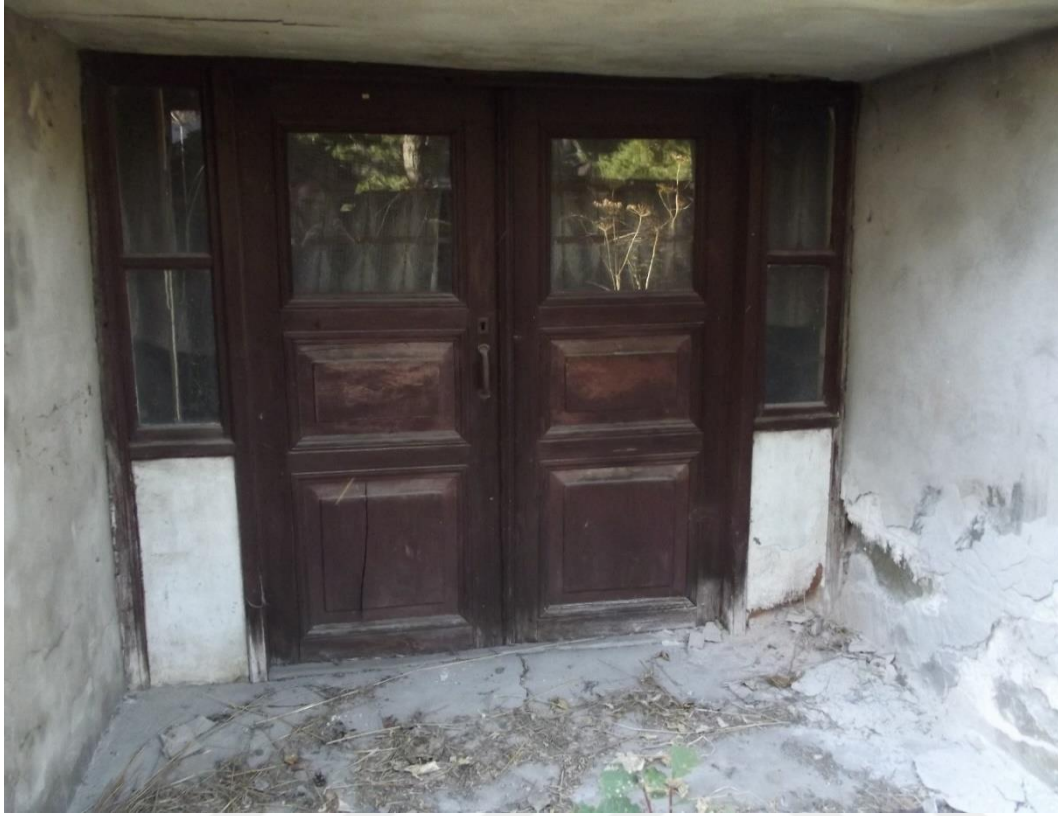
Resim 4.169. Kuzuların evi zemin kat giriş kapısı
