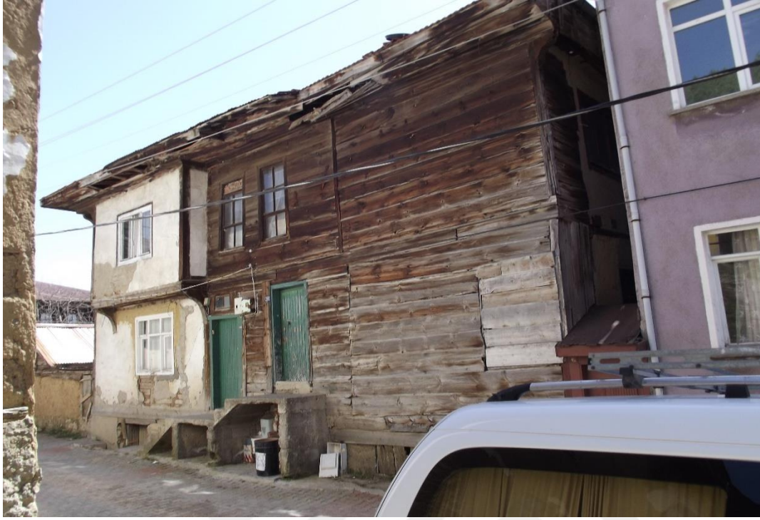
Resim 4.310. Durmuş Hoca'nın evi kuzeydoğudan görünüşü
