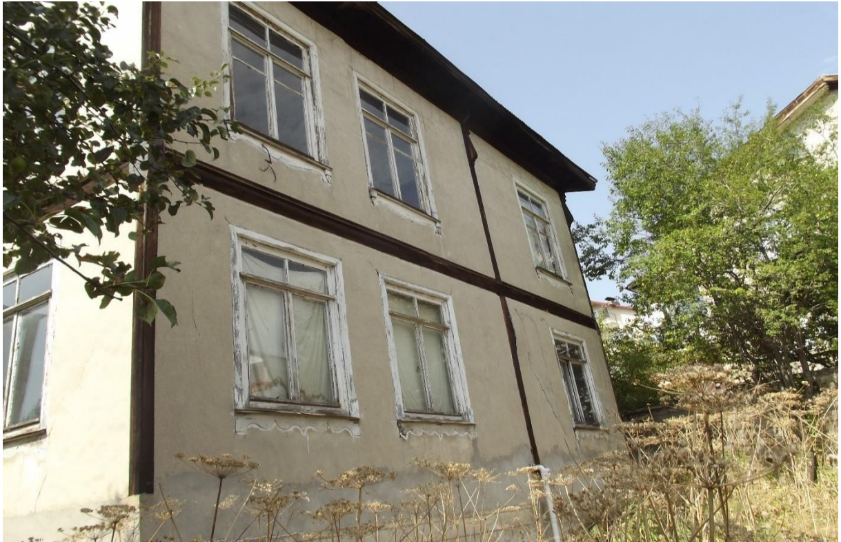
Resim 4.168. Kuzuların evi doğu cephe görünüşü
