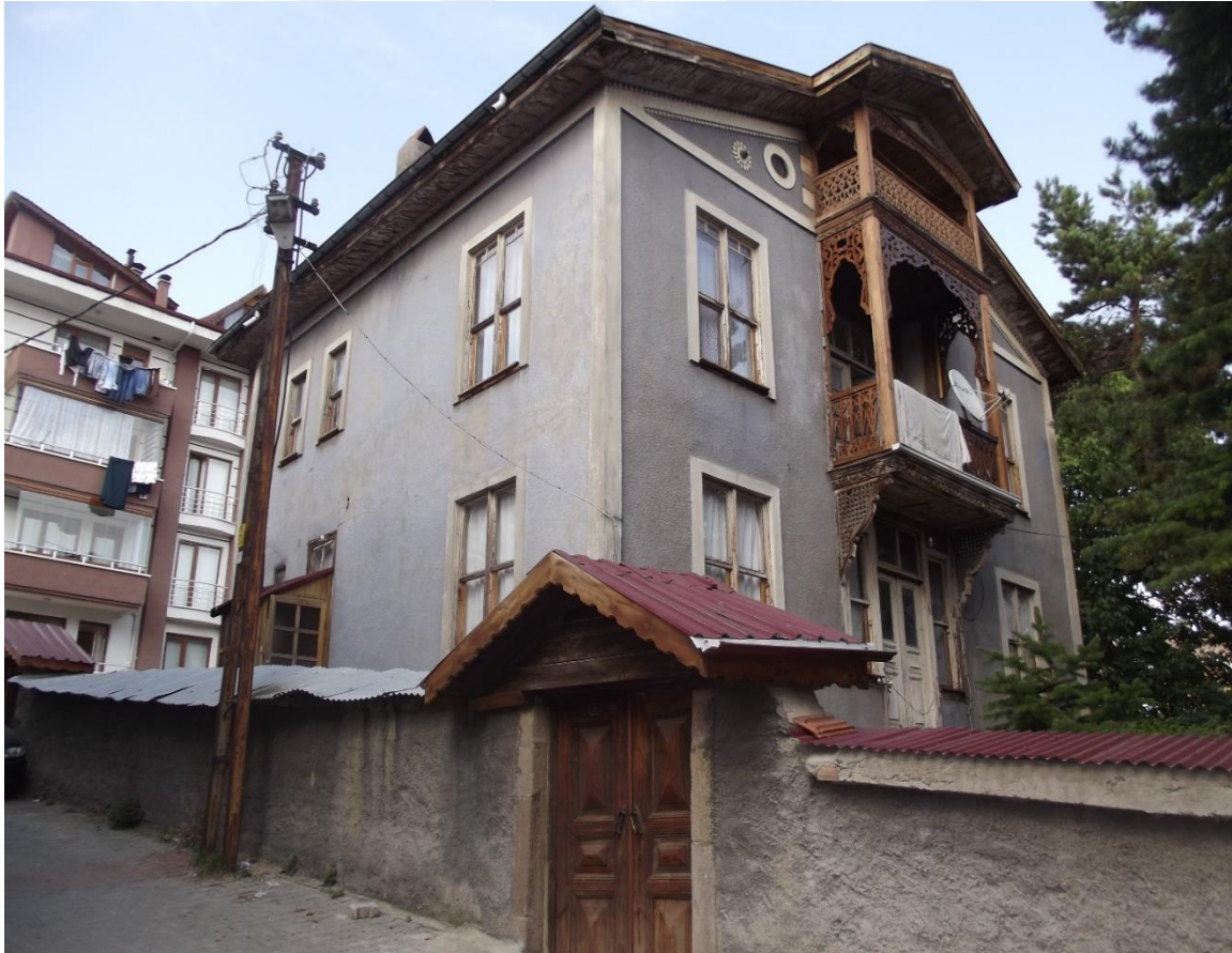
Resim 4.16. Olgaçlar Konağı genel görünüş
