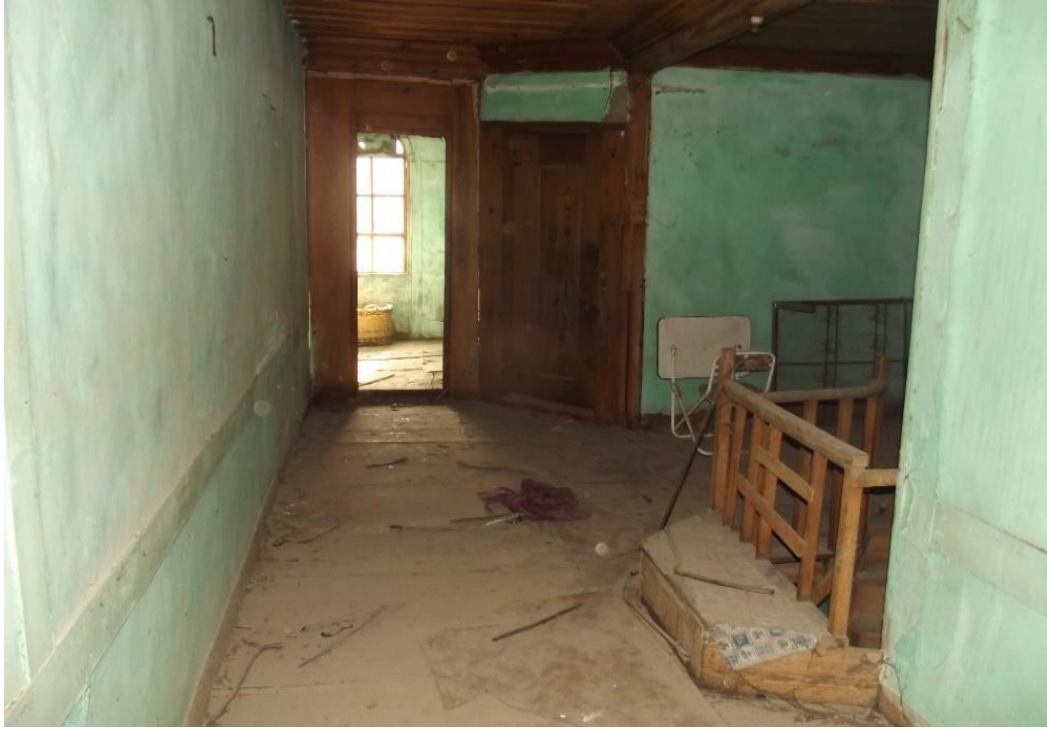
Resim 4.278. Eski Hükümet Konağı birinci kat sofa
