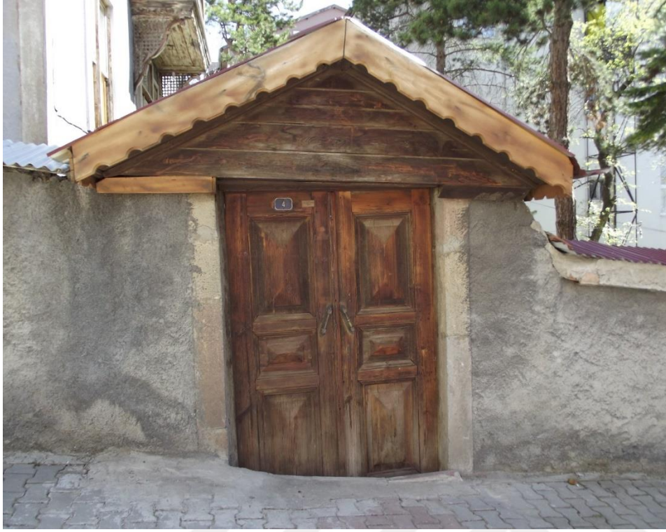
Resim 4.23. Olgaçlar Konağı güneybatı bahçe giriş kapısı
