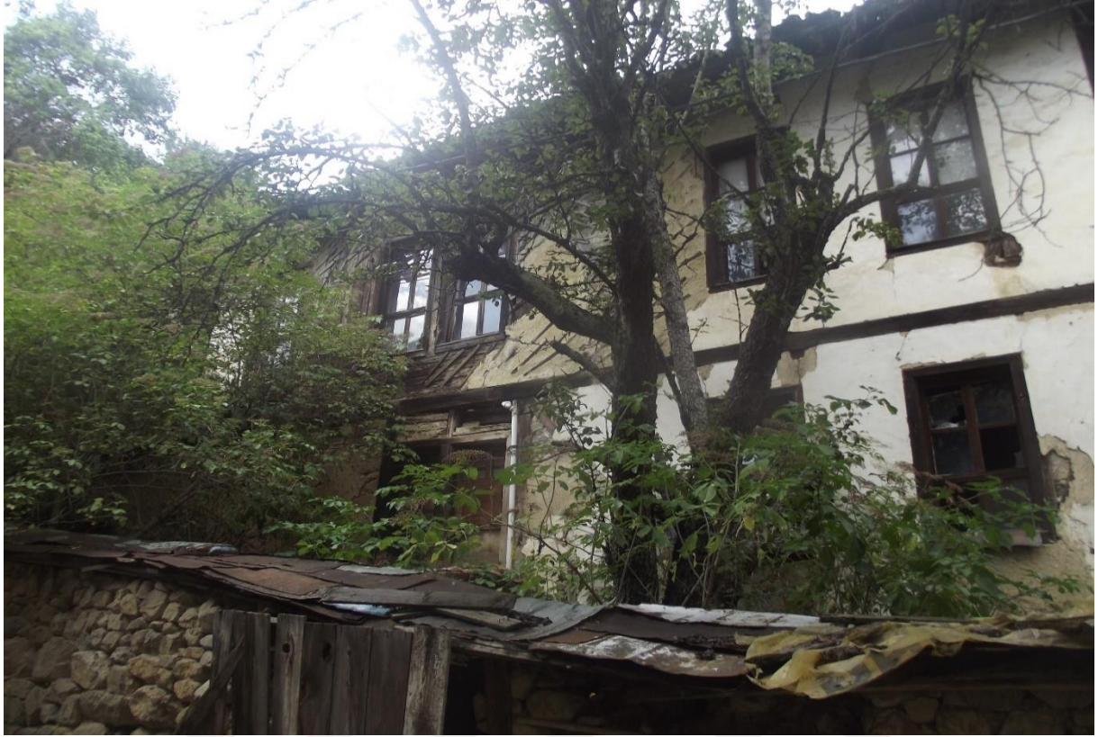
Resim 4.137. Camcı Orhan'ın evi güney cephe görünüşü
