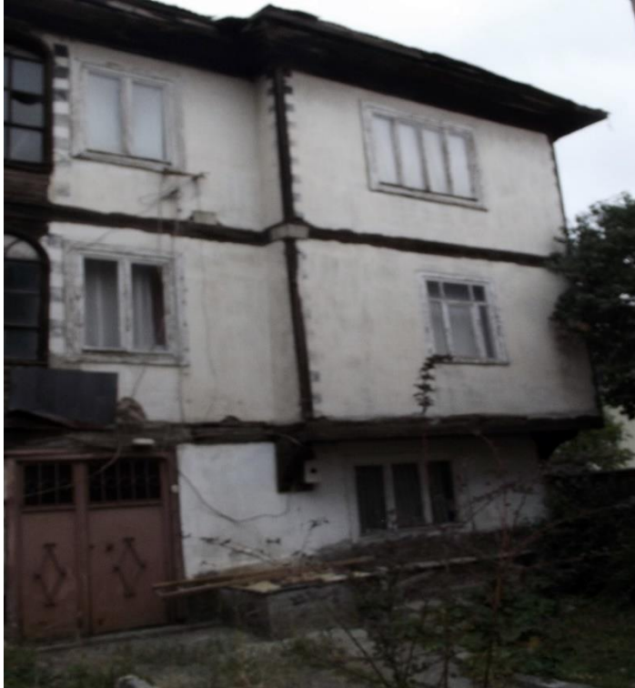
Resim 4.259. Hasan Güzelce evi güney cephe görünüşü
