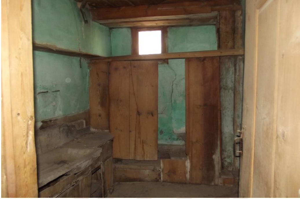
Resim 4.284. Eski Hükümet Konağı birinci kat tuvalet bölümü
