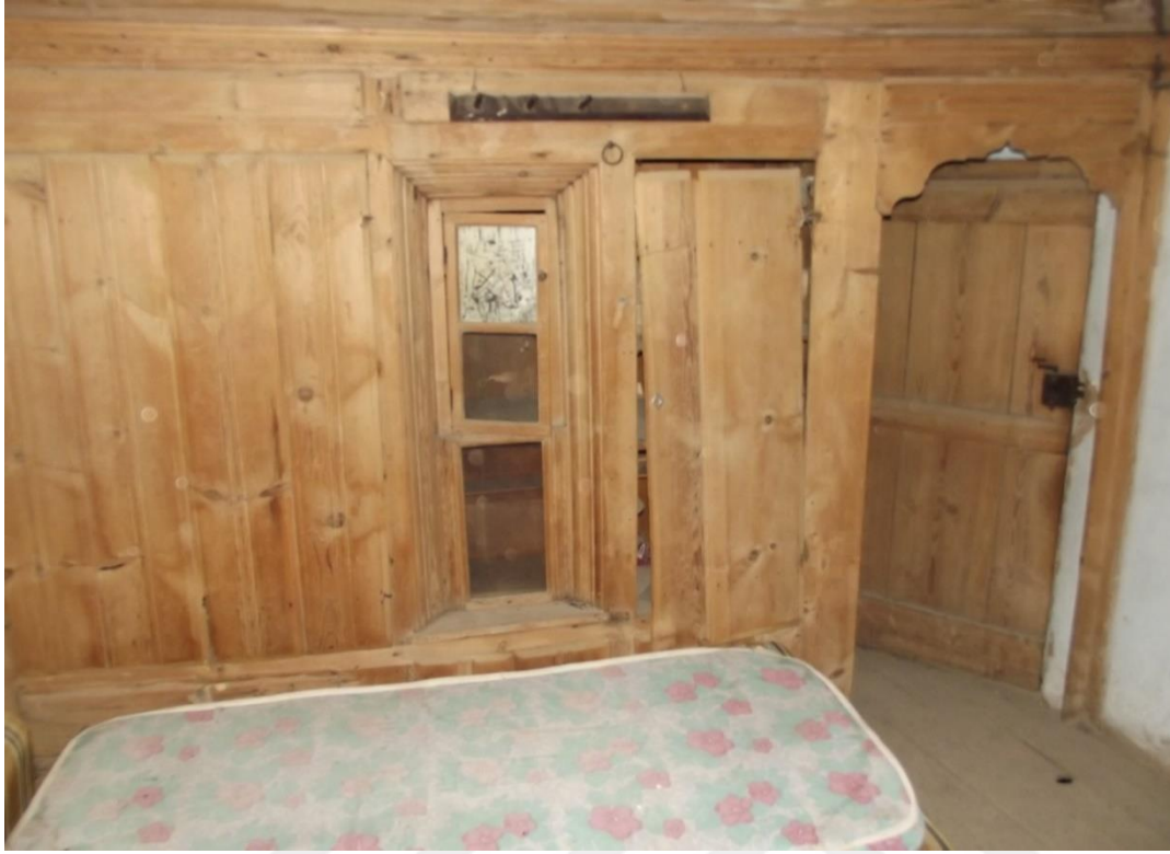
Resim 4.252. Mercanlar evi birinci kat kuzeydoğu oda giriş ve dolap uygulaması
