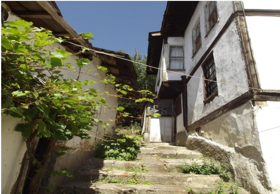
Resim 4.228. Taraşlar Konağı batı cephe görünüşü
