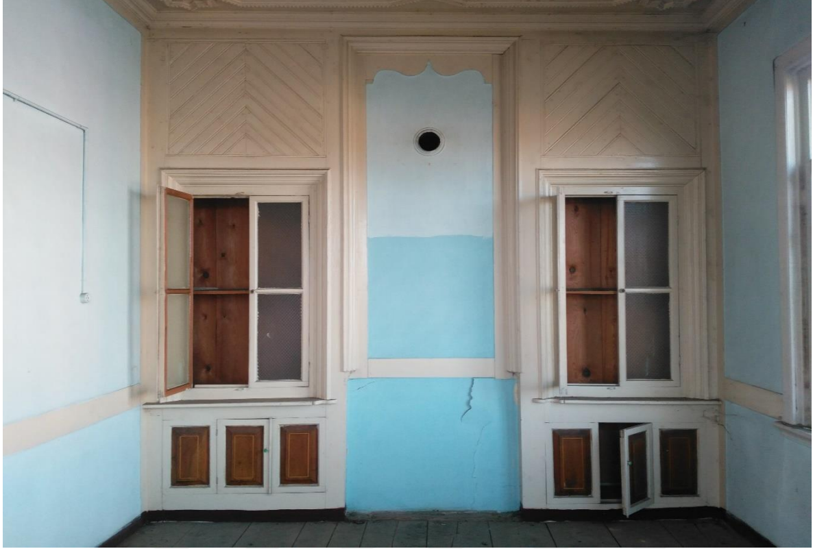
Resim 4.184. Kuzuların evi ikinci kat doğu odada bulunan baca ve dolap uygulaması
