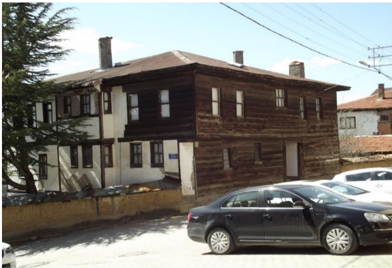
Resim 4.214. Çarıkçılar Konağı kuzeydoğudan görünüşü
