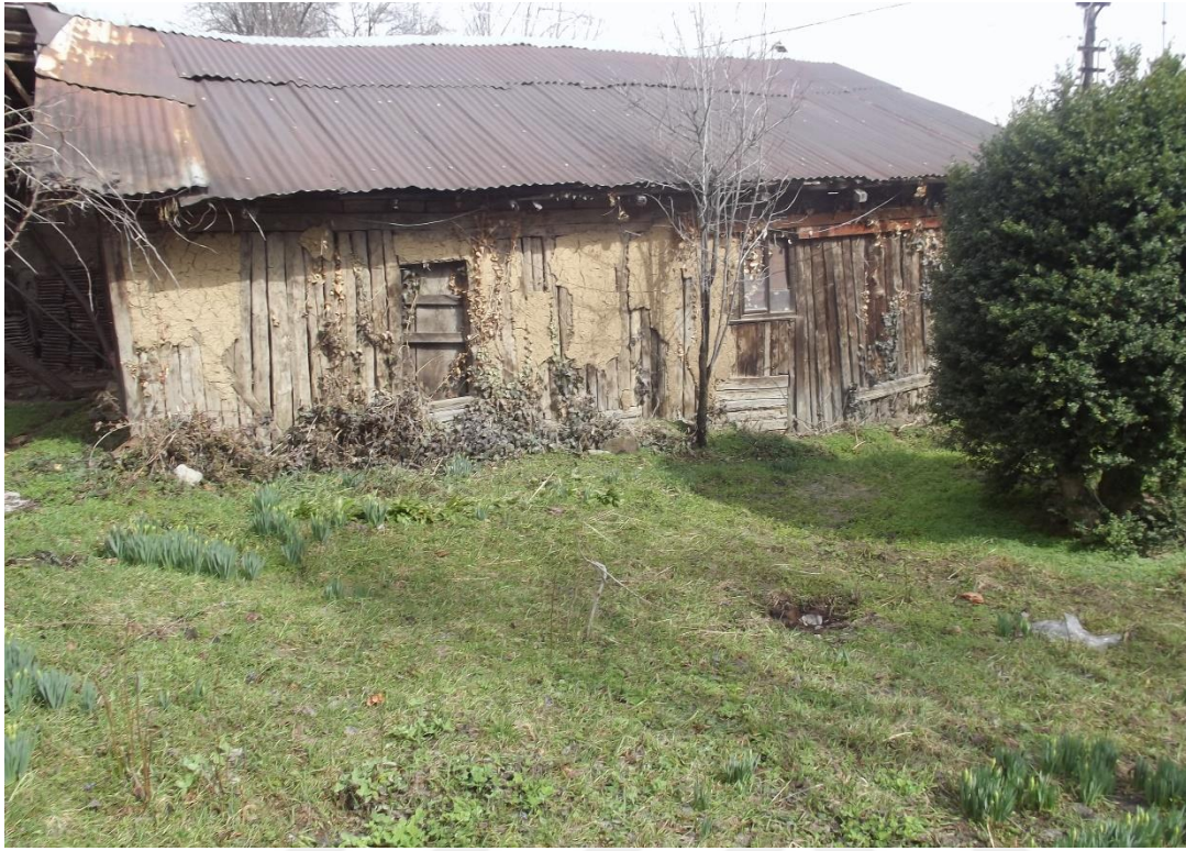
Resim 4.97.Kuşlar'ın Hafız'ın evi bahçede yer alan hizmet bölümü
