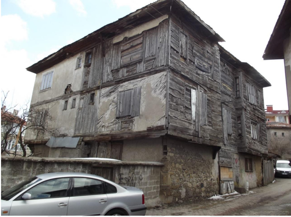
Resim 4.273. Eski Hükümet Konağı kuzeybatıdan görünüşü
