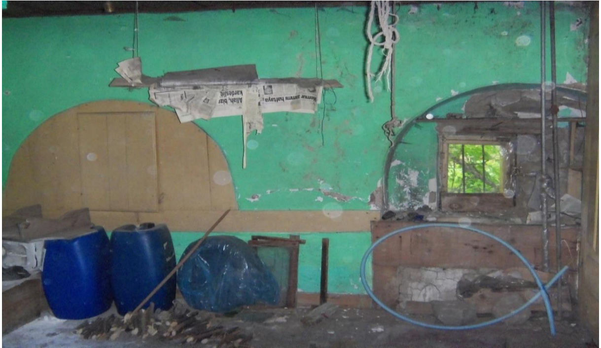
Resim 4.142. Camcı Orhan'ın evi zemin kat sofanın güneydoğusunda bulunan odada yer alan kemerli bölümler
