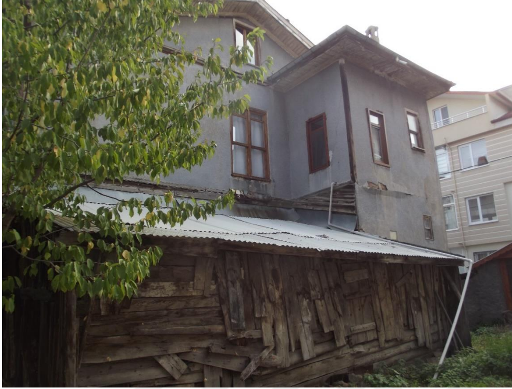
Resim 4.19. Olgaçlar Konağı kuzey cephe görünüşü
