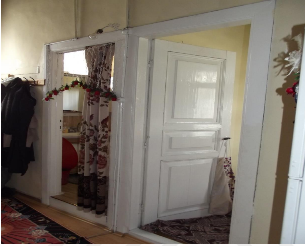
Resim 4.31. Olgaçlar Konağı ikinci kat sofaya hazırlık bölümü
