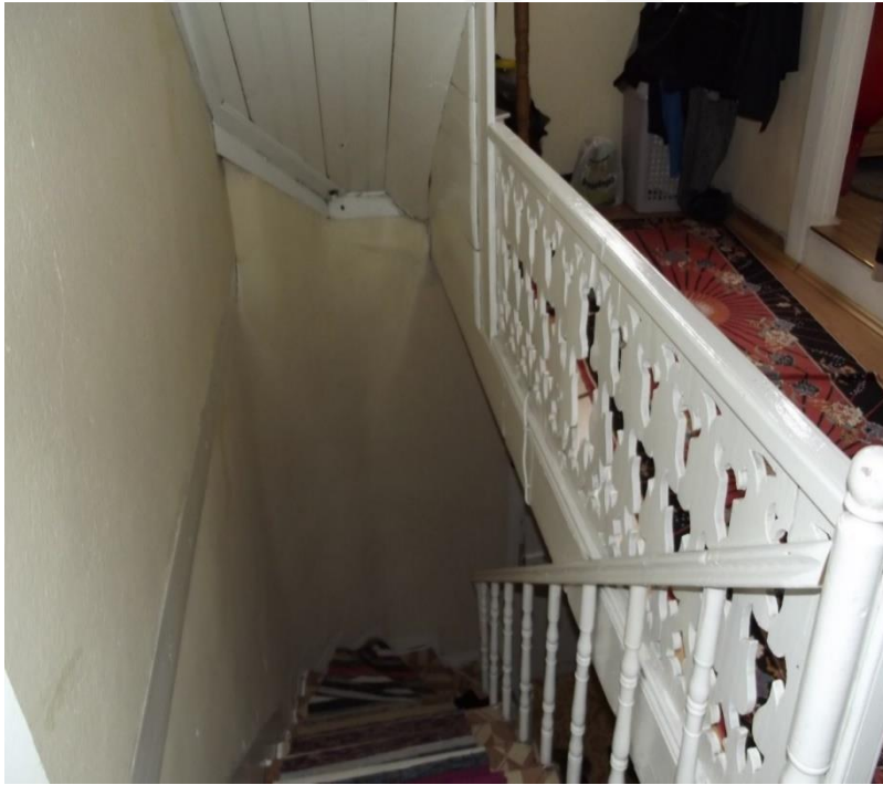
Resim 4.30. Olgaçlar Konağı ikinci kat çıkış merdiveni
