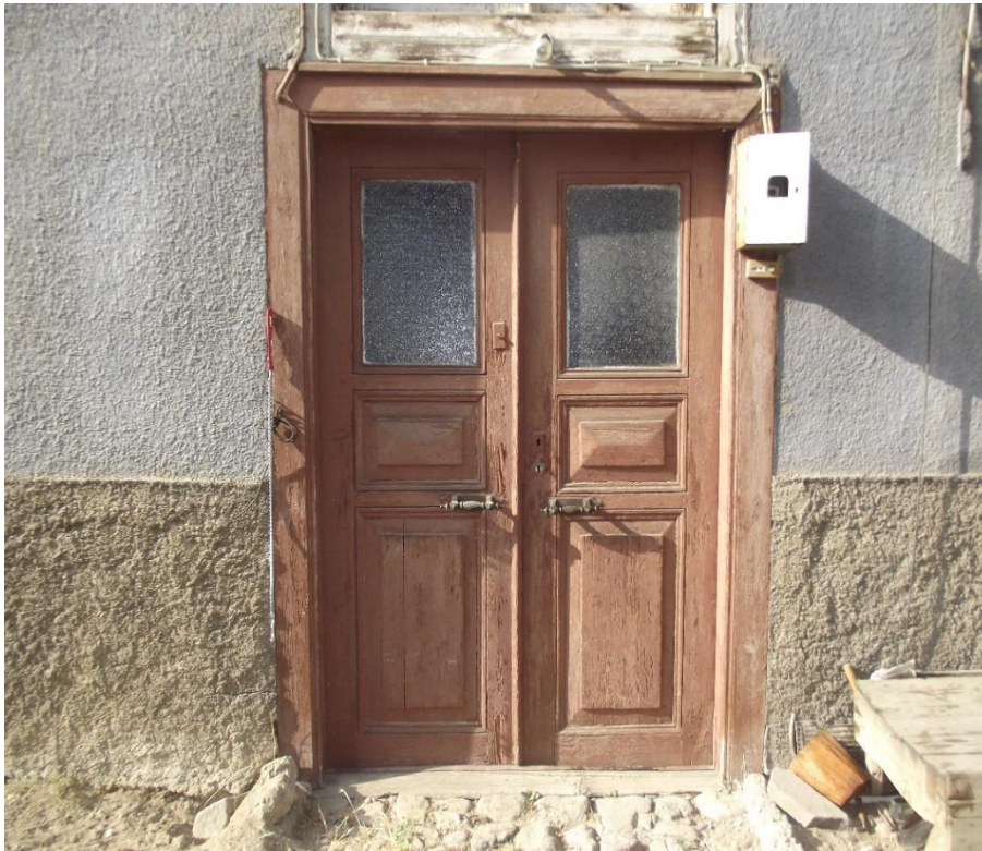
Resim 4.18. Olgaçlar Konağı güney cephe giriş kapısı
