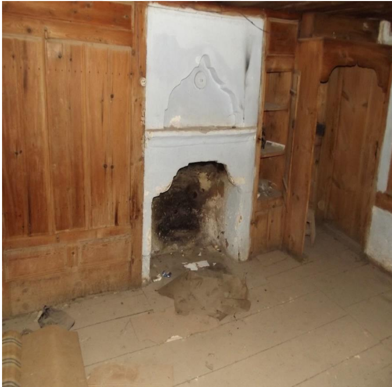
Resim 4.253. a) Mercanlar evi birinci kat kuzeybatı oda giriş, ocak ve dolap uygulaması
