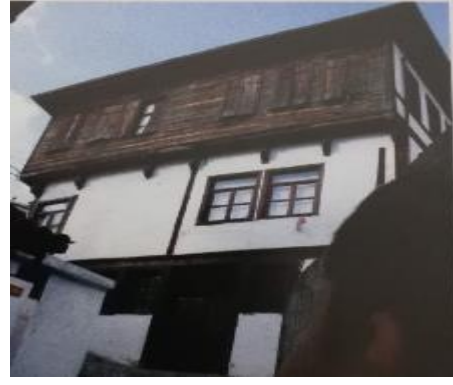
Resim 4.344. Göynük'ten cephe ahşap kaplama örneği (Yasa 2013)
