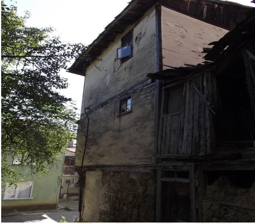
Resim 4.113. Hacı Baki'nin evi kuzey cephe görünüşü
