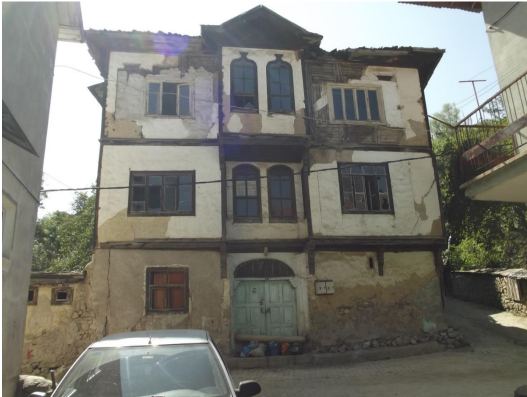
Resim 4.110. Hacı Baki'nin evi doğu cephe görünüşü
