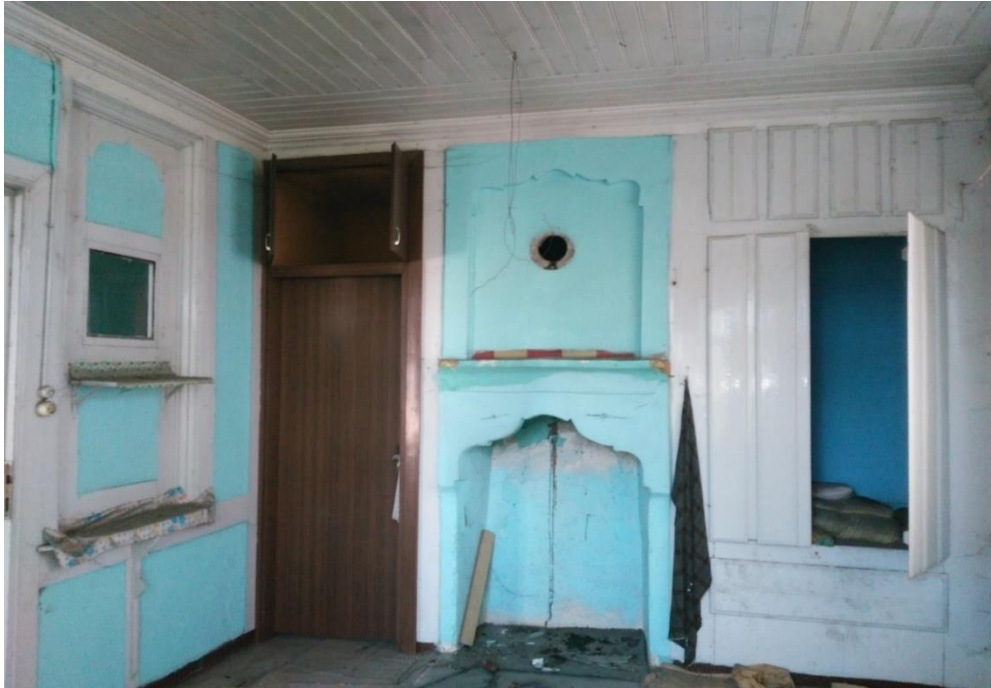
Resim 4.175. Kuzuların evi birinci kat doğudaki odada bulunan ocak, dolap ve çiçeklik uygulaması
