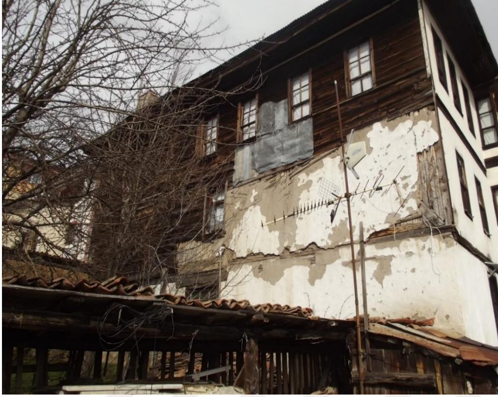
Resim 4.217. Çarıklılar Konağı batı cephe görünüşü
