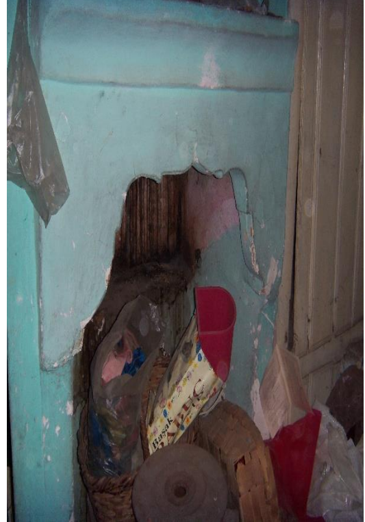
b) Ocak ve dolap uygulaması
