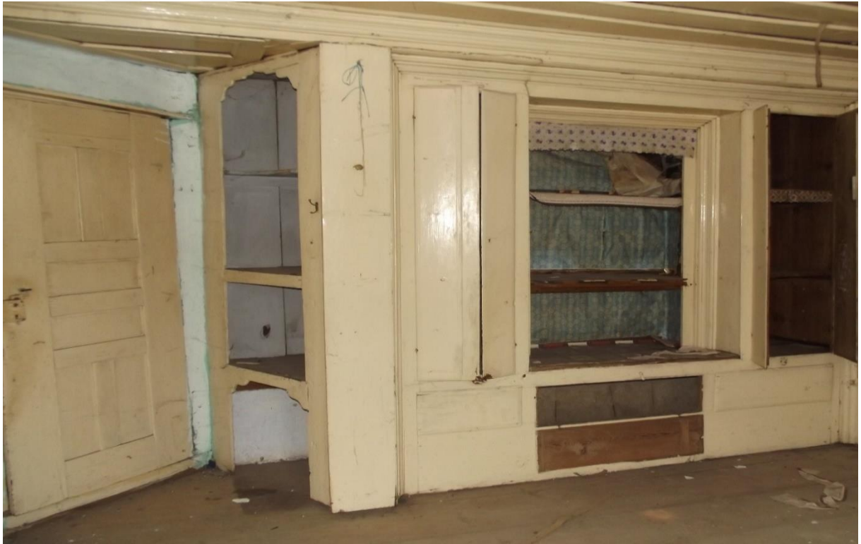
Resim 4.160. Camcı Orhan'ın evi ikinci kat kuzeydoğu oda giriş ve dolap uygulamaları
