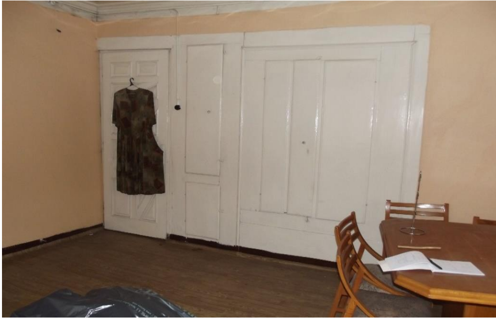
Resim 4.269. Hasan Güzelce evi ikinci kat kuzeydoğu oda giriş ve dolap uygulaması
