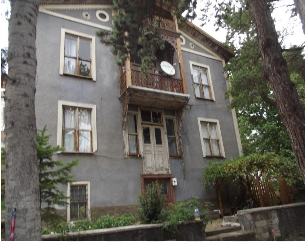
Resim 4.17. Olgaçlar Konağı güney cephe görünüşü
