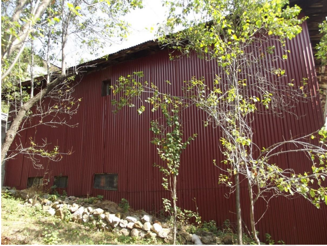
Resim 4.99.Kuşlar'ın Hafız'ın evi batı cephe görünüşü
