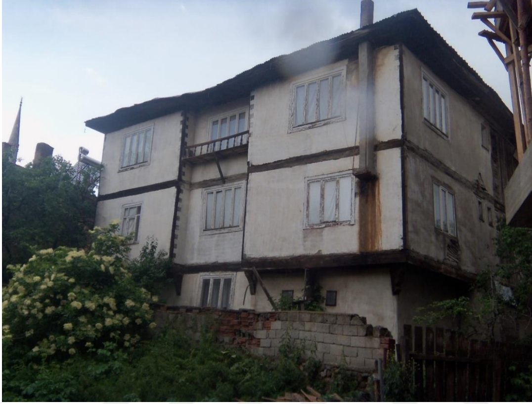
Resim 4.258. Hasan Güzelce evi kuzeydoğudan görünüşü
