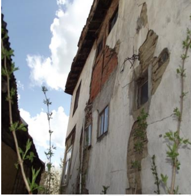
Resim 4.312. Durmuş Hoca'nın evi doğu cephe görünüşü
