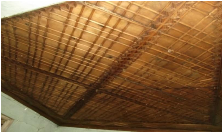
Resim 4.281. Eski Hükümet Konağı birinci kat güneybatı oda tavanı
