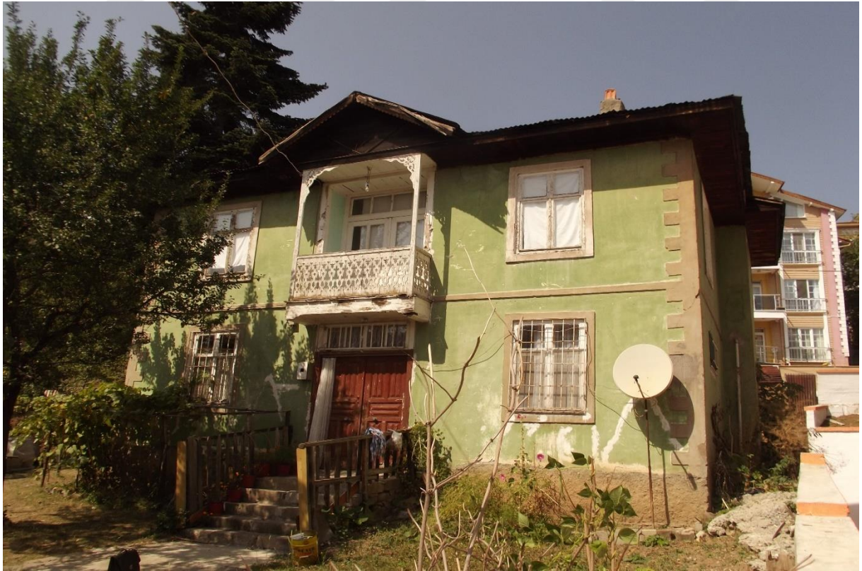
Resim 4.90. Terzi Kenan Dede'nin evi güneydoğudan görünüşü
