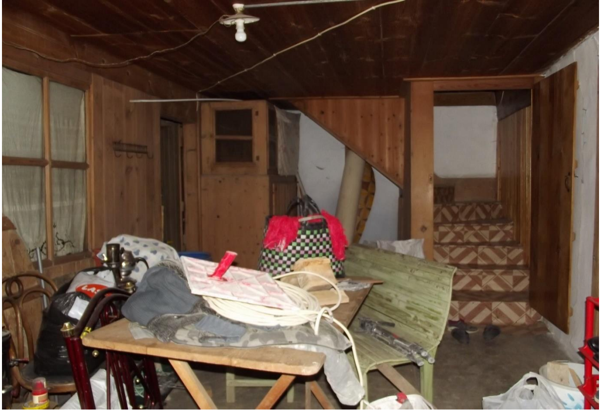
Resim 4.24. Olgaçlar Konağı zemin kat iç sofa
