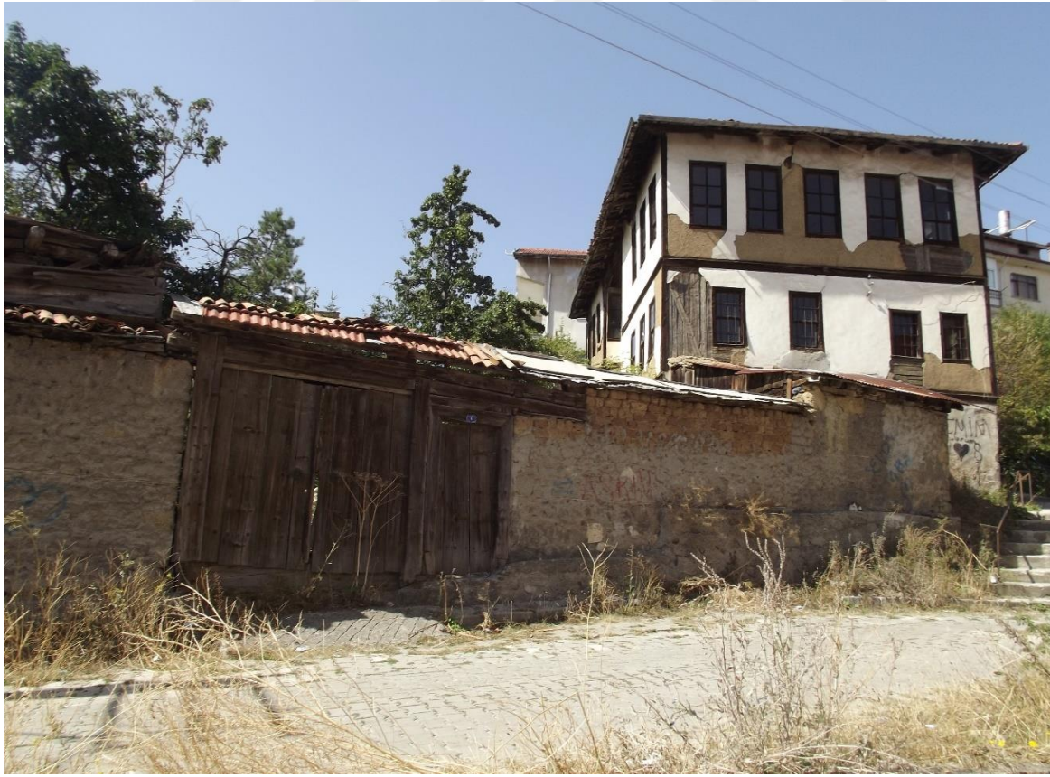
Resim 4.189. Darendeler Konağı güneydoğudan görünüşü
