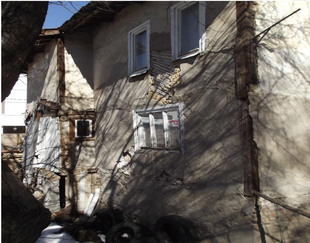
Resim 4.298. Çakırların evi batı cephe görünüşü
