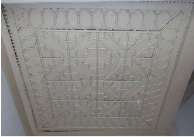
Resim 4.271. Hasan Güzelce evi merdiven sahanlığı tavan detay
