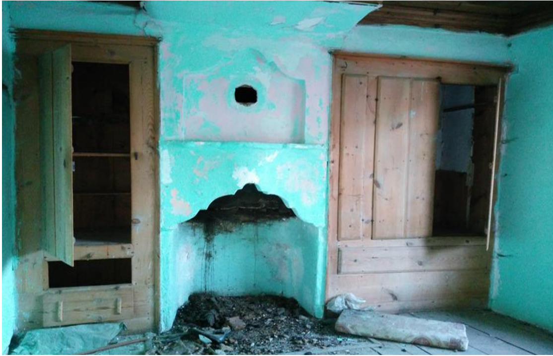
Resim 4.121. Hacı Baki'nin evi birinci kat kuzeydoğu odada bulunan ocak ve dolaplar
