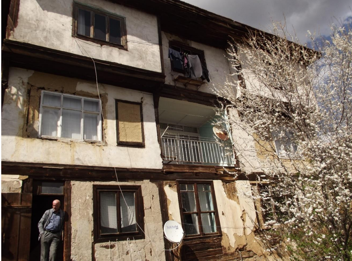
Resim 4.311. Durmuş Hoca'nın evi güney cephe görünüşü
