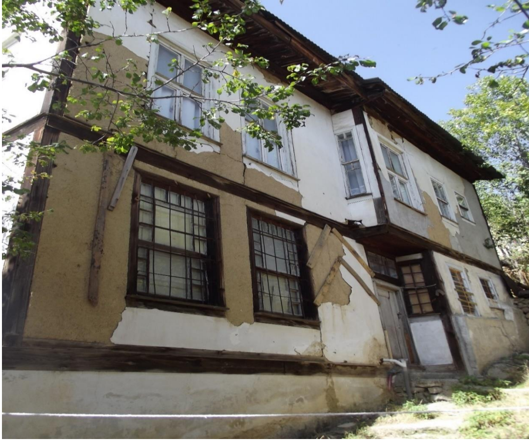
Resim 4.227. Taraşlar Konağı doğu cephe görünüşü
