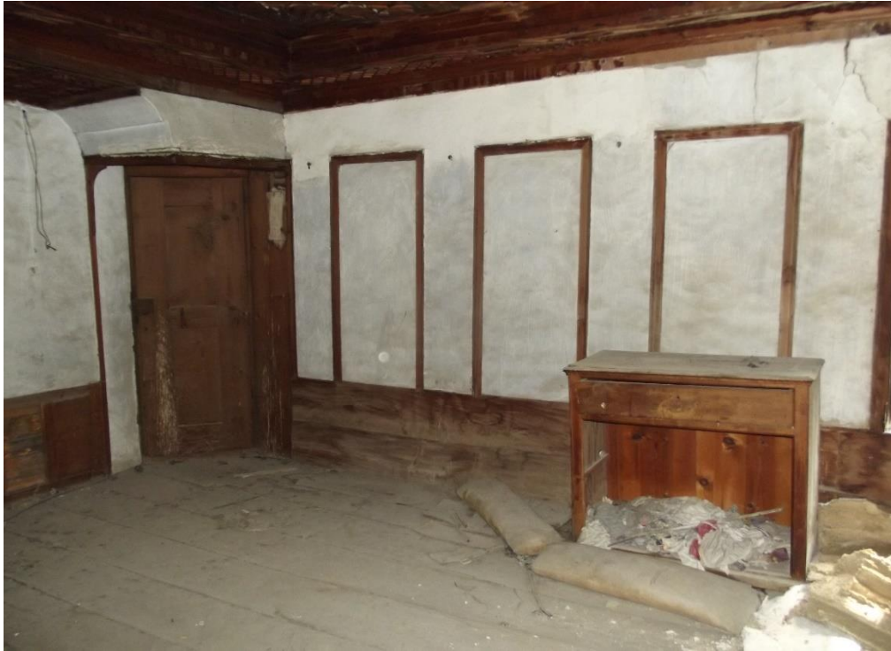
Resim 4.291. Eski Hükümet Konağı ikinci kat kuzeybatı oda giriş ve ahşap çerçeve düzenlemesi
