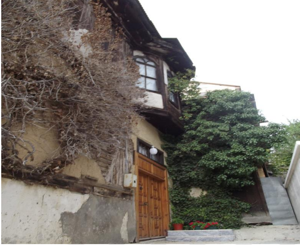
Resim 4.44. Saraç Emin evi dođu cephe görünüşü
