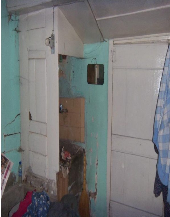
Resim 4.261. a) Hasan Güzelce evi zemin kat odada bulunan abdestlik
