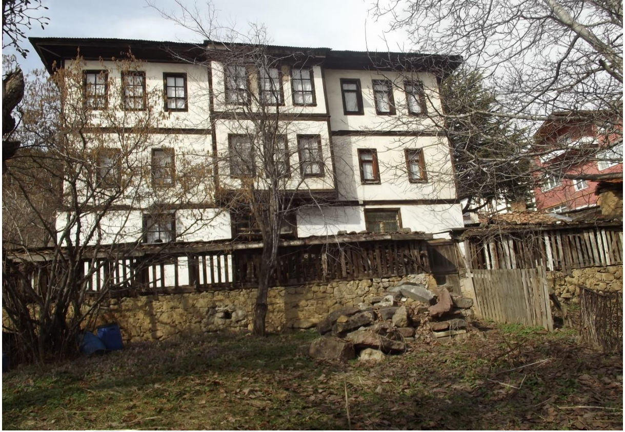
Resim 4.215. Çarıkçılar Konağı güney cephe görünüşü
