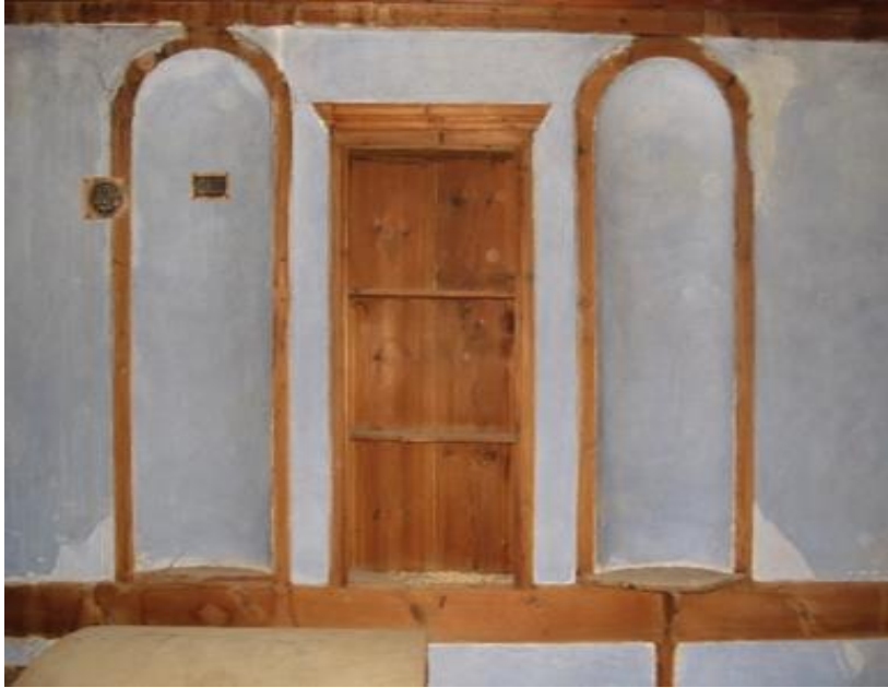
Resim 4.289. Eski Hükümet Konağı ikinci kat güneybatı oda çiçeklik ve dolap düzenlemesi
