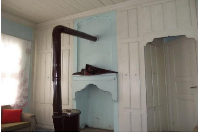
Resim 4.243. Taraşlar Konağı ikinci kat sofanın güneybatısındaki oda girişi, ocak ve dolap uygulaması
