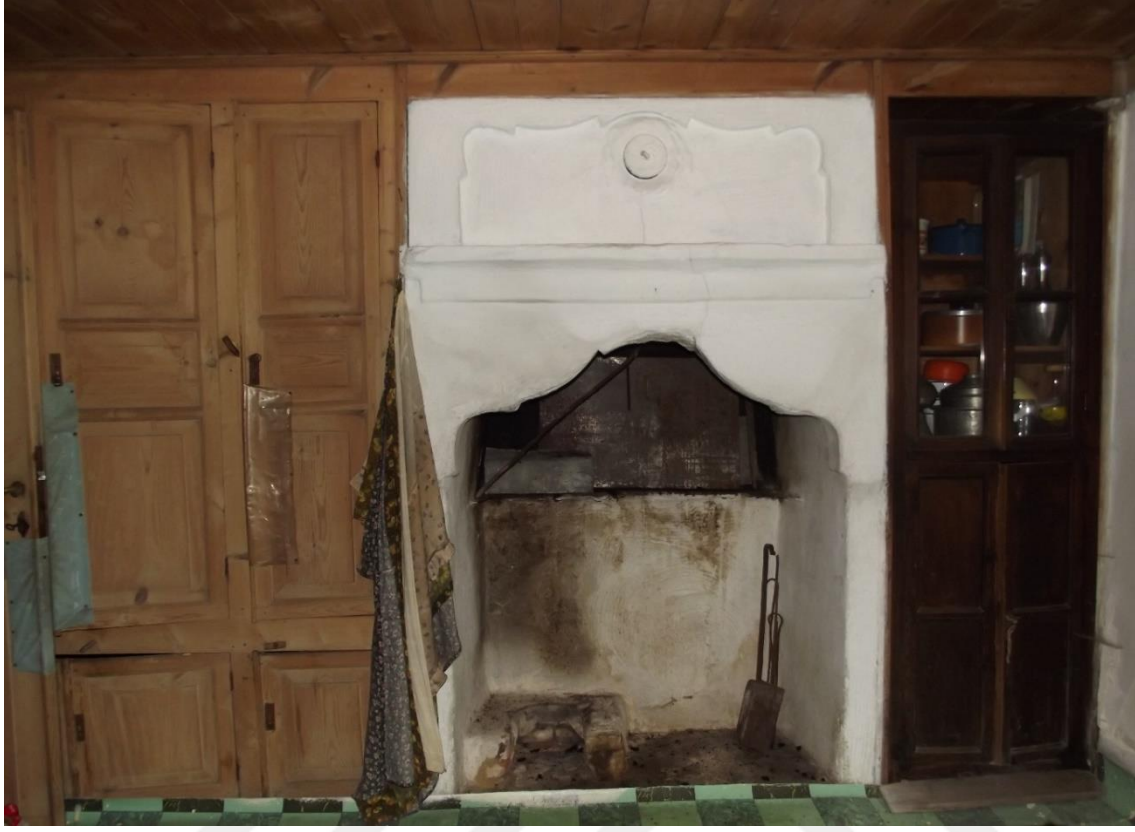
Resim 4.25. Olgaçlar Konağı zemin kat kuzey tarafta bulunan odada bulunan ocak ve dolaplar
