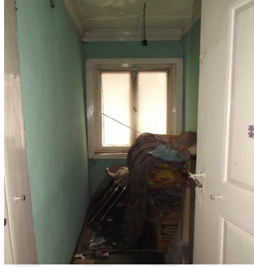
b) Depo bölümü
