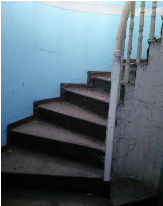
Resim 4.172. Kuzuların evi birinci kat çıkış merdiveni
