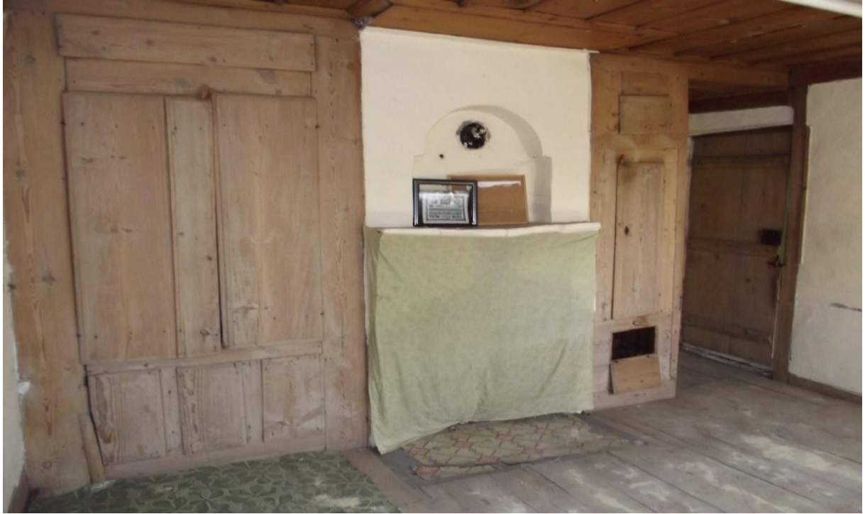
Resim 4.202. Darendeler Konađı birinci kat batı oda giriş, ocak ve dolap uygulaması
