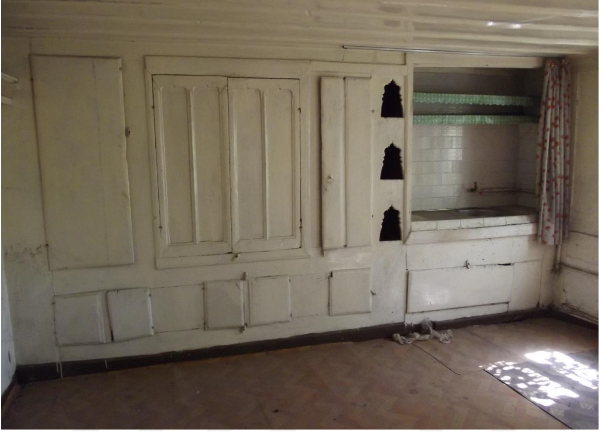
Resim 4.195. Darendeler Konağı zemin kat odada bulunan dolap uygulaması
