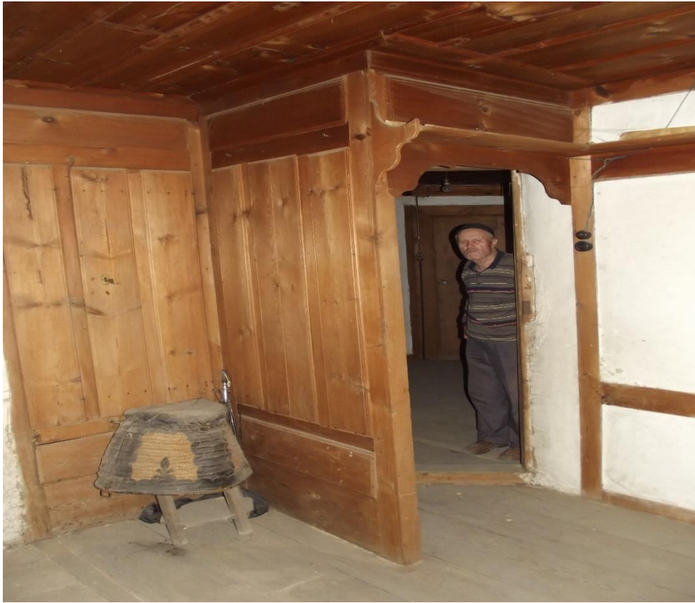
Resim 4.63. Hacı Mehmet Ali Konağı birinci kat oda giriş bölümü
