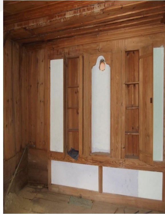
b) Ahşap çiçeklik ve dolap uygulaması
