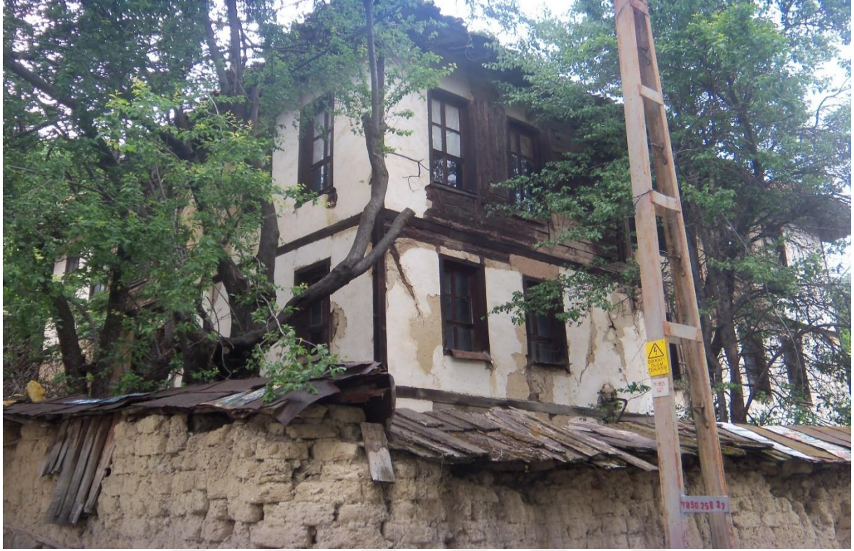
Resim 4.133. Camcı Orhan'ın evi güneydoğudan görünüşü
