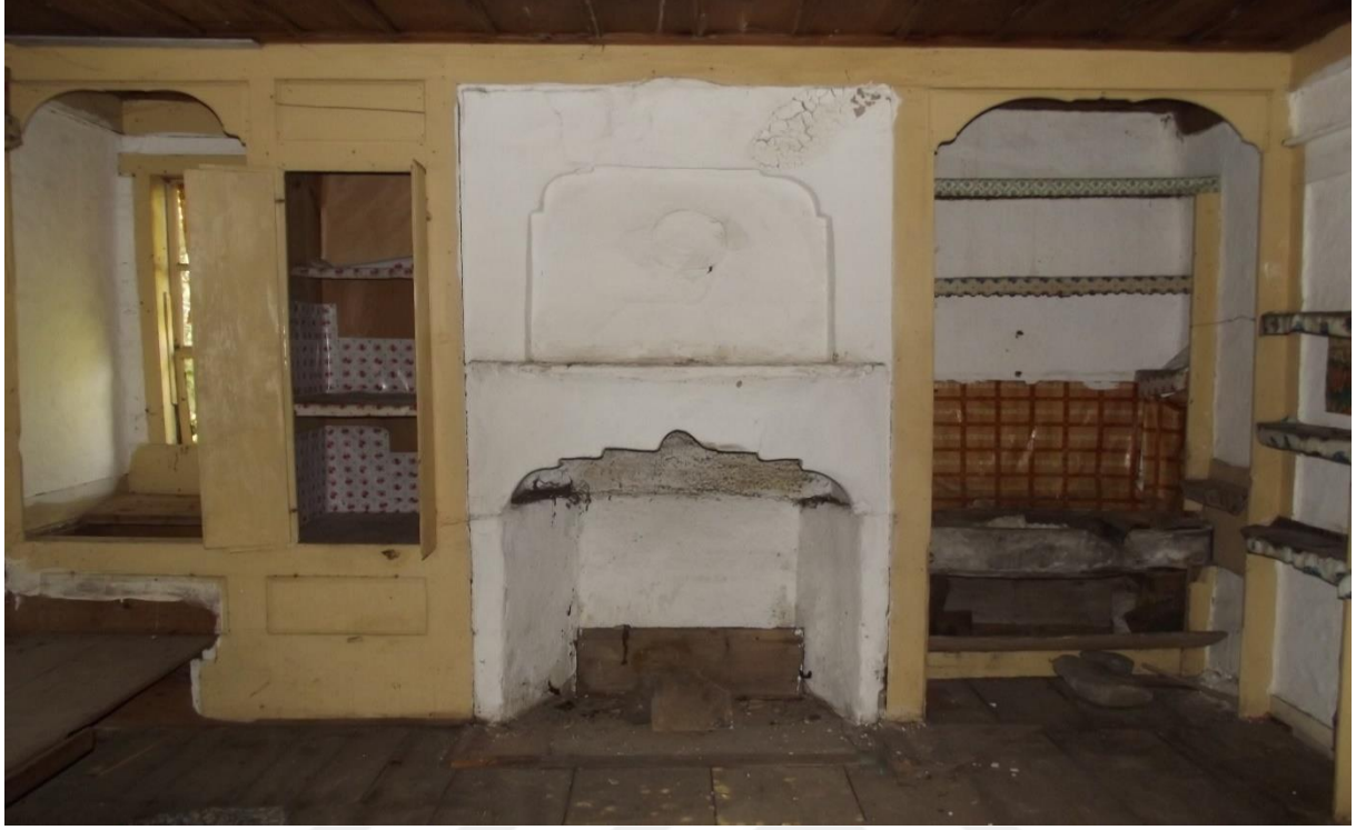
Resim 4.163. Camcı Orhan'ın evi ikinci kat kuzeybatı odada bulunan ocak ve dolap uygulamaları
