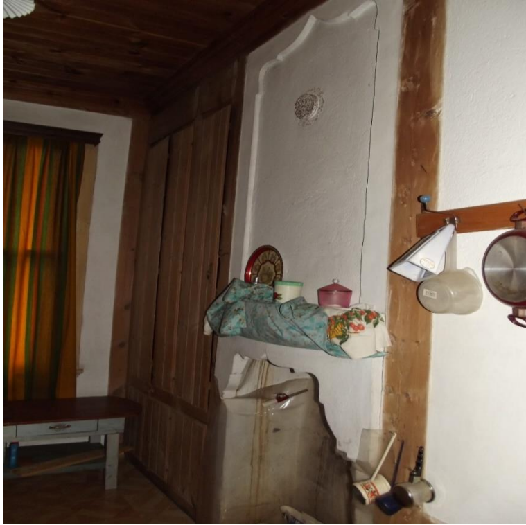
Resim 4.28. Olgaçlar Konağı birinci kat kuzeydoğuda bulunan odada bulunan taş kemerli ocak ve ahşap dolap
