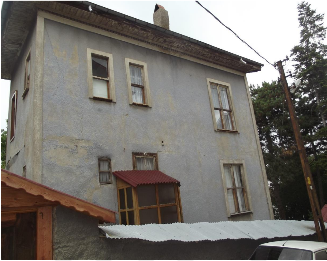
Resim 4.21. Olgaçlar Konağı batı cephe görünüşü
