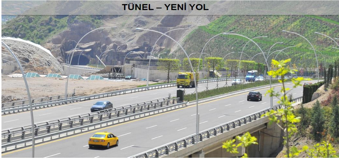
Resim 3.16. Tünel ve Yol Çalışmaları 2013 Yılında Hizmete Girmiştir Kaynak: ABBEİDB
