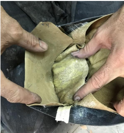
Resim 4.70. Fort astarının yapıştırılması
