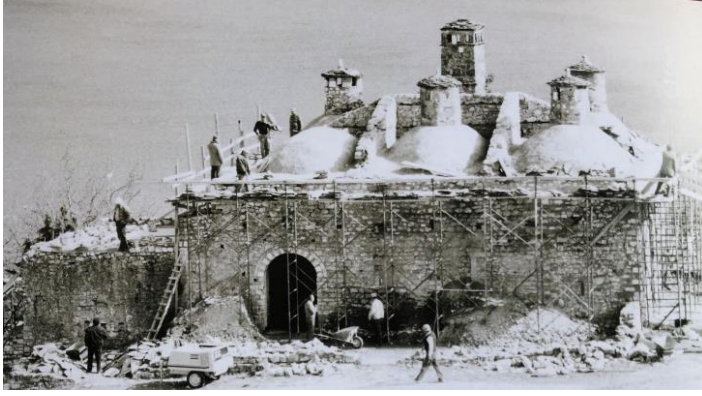
Foto 3.148. Restorasyon çalışmaları 1990 yılı
