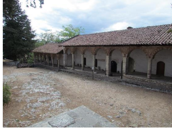
Foto 3. 62. Kuzey cephesi ikinci kısım
