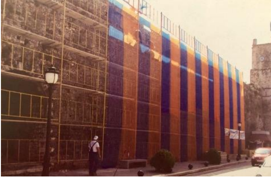
Foto 3.2. Kuzeydođu Akropol sur duvarı restorasyonu 2006 (Παπαδοπούλου,2012a:243)
