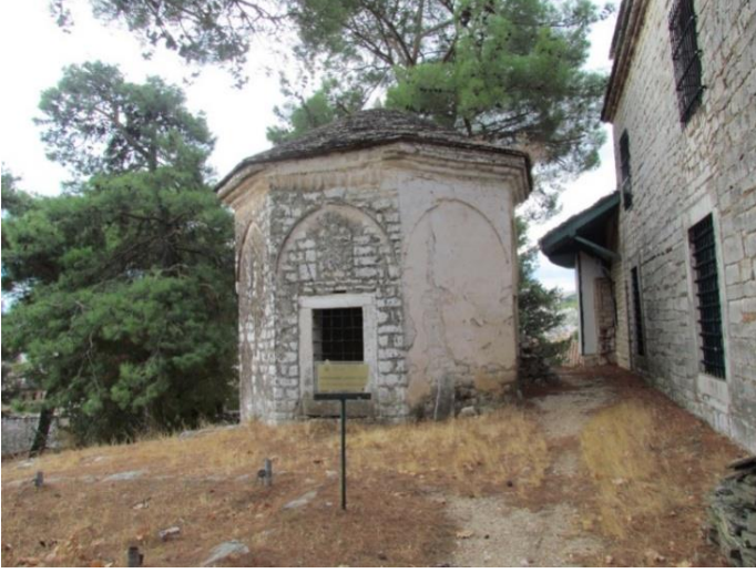
Foto 3.49. Arslan Paşa Türbesi genel görünüş
