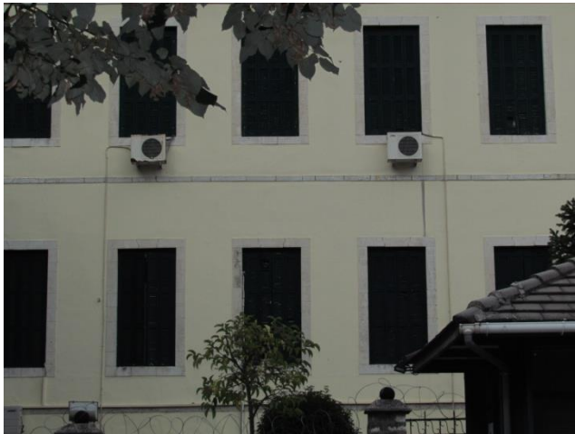
Foto 3.246. Batı cephesi- birinci ve ikinci kat pencereleri
