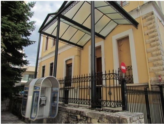
Foto 3.185. Güney cephesi- birinci kat
