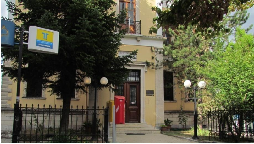
Foto 3.177. Restorasyon sonrası- kuzey cephesi
