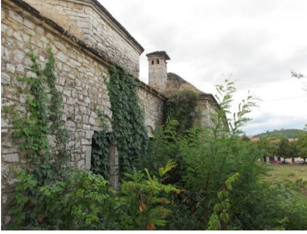
Foto 3.114. Batı cephesi - Ana okuma salonu (kitaplık) pencereleri
