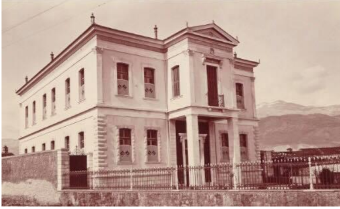
Foto 3.176.Restorasyon öncesi - kuzey cephesi -1912 yılı (BOA. No:404, Y.EE.d.)
