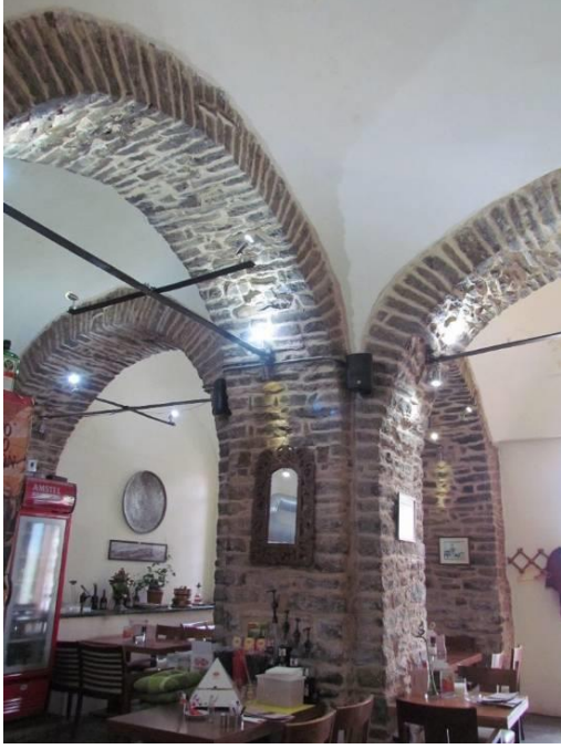
Foto 3.154. İmareti bölümlere ayıran yarım daire kemerler
