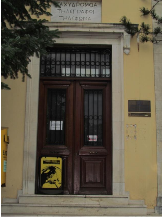
Foto 3.190. Kuzey cephesi- giriş
