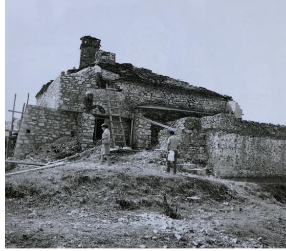
Foto 3.146. Restorasyon çalışmaları 1965 yılı
