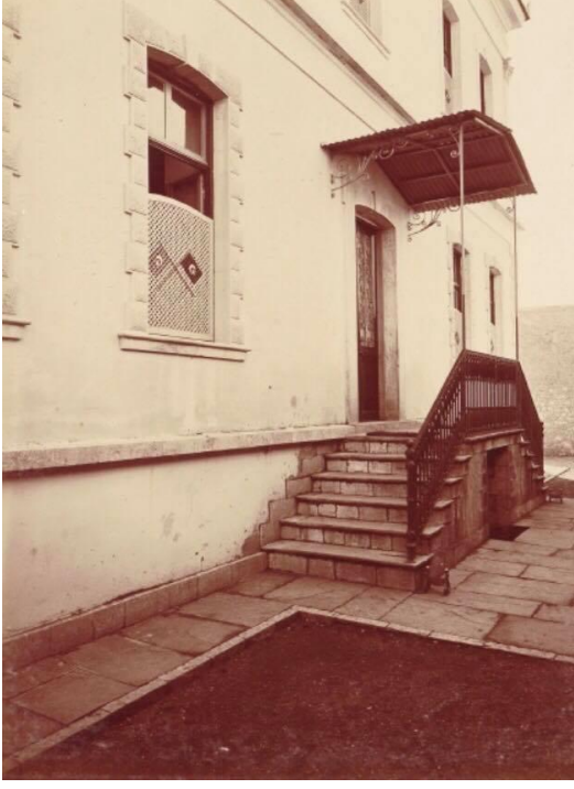
Foto 3.178. Restorasyon öncesi- güney cephesi (BOA. No:404, Y.EE.d.)
