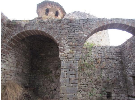
Foto 3.75. İmaret mutfak alanı
