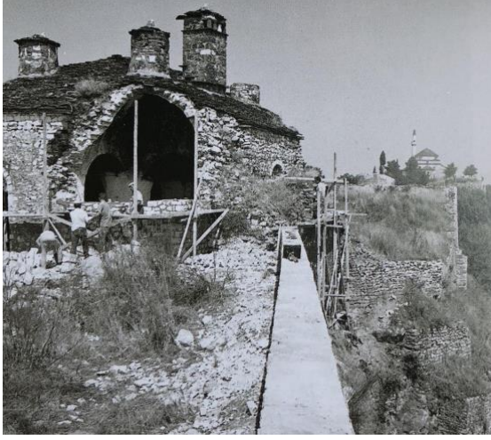
Foto 3.147. Restorasyon çalışmaları 1967 yılı
