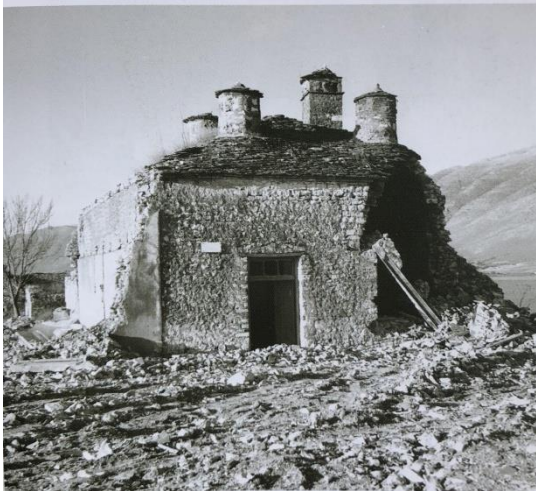
Foto 3. 145. Restorasyon çalışmaları 1965 yılı
