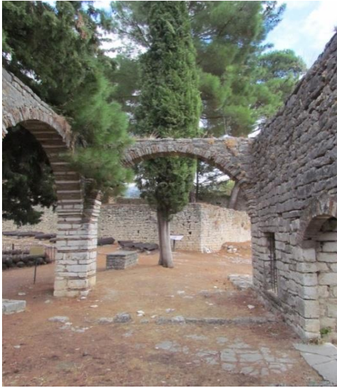
Foto 3.70. Kuzey cephesi-Revaklı kısım
