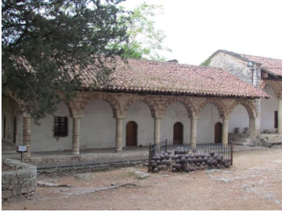
Foto 3. 61. Kuzey cephesi ilk kısım
