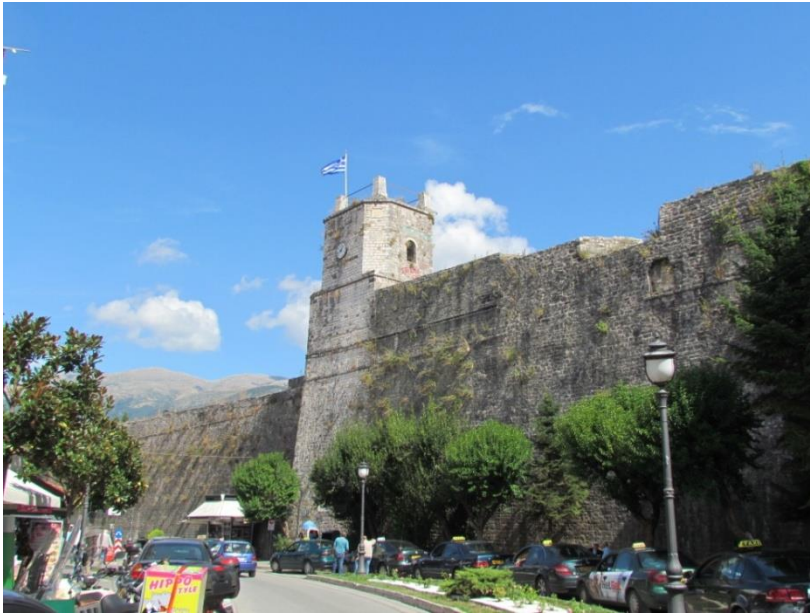
Foto 3.9. Kuzeydoğu Akropolü'nün kent merkezine bakan sur duvarları
