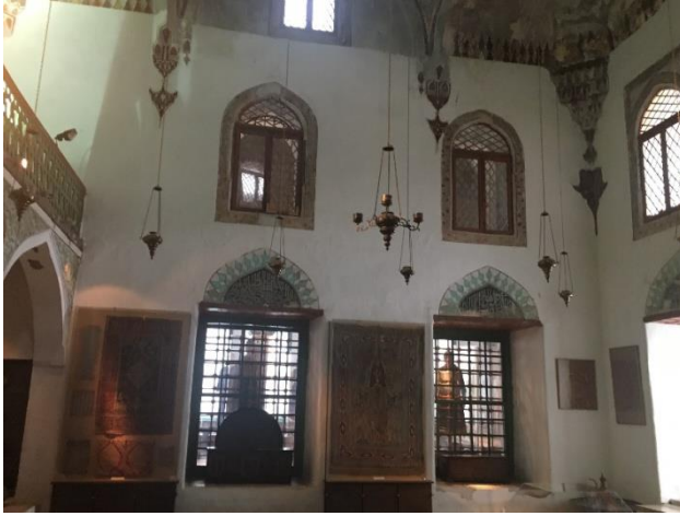
Foto 3.32. Doğu duvarı pencereleri
