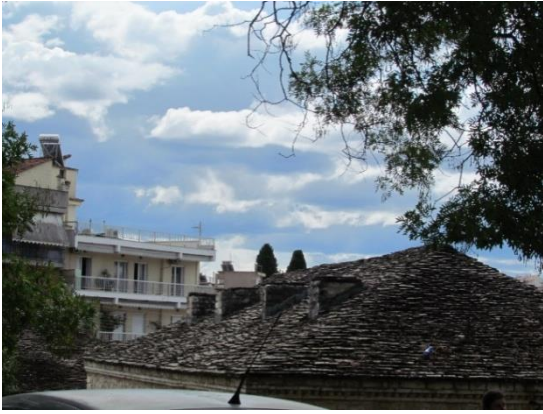
Foto 3.98. Güney cephesi- bacalar
