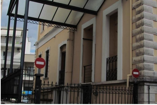
Foto 3.179. Restorasyon sonrası- güney cephesi
