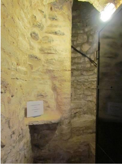
Foto 3.128. Kadınlar mahfiline ve minareye çıkış merdiveni
