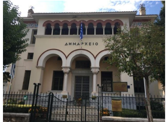
Foto 4.31. Yanya Belediye Binası
