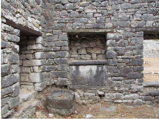
Foto 3. 74. Doğu duvarı dolap nişleri
