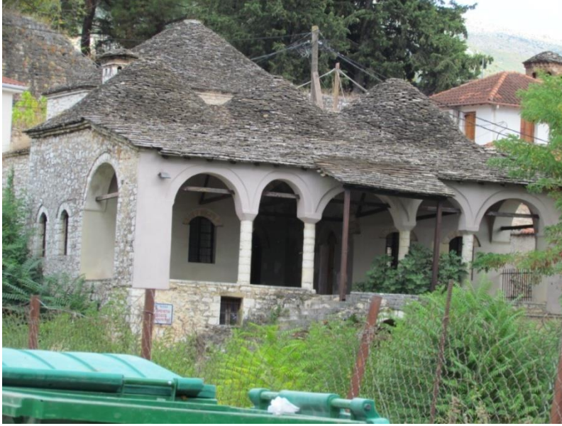
Foto 3.110. Veli Paşa Kütüphanesi
