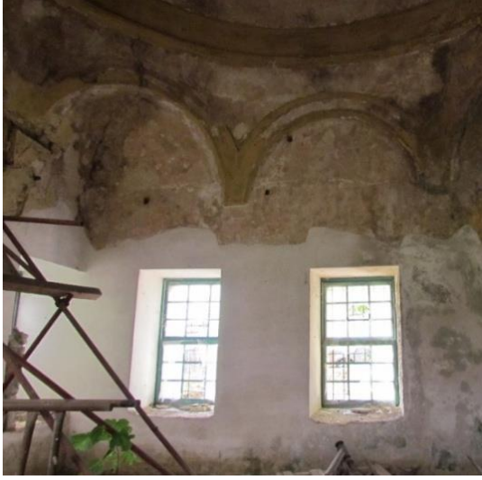
Foto 3.91. Batı duvarı pencereleri
