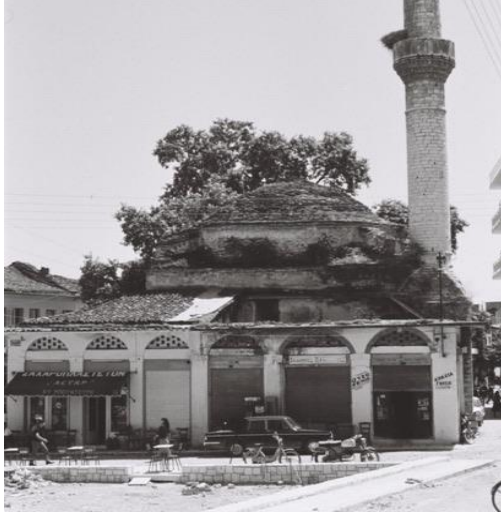
Foto 3.157. Dükkâna dönüştürülen son cemaat yeri (kuzey cephesi)1970 yılı
