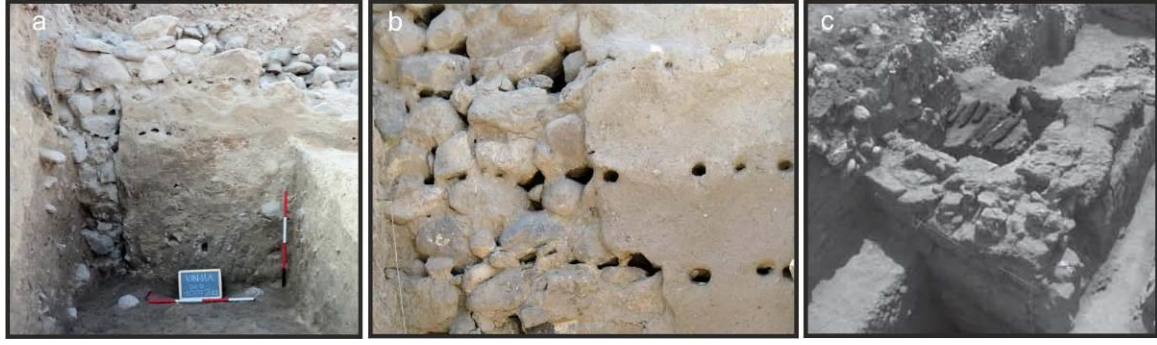
Resim 3.6. (a) Kınık Höyük duvarı ve ahşap kullanımı (Cinieri, D'Alfonso, Morandotti, 2014, 5, Fig. 2.), (b) Kınık Höyük sur duvarında ahşap hatılların negatif izleri. (Cinieri, D'Alfonso, Morandotti, 2014, 5, Fig. 2.), (c) Porsuk Höyük Giriş kapısının koruyucu kule duvarı üzerinde bulunan karbonlaşmış ahşap hatıllar. (Beyer, 2009, 392, Fig. 9).
