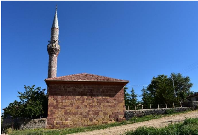
Foto. 3.25. Keskin-Cankurtaran köyü camii güney cephesinden görünüm
