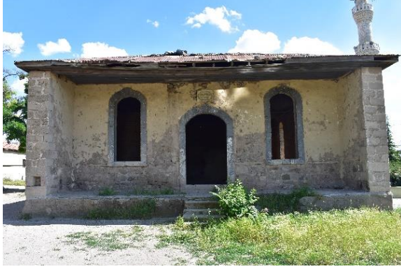
Foto. 3.182. Keskin- Köprüköyü okulu güney cephesinden görünüm
