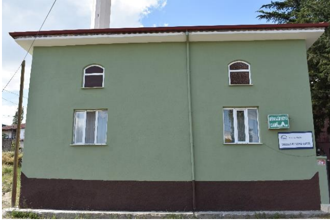
Foto. 3.120. Keskin-Müsellim köyü camii güney cephesinden görünüm
