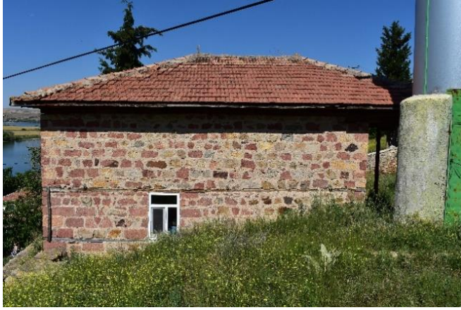
Foto. 3.80. Keskin- Esatmüminli köyü camii doğu cephesinden görünüm
