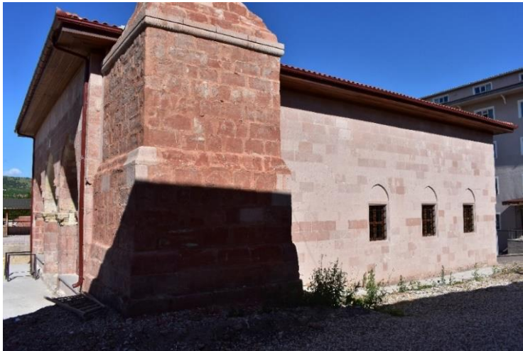
Foto. 3.10. Keskin Çarşı Camii Batı Cephesinden Görünüm
