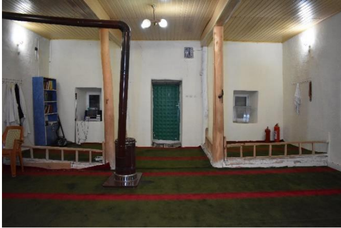
Foto. 3.74. Keskin- Cinali köyü camii iç mekân kuzey duvarı
