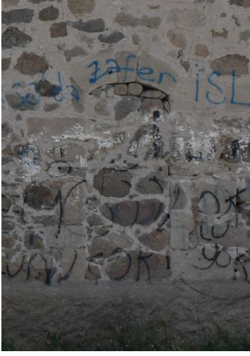
Foto. 3.189. Keskin- Köprüköyü okulu batı cephesindeki pencere detayı
