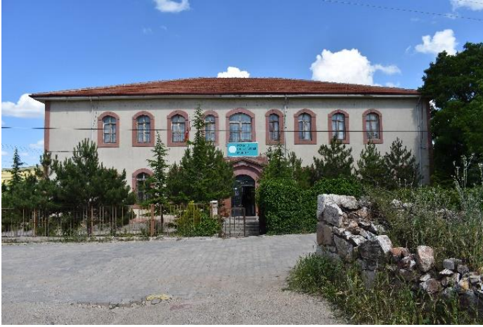
Foto. 3.210. Keskin-Kibrithane binası genel görünüm
