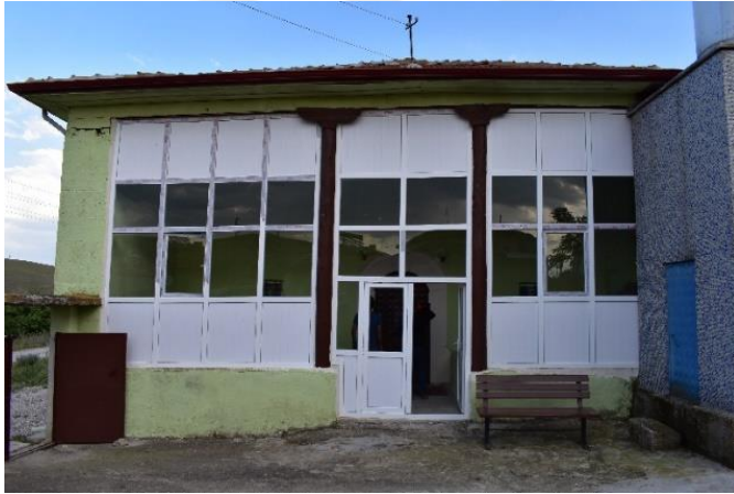
Foto. 3.106. Keskin-Kevenli köyü camii kuzey cephesinden görünüm
