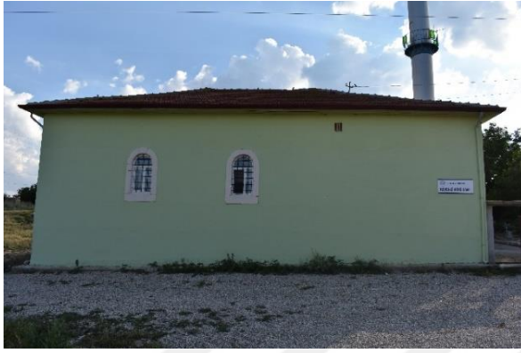
Foto. 3.108. Keskin-Kevenli köyü camii doğu cephesinden görünüm
