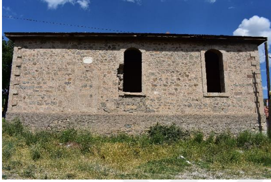
Foto. 3.186. Keskin- Köprüköyü okulu doğu cephesinden görünüm
