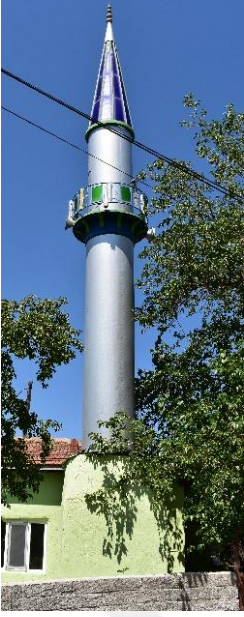
Foto. 3.135. Keskin Ortasöken köyü camii minaresi
