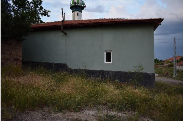
Foto. 3.69. Keskin-Cinali köyü camii batı cephesinden görünüm
