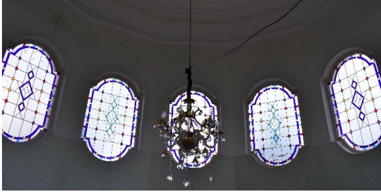
Foto. 3.149. Keskin-Haydar Sultan türbesi iç mekân pencerelerden detay
