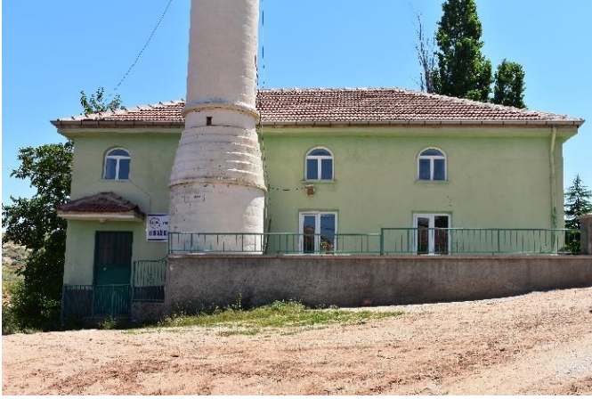
Foto. 3.93. Keskin- Eskialibudak köyü camii batı cephesinden görünüm
