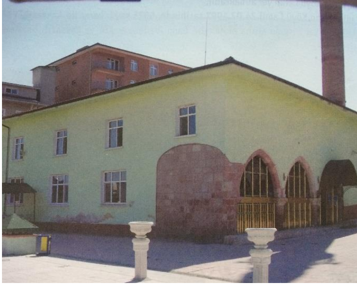
Foto. 3.3. Çarşı camii onarım öncesi kuzey cephesi (Y. Saluk’dan 2014)
