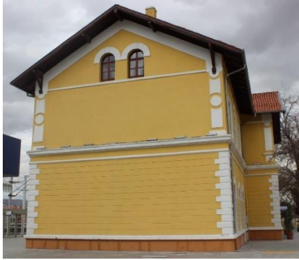
Konya Gar Binası Güney Cephesi
