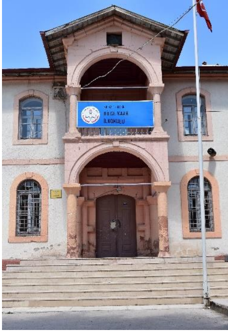
Foto. 3.198. Keskin-Fişekhane binası batı cephesi giriş kapısından görünüm
