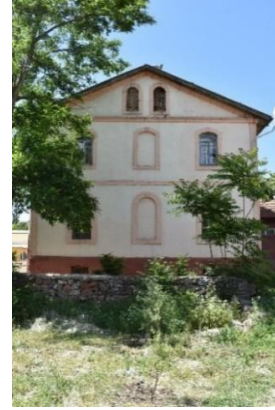
Keskin Fişekhane Binası Güney Cephesi
