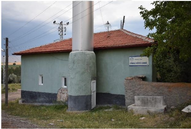
Foto. 3.68. Keskin-Cinali köyü camii doğu cephesinden görünüm
