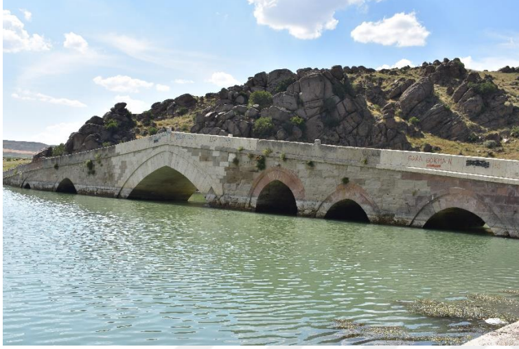
Foto. 3.177. Keskin- Köprüköyü Çeşnigir köprüsü
