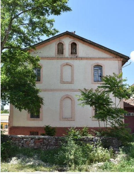
Foto. 3.202. Keskin- Fişekhane binası güney cephesinden görünüm
