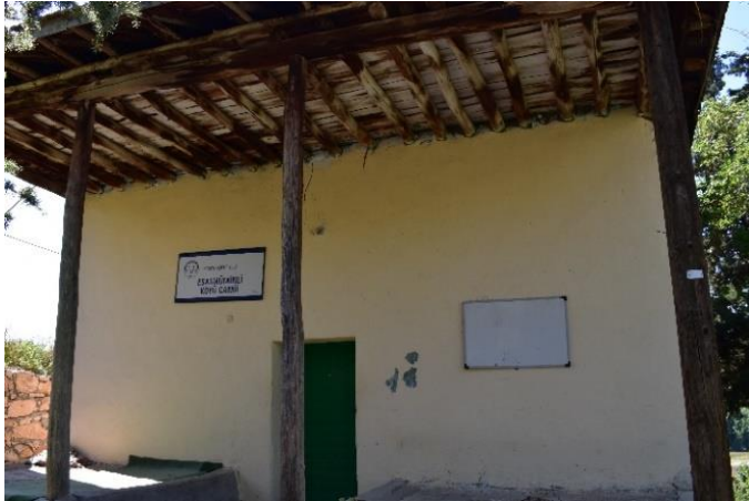
Foto. 3.78. Keskin- Esatmüminli köyü camii kuzey cephesinden görünüm
