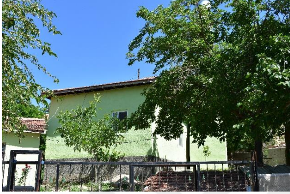
Foto. 3.133. Keskin-Ortasöken köyü camii güney cephesinden görünüm
