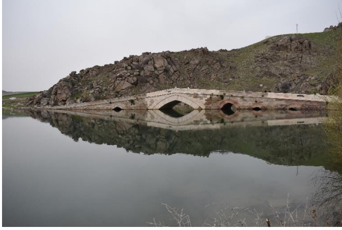
Foto. 3.175. Keskin- Köprüköyü Çeşnigir köprüsü
