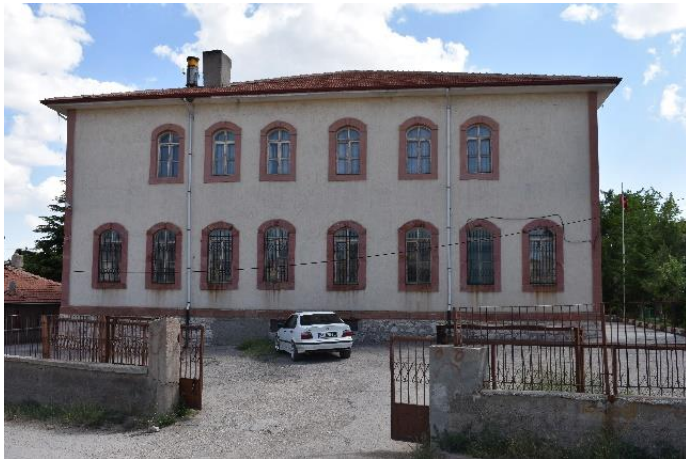
Foto. 3.216. Keskin-Kibritthane binası kuzey cephesinden görünüm
