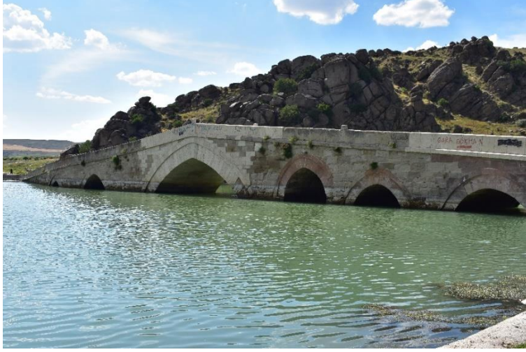
Foto. 3.181. Keskin-Köprüköyü Çeşnigir köprüsü
