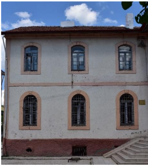
Foto. 3.197. Keskin- Fişekhane binası batı cephesi pencere düzeni
