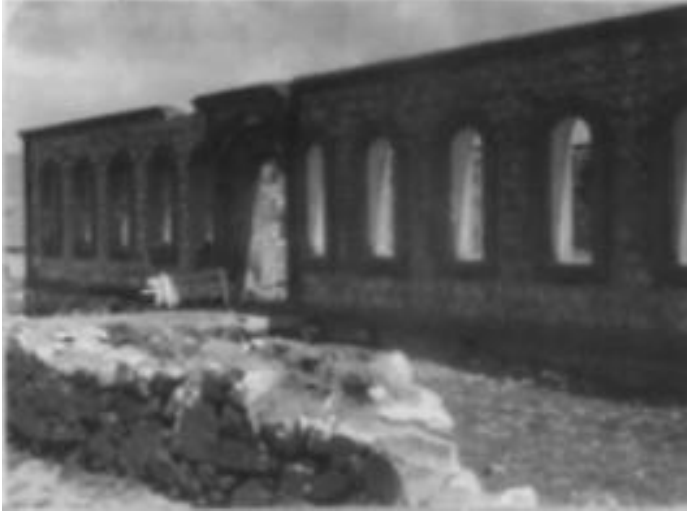
Foto. 3.209. Keskin- Kibrithane binası (AKTVKK arşivinden)
