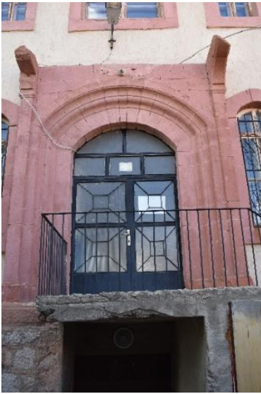
Foto. 3.215. Keskin-Kibrithane binası doğu cephesindeki kapıdan görünüm
