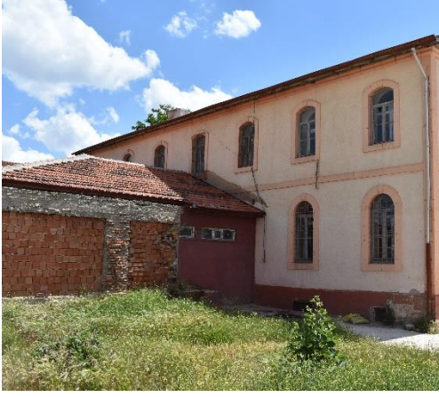
Foto. 3.200. Keskin- Fişekhane binası doğu cephesinden görünüm
