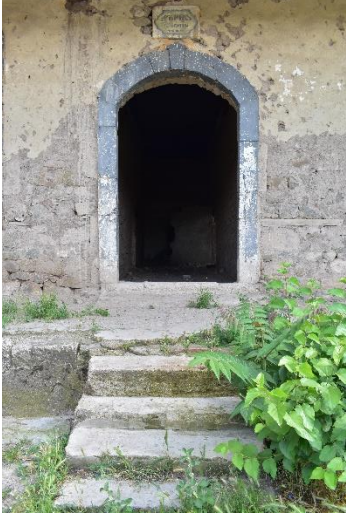
Foto. 3.183. Keskin- Köprüköyü okulu giriş kapısından detay
