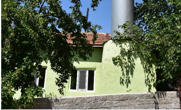
Foto. 3.134. Keskin-Ortasöken köyü camii doğu cephesinden görünüm
