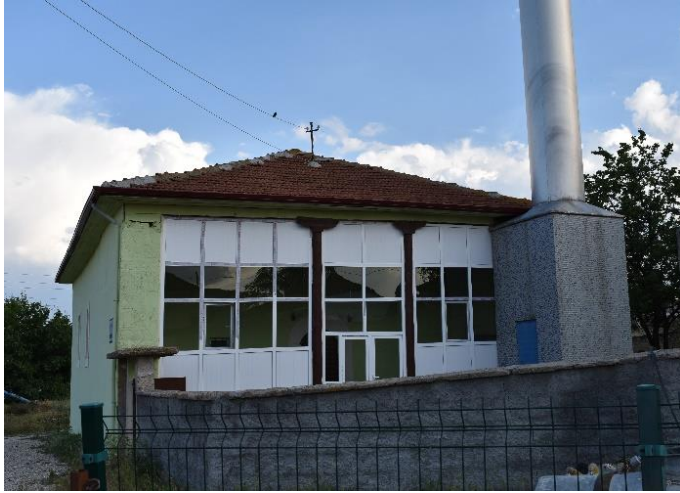
Foto. 3.105. Keskin-Kevenli köyü camii genel görünüm
