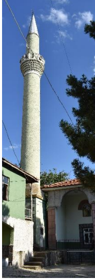
Foto. 3.54. Keskin- Ceritkale köyü camii minaresi
