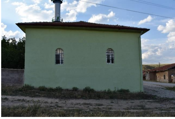
Foto. 3.107. Keskin-Kevenli köyü camii güney cephesinden görünüm
