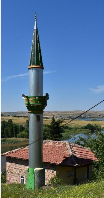
Foto. 3.82. Keskin- Esatmüminli köyü camii minaresi
