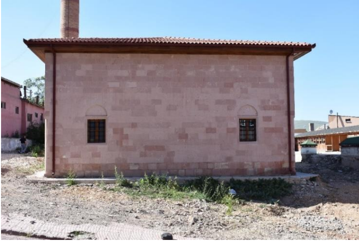
Foto. 3.8. Keskin çarşı camii güney cephesinden görünüm
