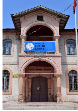
Keskin Fişekhane Binası Giriş Kapısından Detay
