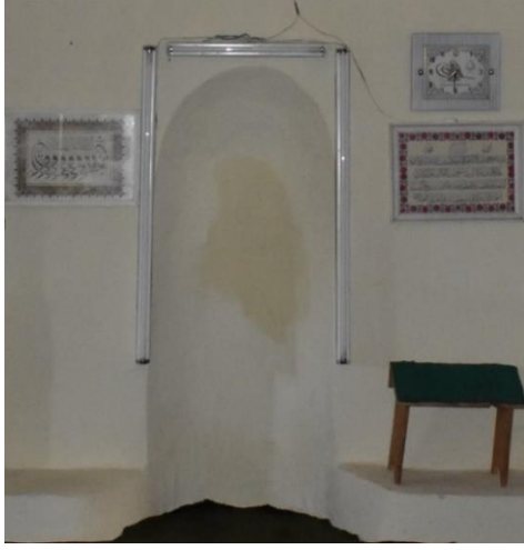
Foto. 3.75. Cinali köyü camii mihrabı
