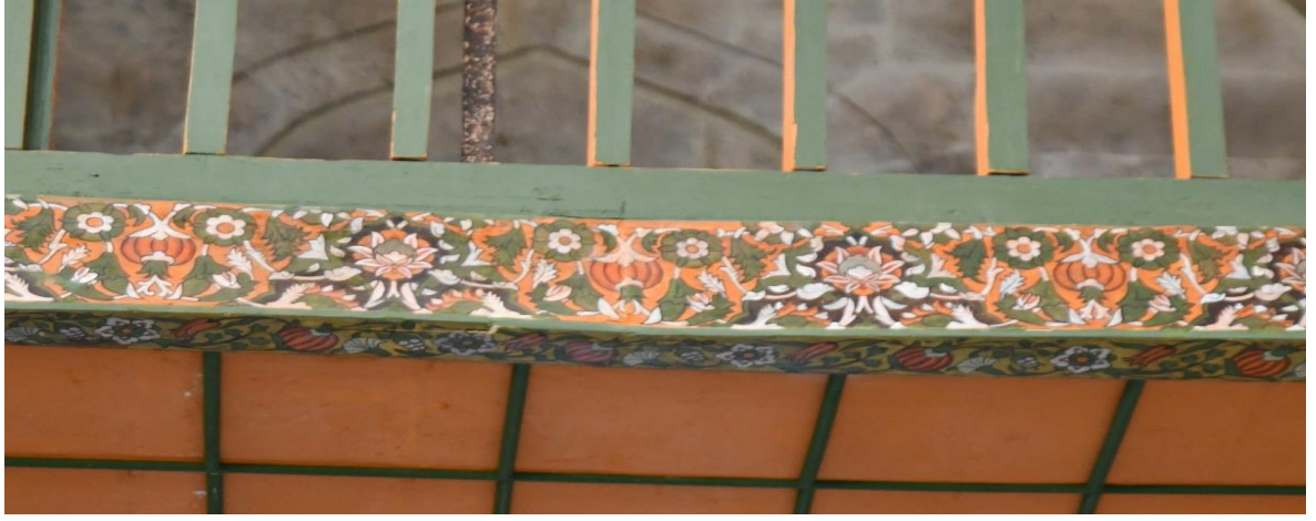
Fotoğraf 2. Ali Paşa Camii kadınlar mahfili aynalıklarındaki süslemeler restorasyon sonrası
