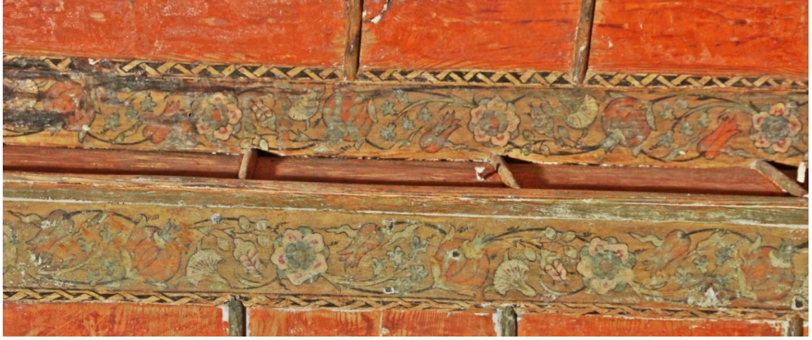
Fotoğraf 3. Ali Paşa Camii kadınlar mahfili tavan bordürleri restorasyon öncesi
