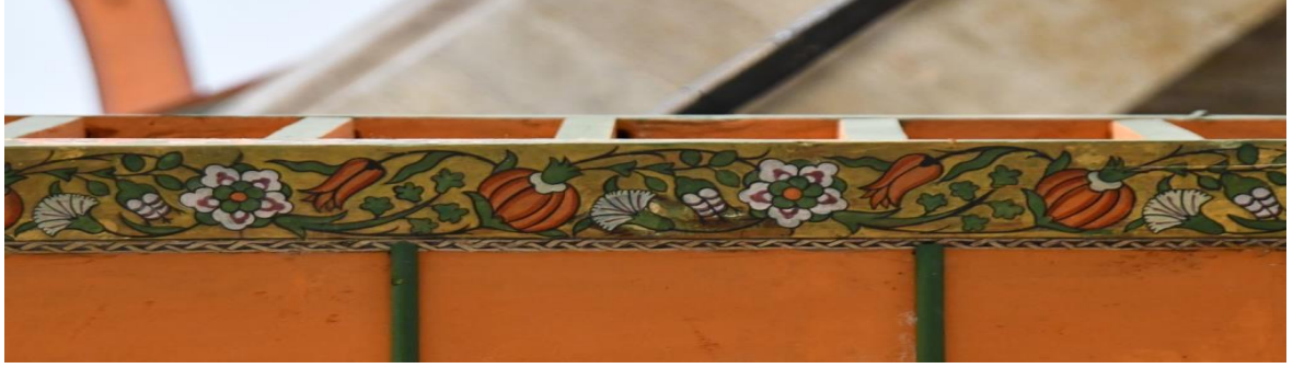
Fotoğraf 4. Ali Paşa Camii kadınlar mahfili tavan bordürleri restorasyon sonrası
