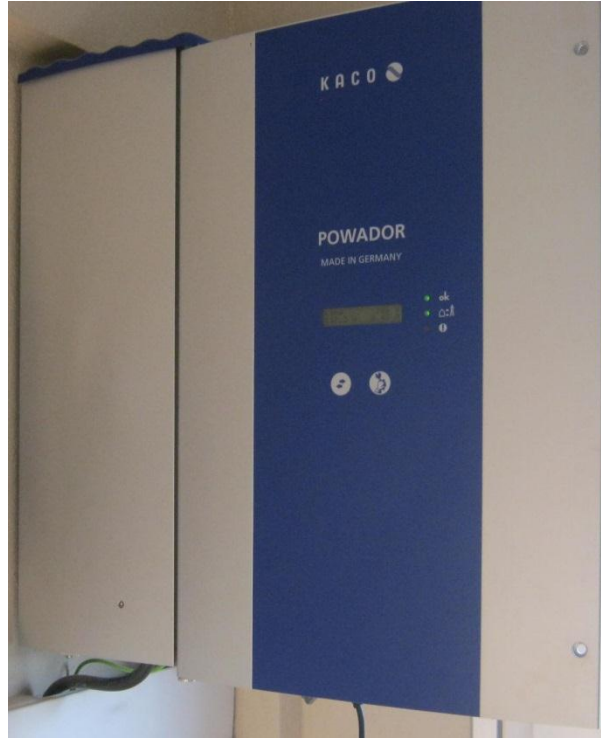
Şekil 4.12 Eviricinin görüntüsü.
