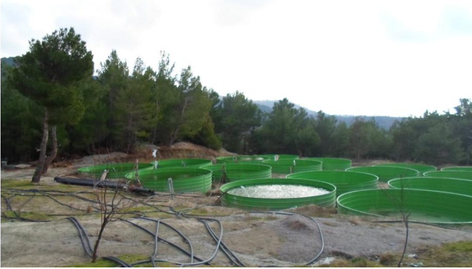
Şekil 4.3. Dairesel fiberglas tank kullanan bir tesisten görünüş
