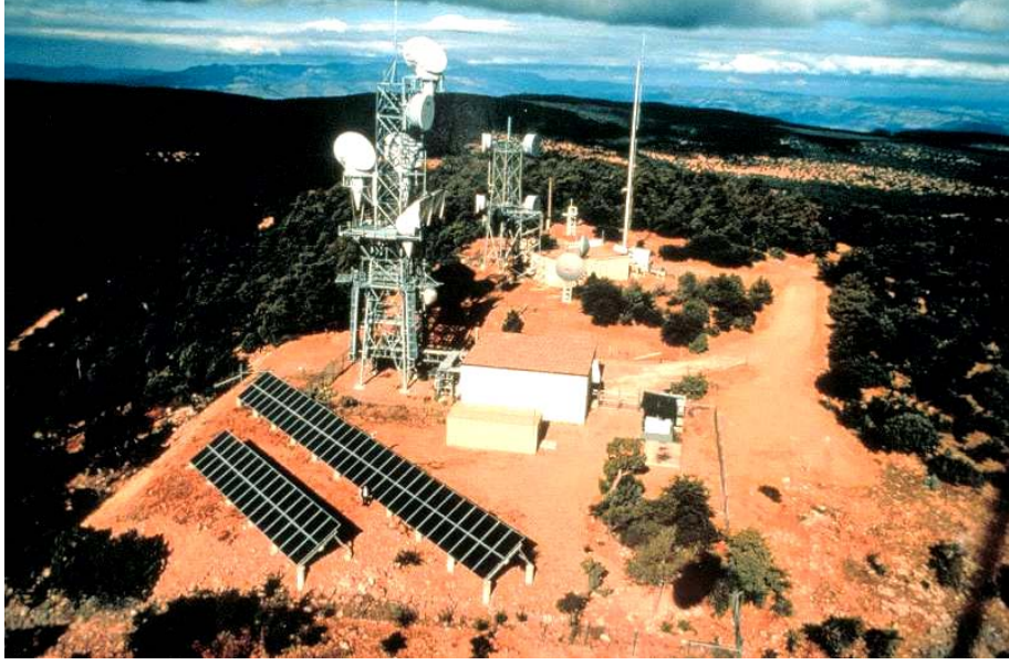
Şekil 8.7: Haberleşme İstasyonu Uygulaması
