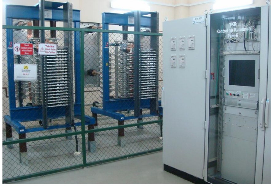
Şekil 4.14: Tristörler ve kontrol paneli
