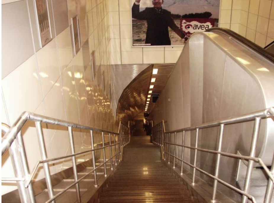
Şekil 7-11 Erişim Zorluğu Olan Merdiven Aydınlatmalarına Bir Örnek
