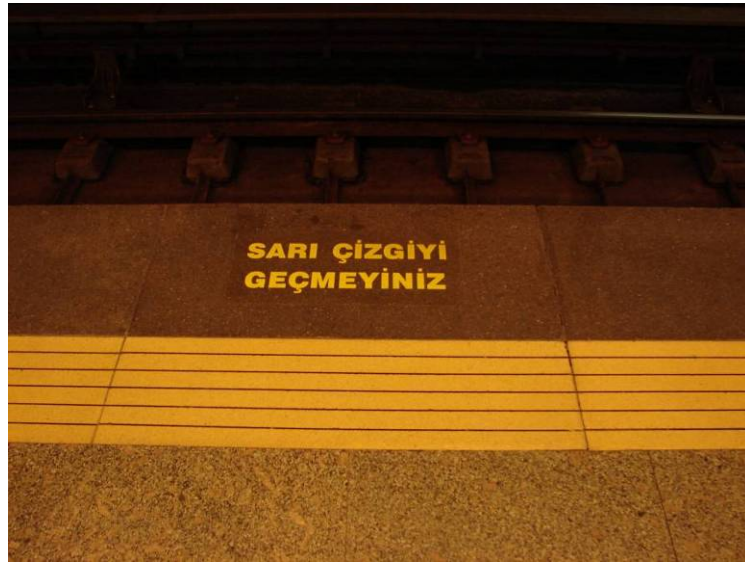
Şekil 6-8 : Levent istasyonu Platform Emniyet Bandı ve Kenarı
