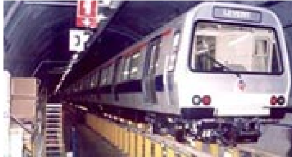
Şekil 5-5 : İstanbul Metrosu, Ön Bakım Alanına Ait Görünümler
