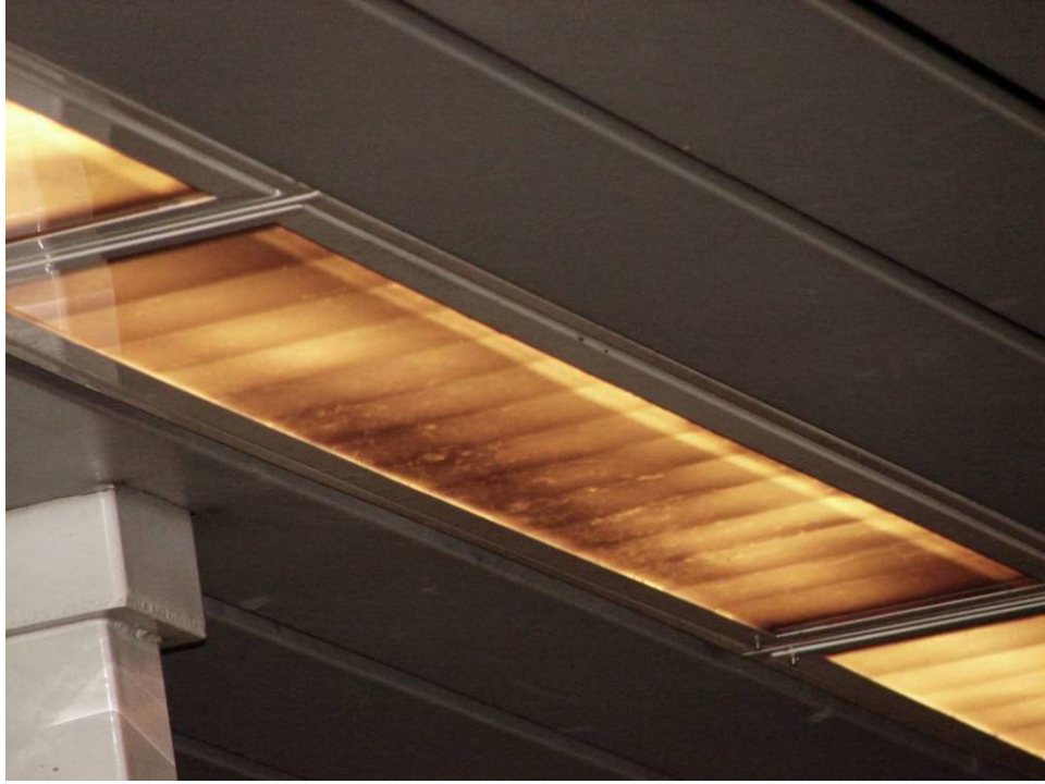
Şekil 7-7 : Şişli İstasyonu Emniyet Çizgisi Üzerindeki Kirli Bir Armatür
