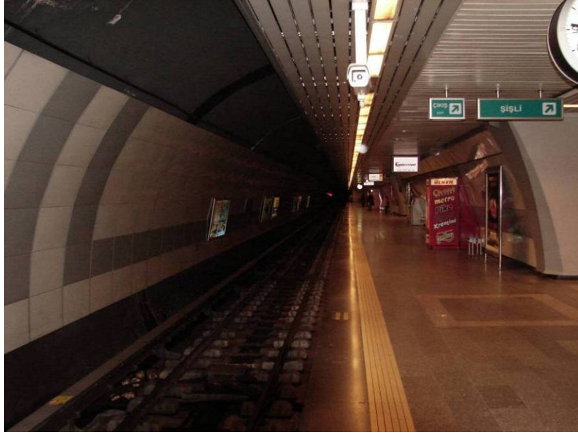
Şekil 7-17 : Şişli İstasyonu Emniyet Çizgisi Üzerindeki Kirli Armatürler
