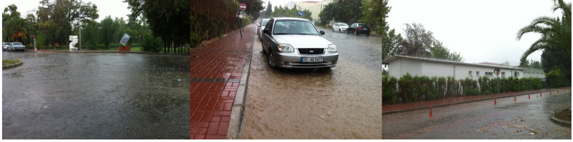
Şekil 3.10 Yerleşke yüzeyel drenaj sistemi yetersizliği.
