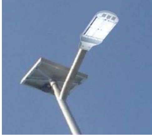
Şekil 5.6 : LED’li fotovoltaik yol aydınlatma örneği [23]
