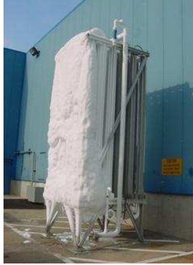
řekil 2.5 : Üzerinde buzlanma meydana gelmiř kriyojenik ısı deęiřtirici[24].
