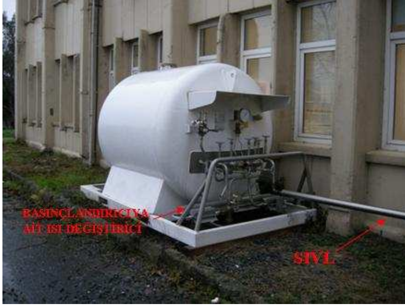
Şekil 2.3 : KGYS’de kullanılan kriyojenik tank.
