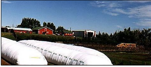
Şekil 1.10 Sosis tipi silo yapımı (Besi Yemi, 2013).
