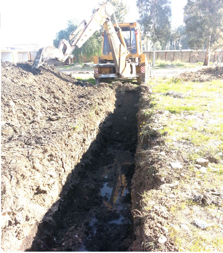
Şekil 4.5 Deney Sahasında Yapılan Kazı İşlemi
