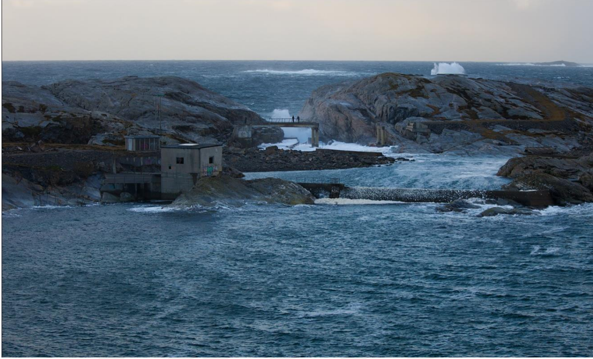
Şekil 2.20. Konik kanal tipi dalga enerji dönüştürücüsü [64].
