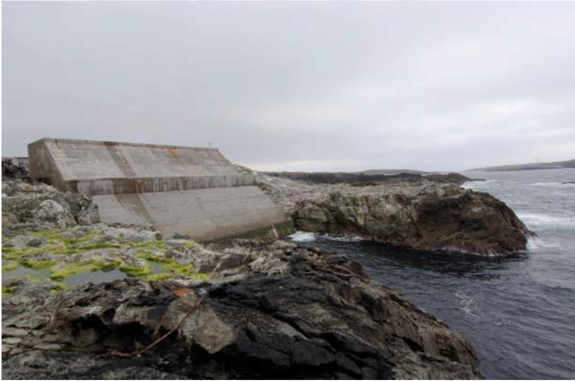
Şekil 2.18. Salımlı su kolonu (OWC) [64].
