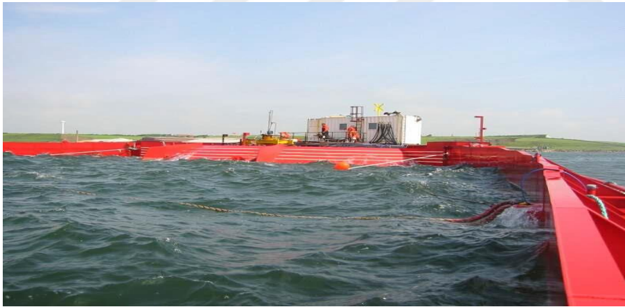
Şekil 2.25. The Wave Dragon dalga enerji dönüştürücüsü [66].
