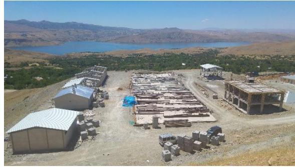
Şekil 3.6 Tunceli Pertek ilçe merkezdeki açık hayvan pazarı inşaatı
