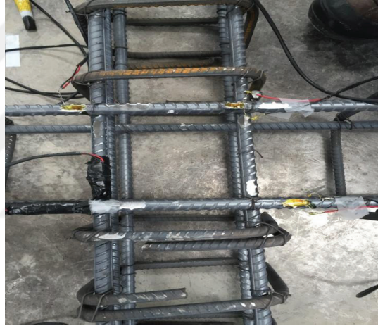
Şekil 3.12 Gerinim ölçerlerin (strain gauge) donatılara yapıştırılması
