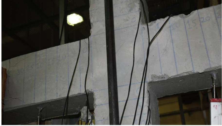
Şekil 5.23 Akma anında deney elemanında meydana gelen hasar (F4)
