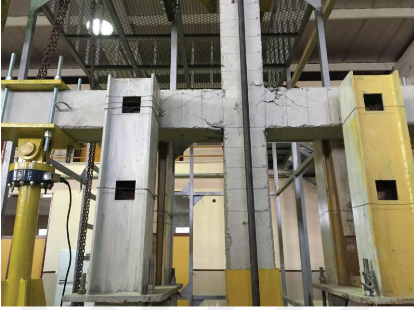
Şekil 5.30 Deney sonunda birleşim elemanında meydana gelen hasar (F5)
