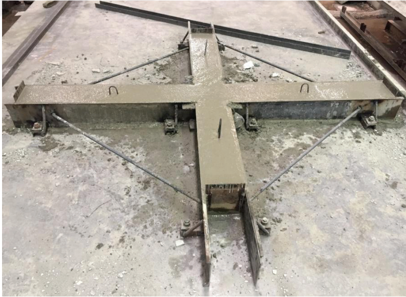
Şekil 3.24 Birleşim elemanı betonunun dökülmesi (F5)
