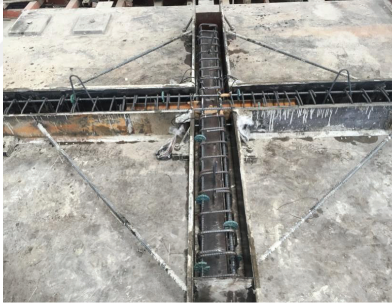
Şekil 3.21 Hazırlanan donatıların kalıba yerleştirilmesi (F4)
