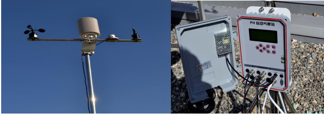
Şekil 3.15. Kurulu sisteme dahil olan meteoroloji istasyonuna ait bir görüntü.
