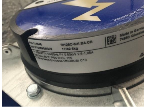
Şekil 5.9. Karşıt Akışlı IGK Cihazı EC fan
