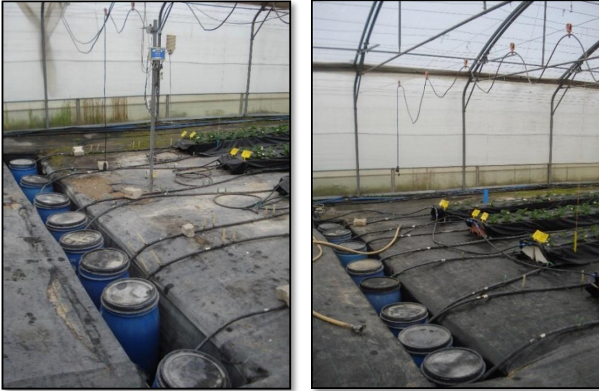
Şekil 3.9. Drenaj tanklarının genel görünümü.
