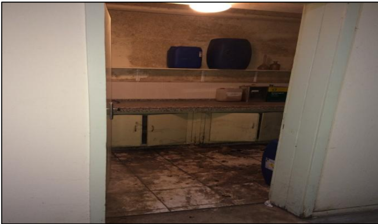
Şekil 2.22. EÜ kimya bölümü D blok eski depo
