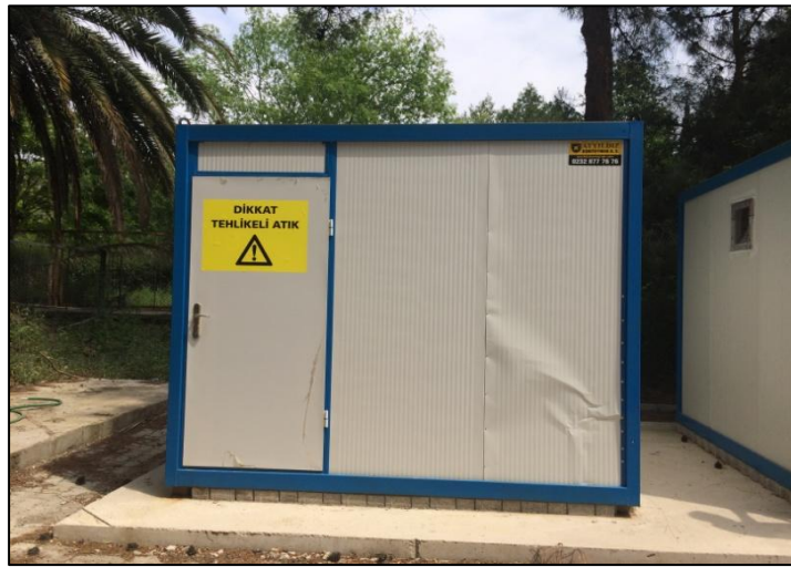
Şekil 2.24. EÜ kimya bölümü yeni atık deposu
