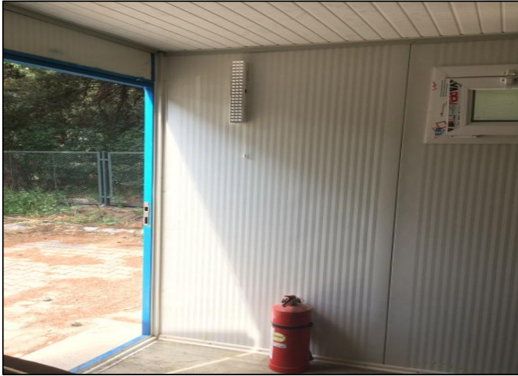
Şekil 2.26. EÜ kimya bölümü yeni atık depo içi
