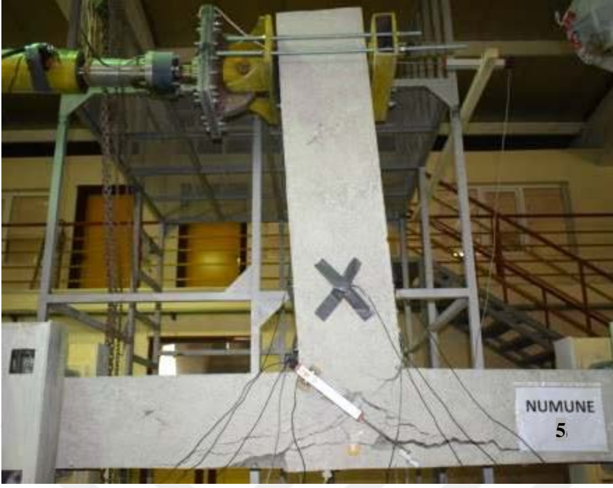
Şekil 4.74.Deney Elemanı-5 genel hasar görünümü
