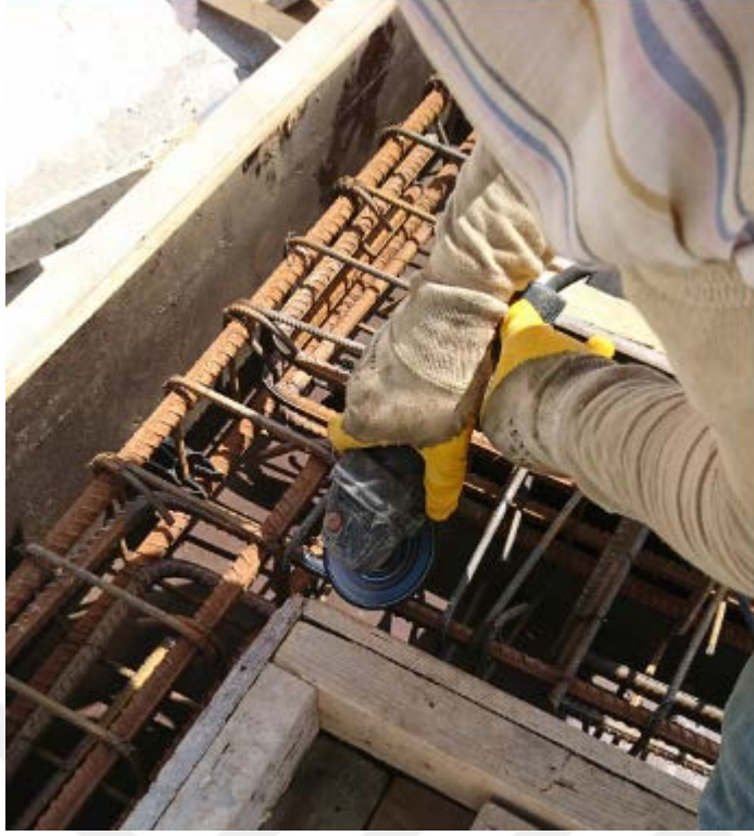
Şekil 3.12. Birim deformasyon ölçerlerin yapıştırılacağı bölgeye zımpara uygulanması
