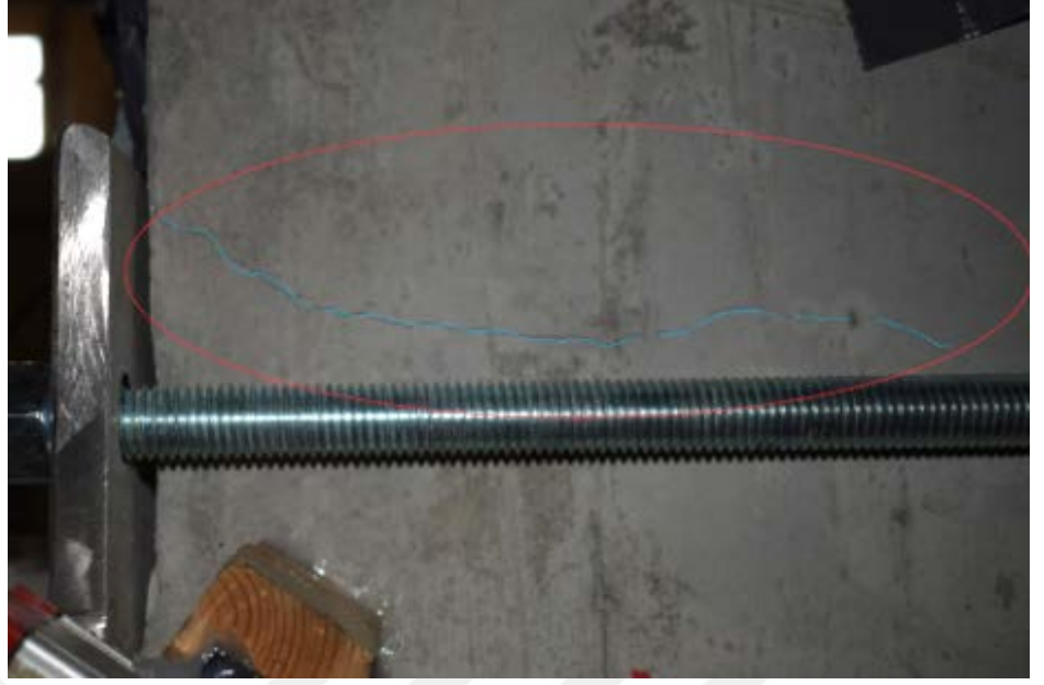
Şekil 4.138.Arka yüz 12 cm'deki eğilme çatlağı görünümü
