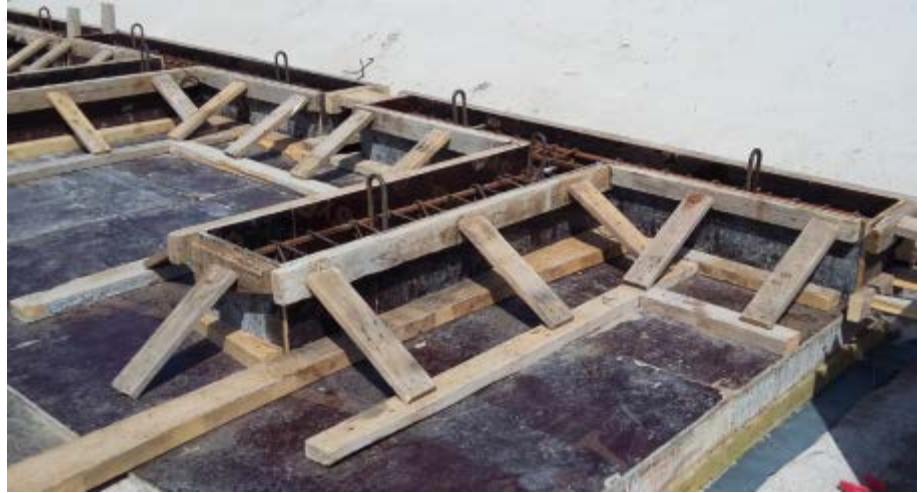
Şekil 3.11. Donatı ve kalıpların hazırlanması
