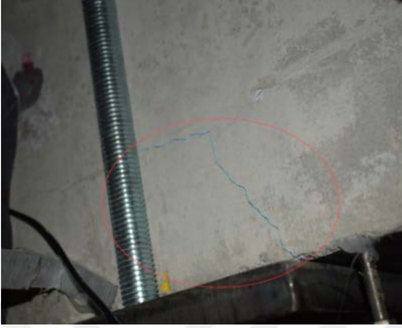
Şekil 4.140.Plaka üzerindeki çatlak
