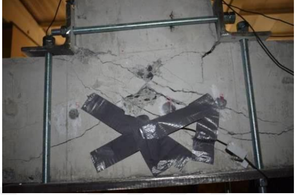
Şekil 4.143.Düğüm noktası arka yüz hasar durumu
