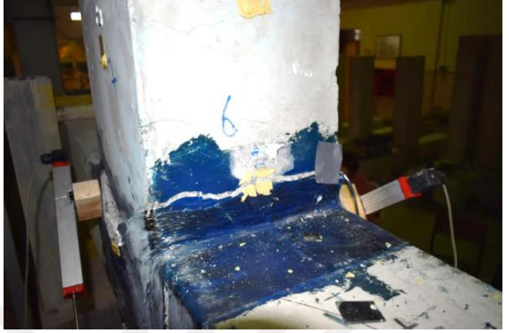
Şekil 4.40.Kiriş sol yüz eğilme çatlakları
