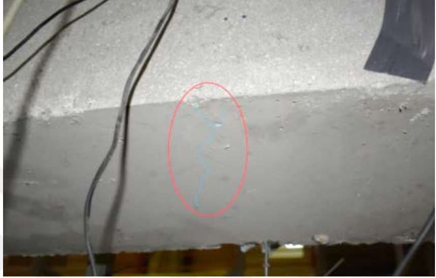
Şekil 4.22.Kolon alt yüz eğilme çatlağı görünümü
