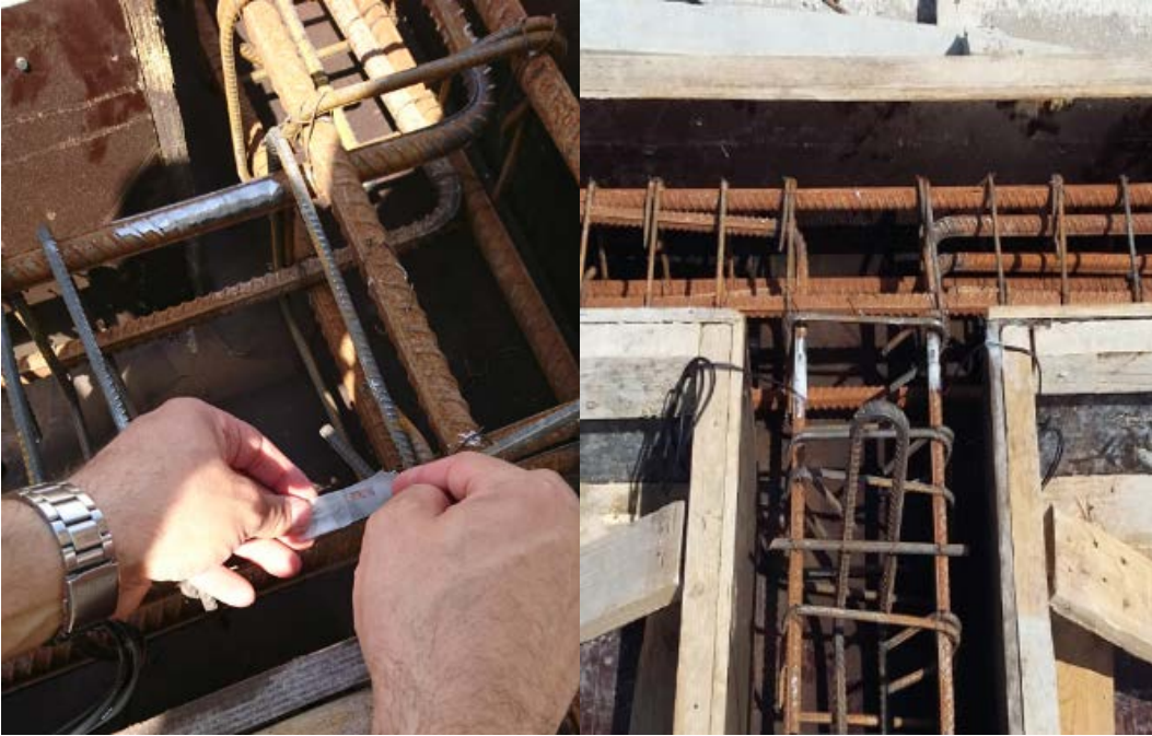
Şekil 3.13. Birim deformasyon ölçerlerin yerleştirilmesi
