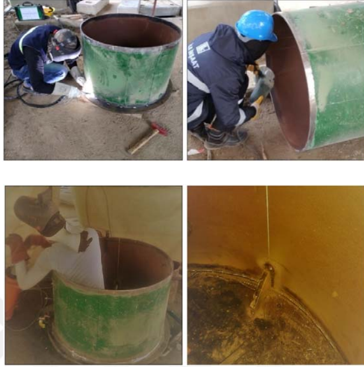
Şekil 3.4: Deney Elemanı-2'nin montajı ve kaynak işleri
