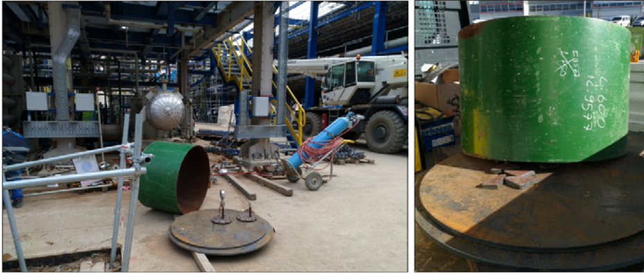
Şekil 3.3: Deney Elemanı-2'nin Star Rafinerisi'ne transferi ve yapımı
