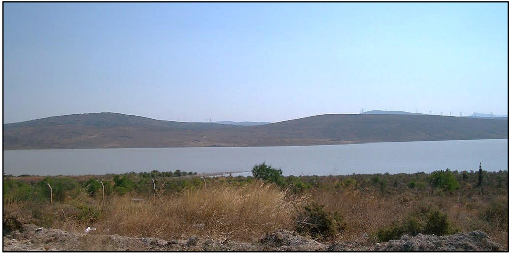
Şekil 3.14: Kutlu Aktaş Barajı (Kaynak: Google Earth Panoramio, 2011)
