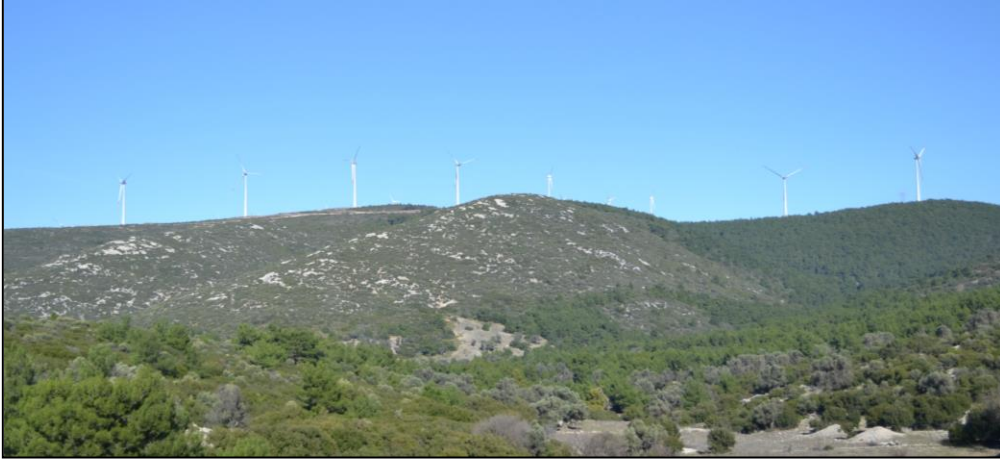
Şekil 4.16 : Karaköy Rüzgar Enerji Santrali (Orijinal, Aralık 2017)
