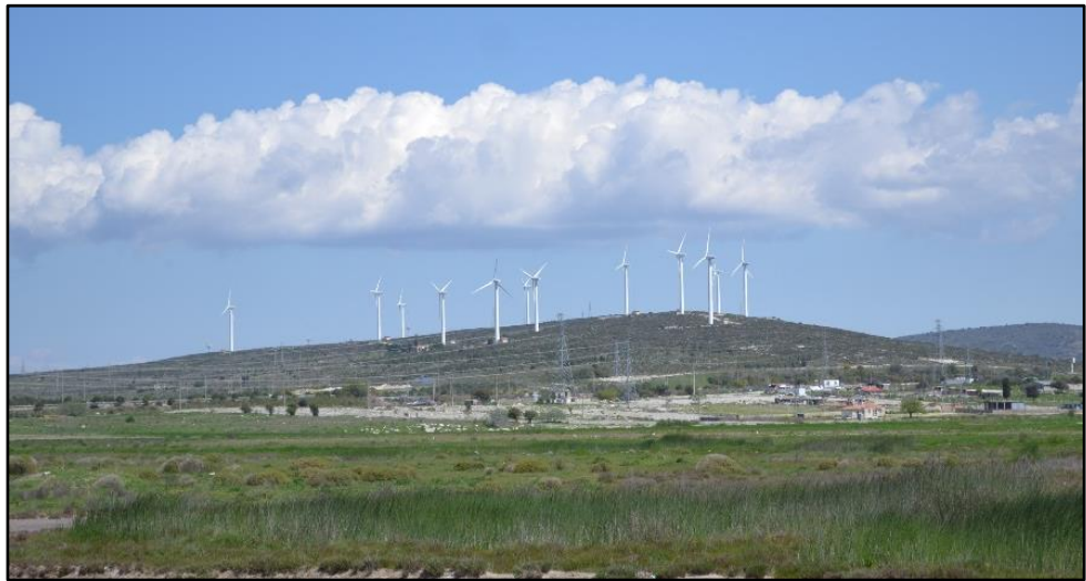
Şekil 3.9: Alaçatı Rüzgar Enerji Santrali (Orijinal, Nisan 2017)
