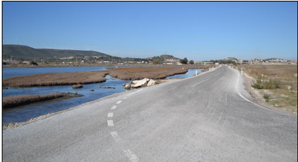
Şekil 4.15 : Karşıyaka Azmağı'nın kıyısında yeni yapılan ve ÇDP'deki "Havalimanı" olarak belirlenen alana ulaşımı sağlayan stabilize yol (Orijinal, Aralık 2017)
