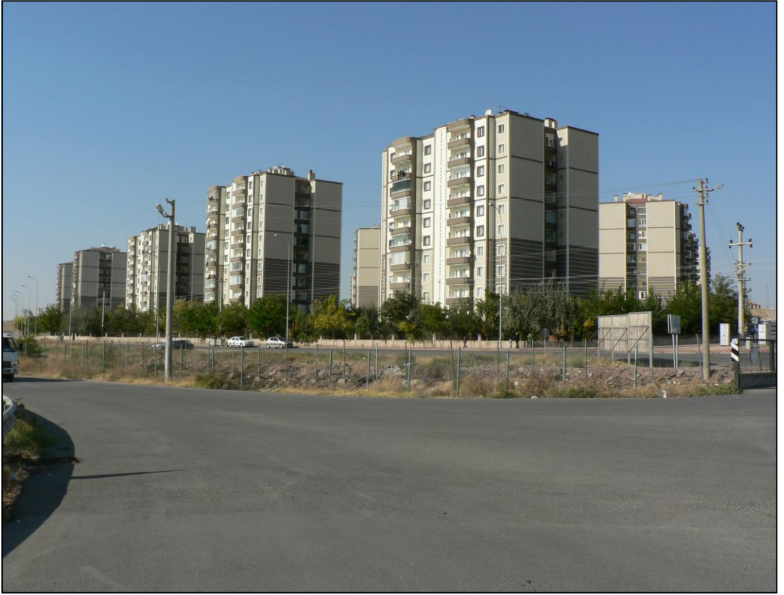
Fotoğraf 3.22. Cumhuriyet Mahallesi Çok Katlı Binaların genel Görünüü, (2013).
