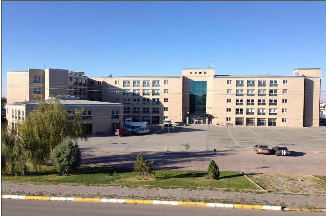
Fotoğraf 3.25. Aksaray Valiliği Ek Binası, (2013).
