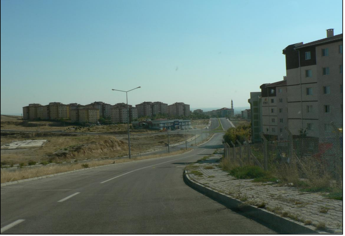
Fotoğraf 3.23. Cumhuriyet Mahallesi Çok Katlı Binaların genel Görünüü, (2013).
