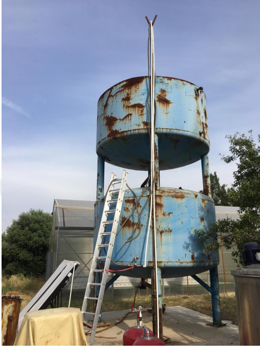
Şekil 3.10 Gazometre ve Tesisat
