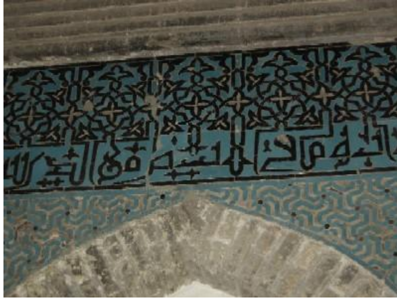
Şekil 4- İnce Minare Medresesi Çini Örneği
