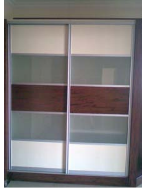
Resim 6.51: Kapakları Sürgü Ray Sistemi İle Çalışan Gardrop Örneği (Değirmişem Mah. G. Muhtarpaşa Bul. No:43)
