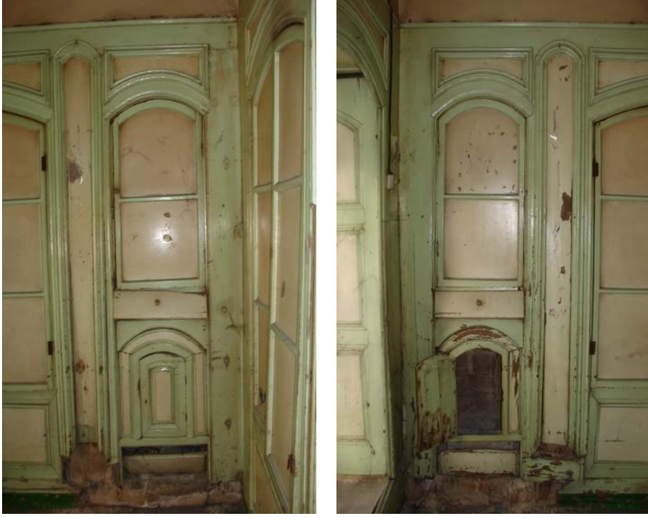
Resim 5.36: Anbar Örneđi (Çekmece altındaki küçük dolap) (Bey Mah. Kayacık Ara Sokak No: 6)
