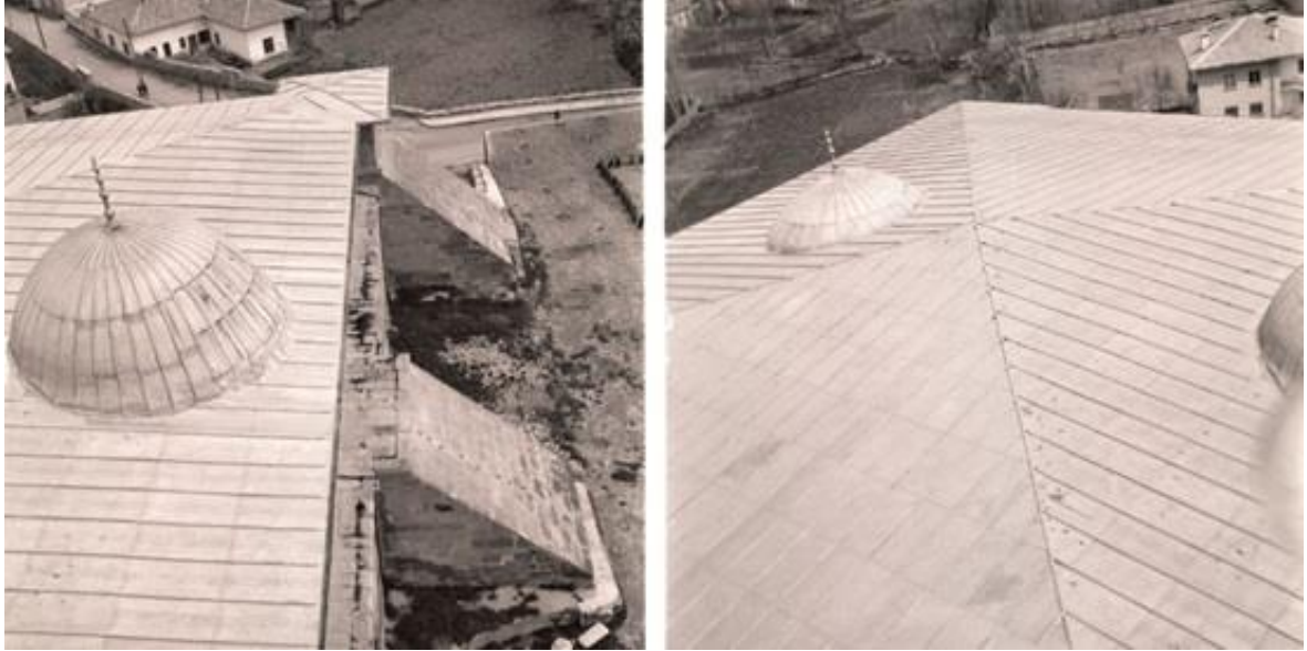
Fotoğraf 3: Ulu Camii'nin üstünün kurşun ile kaplı hali (MFGA)
