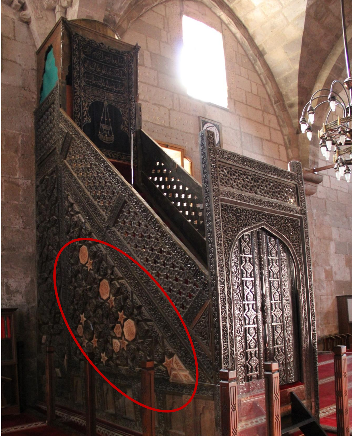
Fotoğraf 23: Minberin sol tarafından eksilen parçalar ve yerine takılan benzerleri (MFGA)
