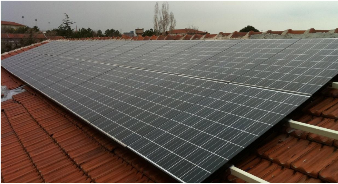
Resim 6.1. Çatıya yerleştirilen 30 adet panelin görüntüsü
